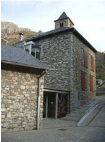
Figura. 25 Centro de Interpretación en Vall de Boi Fuente www.centreromanic.com/centro-romanic
