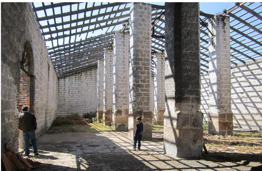
Figura. 52 Estructura de vigas, morillos y cintas en cubierta, vista interior. Fotografía José Luis Navarro
