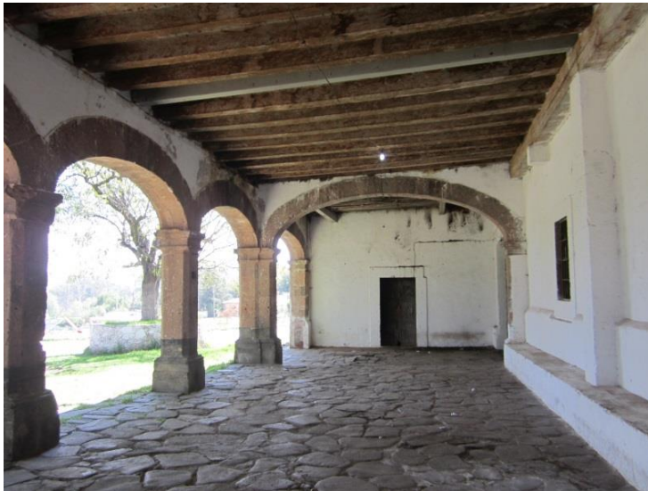
Figura. 34 Pórtico de entrada Hacienda Arroyo Zarco. Fotografía propia
