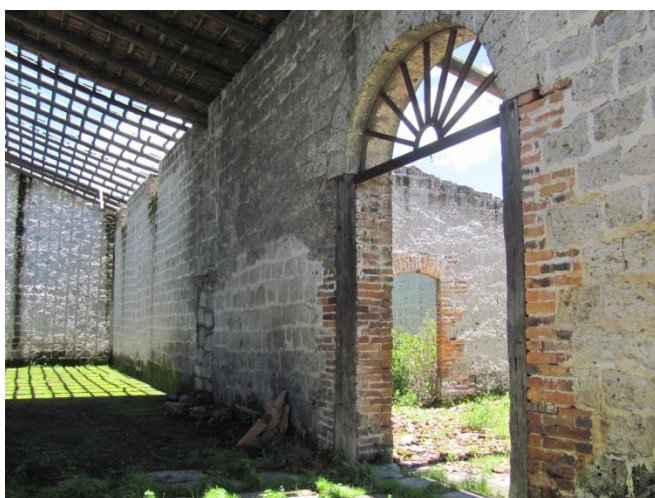
Figura. 51 Muros de sillar de piedra de cantera, detalles en ladrillo rojo. Fotografía Diego Ortiz
