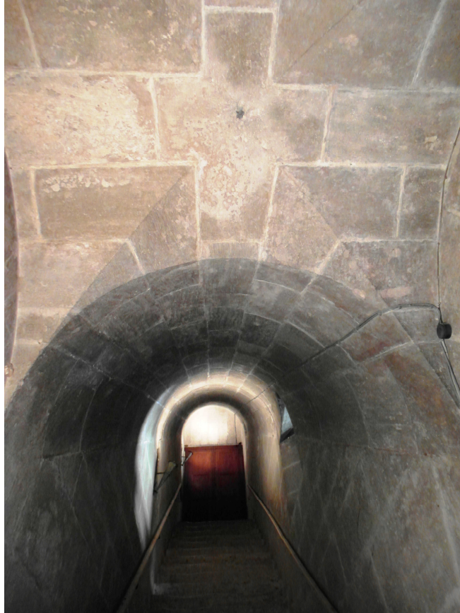
Figura 2.34. Bóveda en decenda de cava de la escalera y bóveda de arista de la meseta.
