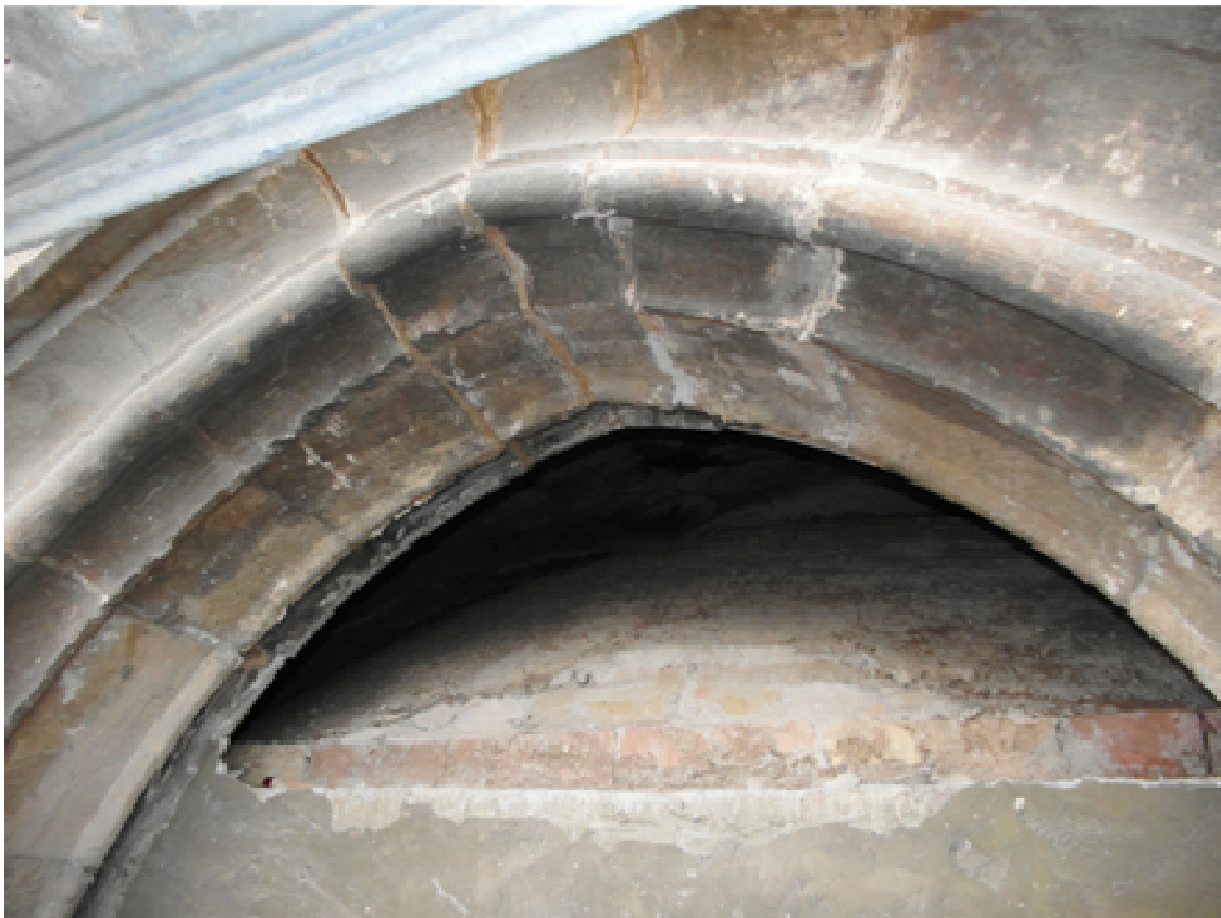
Figura 2.92. Bóveda neoclásica de la capilla de San Sebastián.
