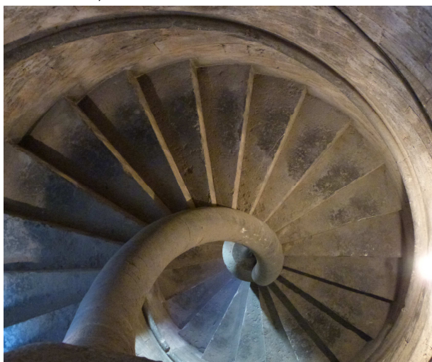
Figura 3.49. Caracol de Mallorca de acceso a la terraza de la capilla Real.
