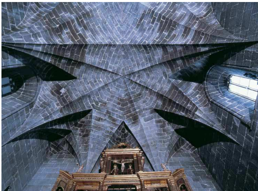
Figura 3.39. Cabecera de la bóveda aristada de la capilla Real.
