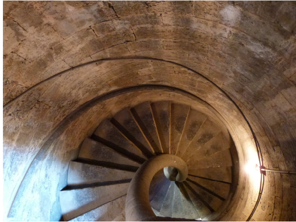
Figura 3.20. Escalera de caracol de Mallorca del segundo tramo
