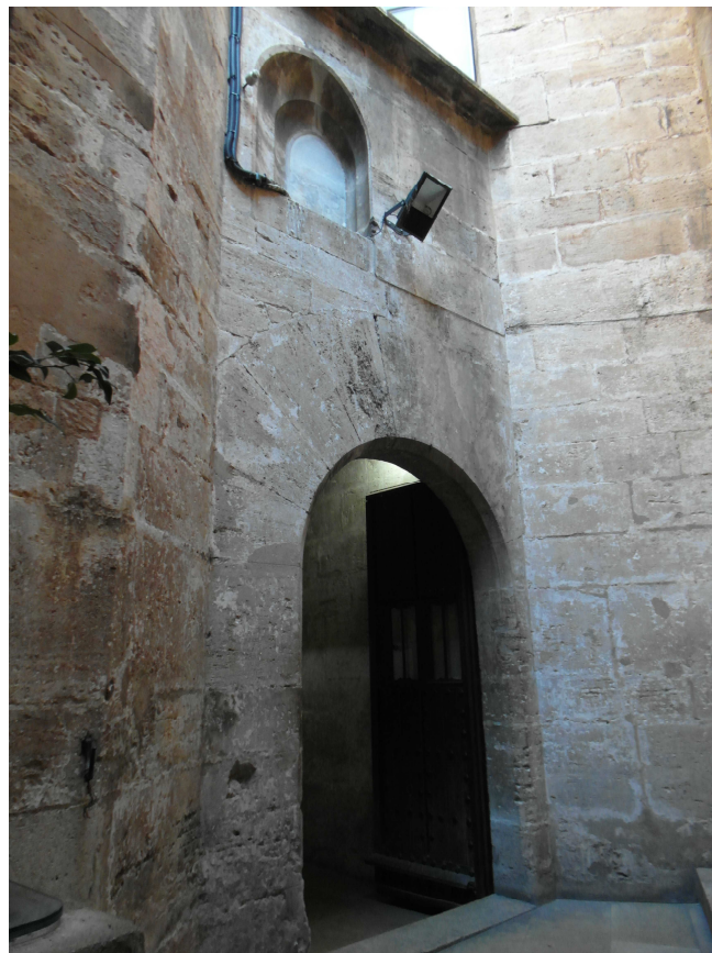
Figura 2.72. Puerta de salida del pasillo de acceso al Micalet y ventana en esviaje de Francesc Baldomar.
