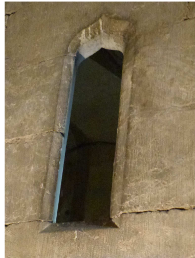
Figura 3.21. Ventana en esviaje que comunica los dos caracoles de la capilla Real.
