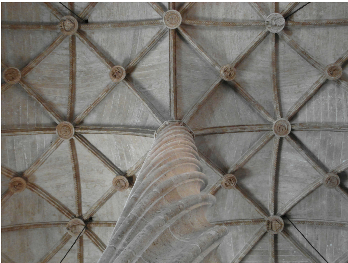
Figura 3.54. Red de rombos sobre las columnas entorchadas de la Lonja de Valencia.
