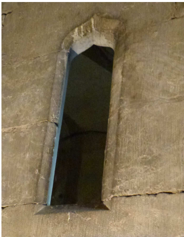
Figura 3.42/3.43. Ventana en esviaje que comunica los caracoles de la capilla Real.
