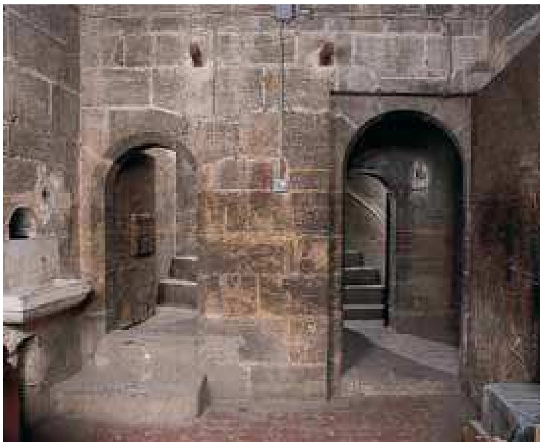
Figura 2.18. Entradas a la escalera de la sacristía. Por la entrada de la derecha se sube a la cubierta y por la de la izquierda se sube a la estancia situada sobre la sacristía.
