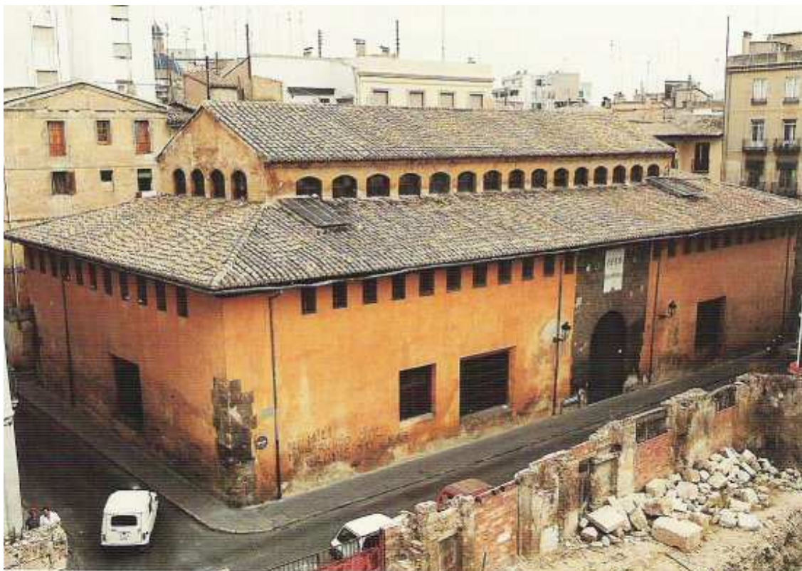
Figura 2.40. Vista del Almudín antes de la última restauración de 1993-96.
