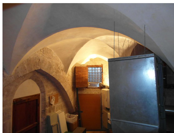
Figura 3.4. Bóveda aristada de la actual sala de calderas del archivo de la catedral de Valencia
