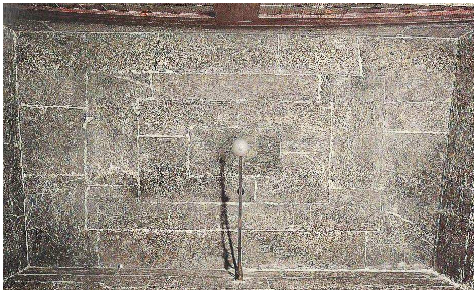
Figura 2.19. Bóveda esquifada sobre la puerta lateral de la capilla Real.
