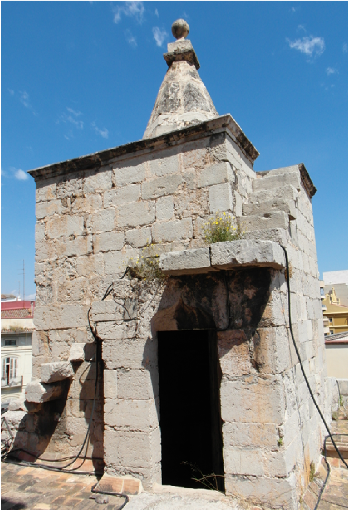
Figura 2.15. Remate de la escalera de caracol de la capilla Real.
