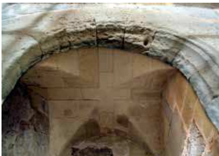
Figura 2.37. Bóveda de arista y arco en esviaje del primer rellano de la escalerilla de acceso al púlpito del lector en el refectorio del monasterio de Santa María de la Valldigna.
