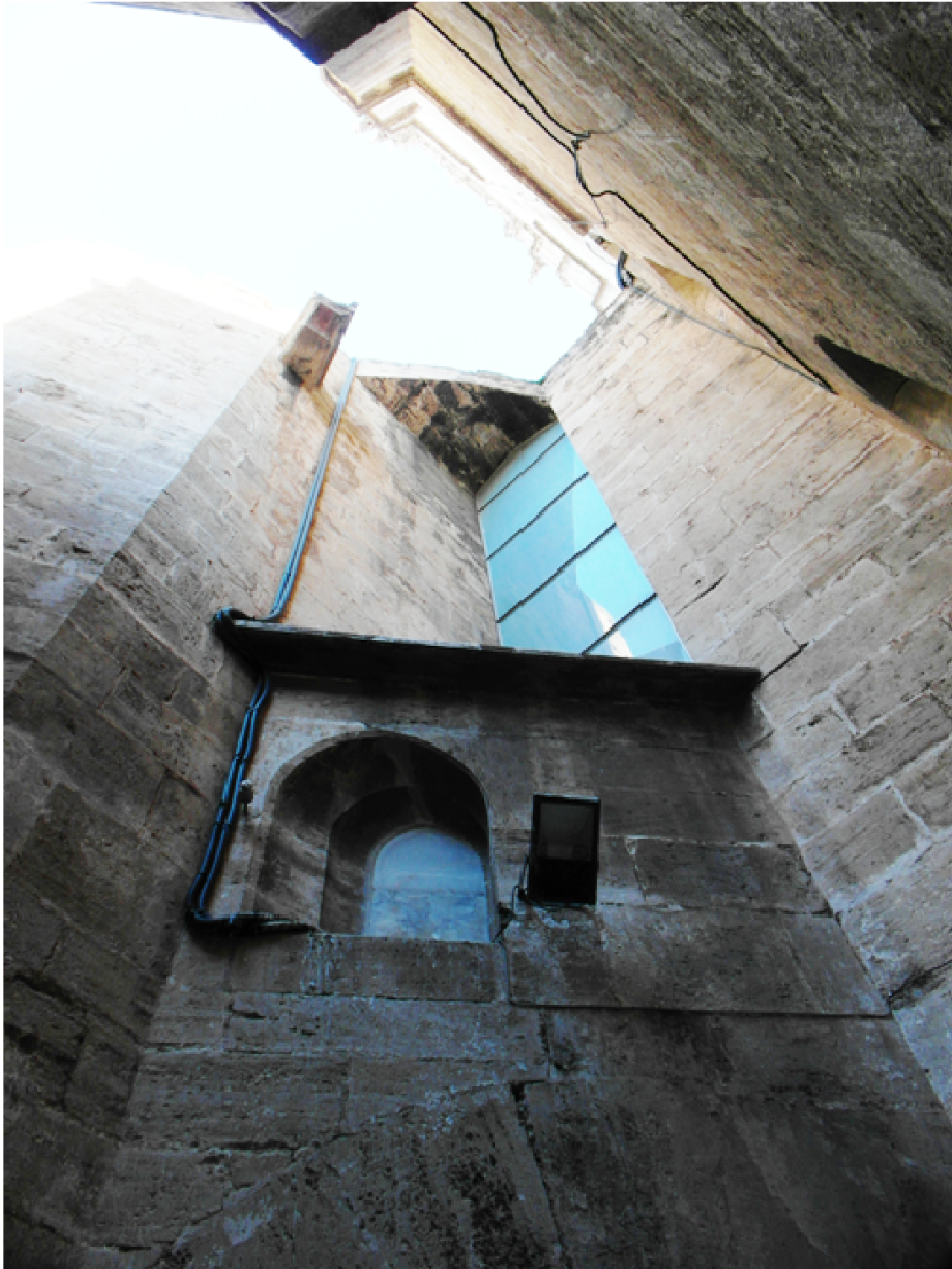
Figura 3.47. Dos ventanas en esviaje en el pasillo de acceso al Micalet y en la capilla de la Trinidad.
