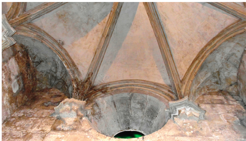
Figura 2.94. Tercerolos de cantería aristada en la bóveda de la primera capilla del paso a la antigua sala Capitular de la catedral de Valencia.
