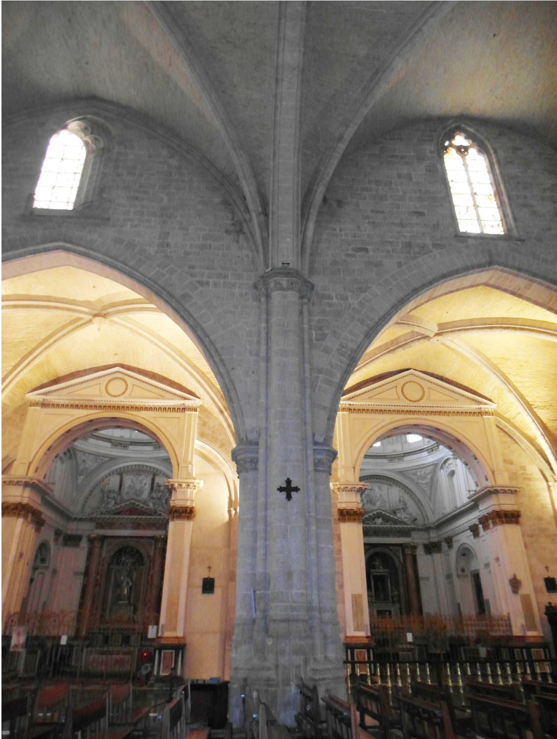
Figura 2.87. Unión entre la Arcada Nova y el tramo anterior de la catedral de Valencia.
