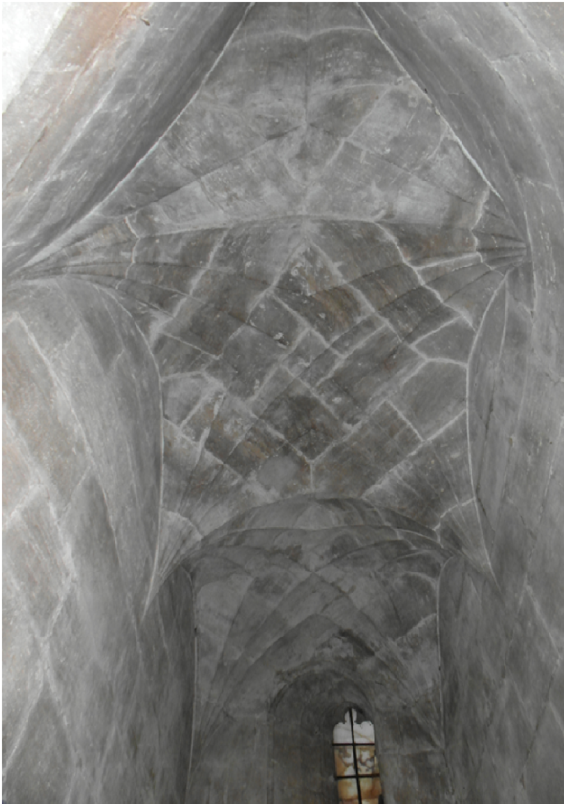
Figura 2.73. Bóveda aristada del pasillo de acceso al Micalet .
