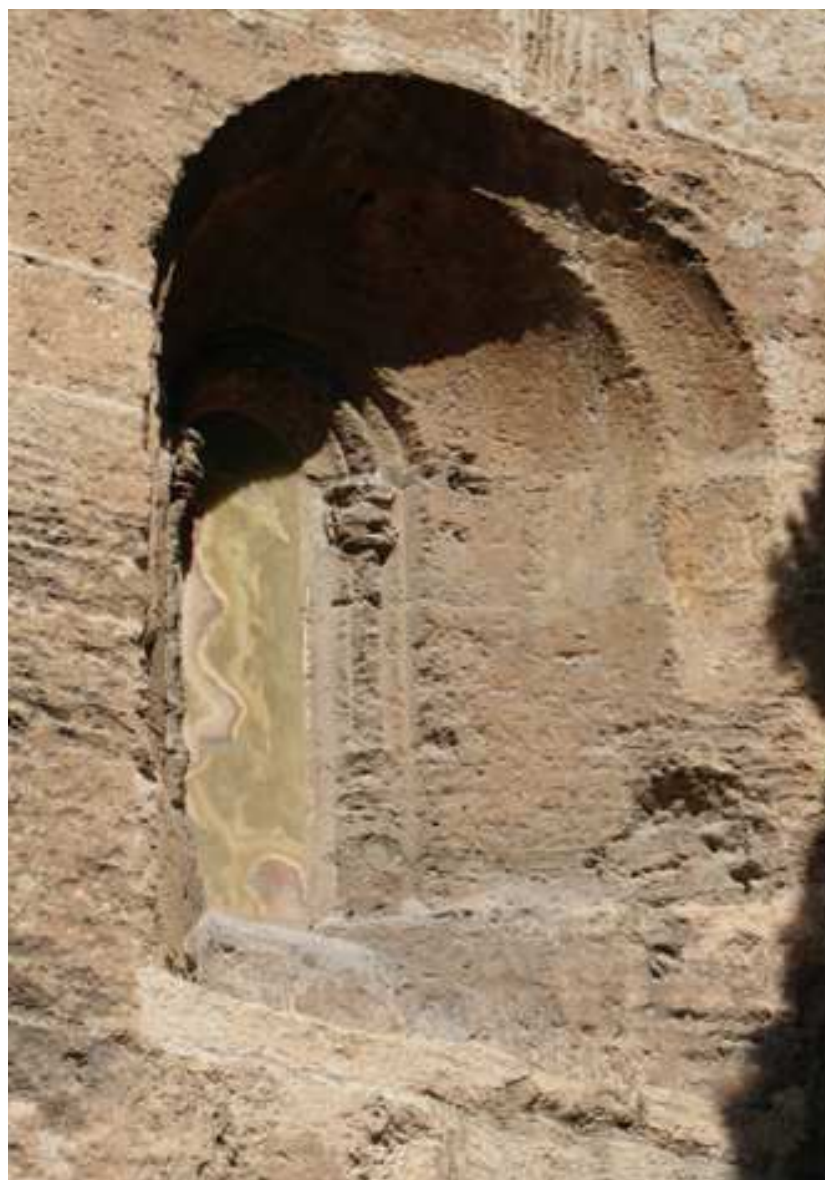
Figura 2.95. Parte exterior de la ventana en esviaje de la capilla de San Miguel Arcángel.
