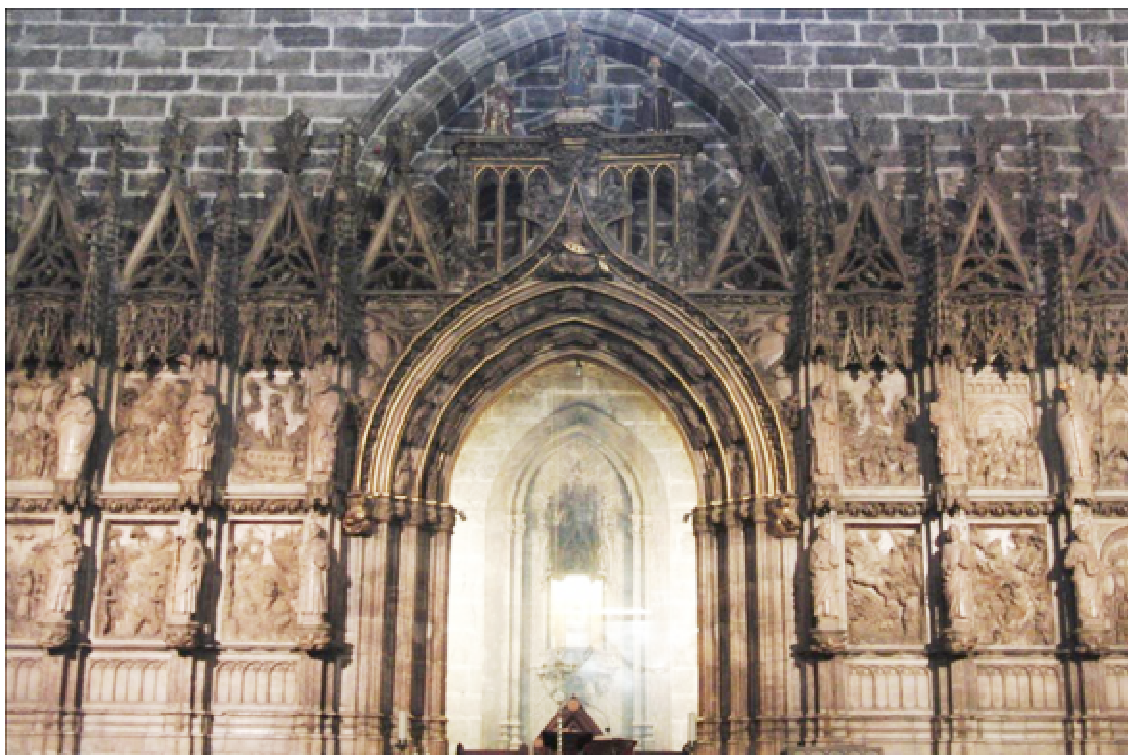
Figura 2.49. Antiguo portal del coro de la catedral de Valencia.
