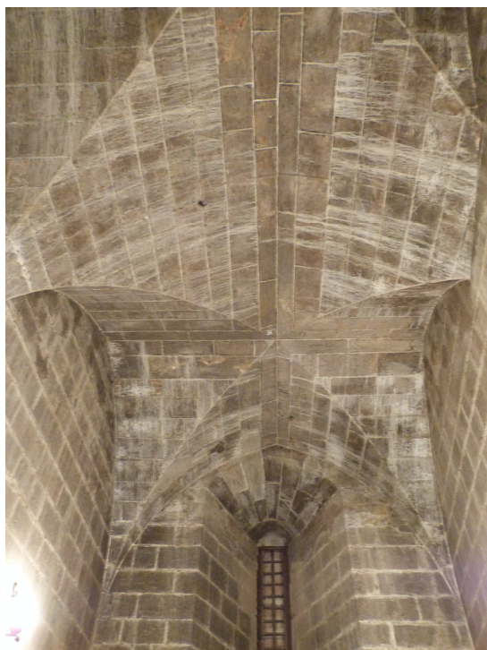
Figura 2.16. Bóveda de arista de la sacristía de la capilla Real.
