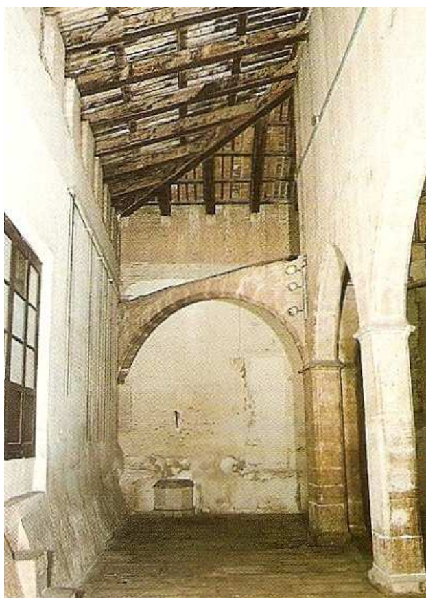
Figura 2.41. Arco en esquina y rincón del almudín antes de la última restauración de 1993-96.
