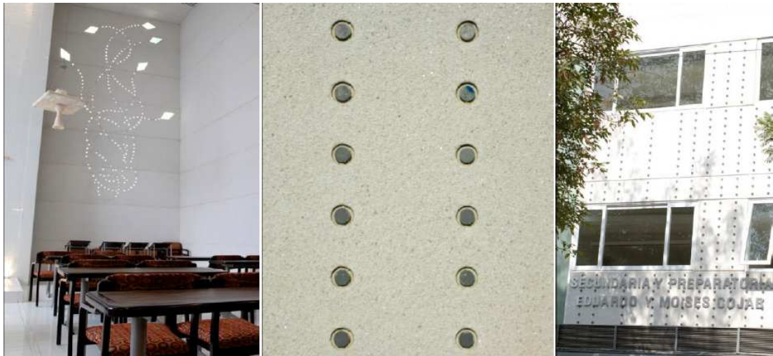
Imagen nº 11: Paneles traslúcidos Fuente: [9]
