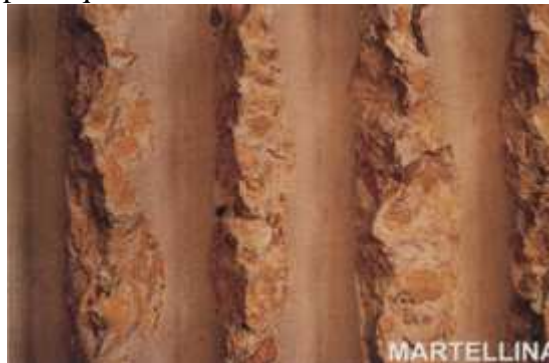
Imagen nº 30. Superficie estriada por encofrado tratada con martelina Fuente: [10]
