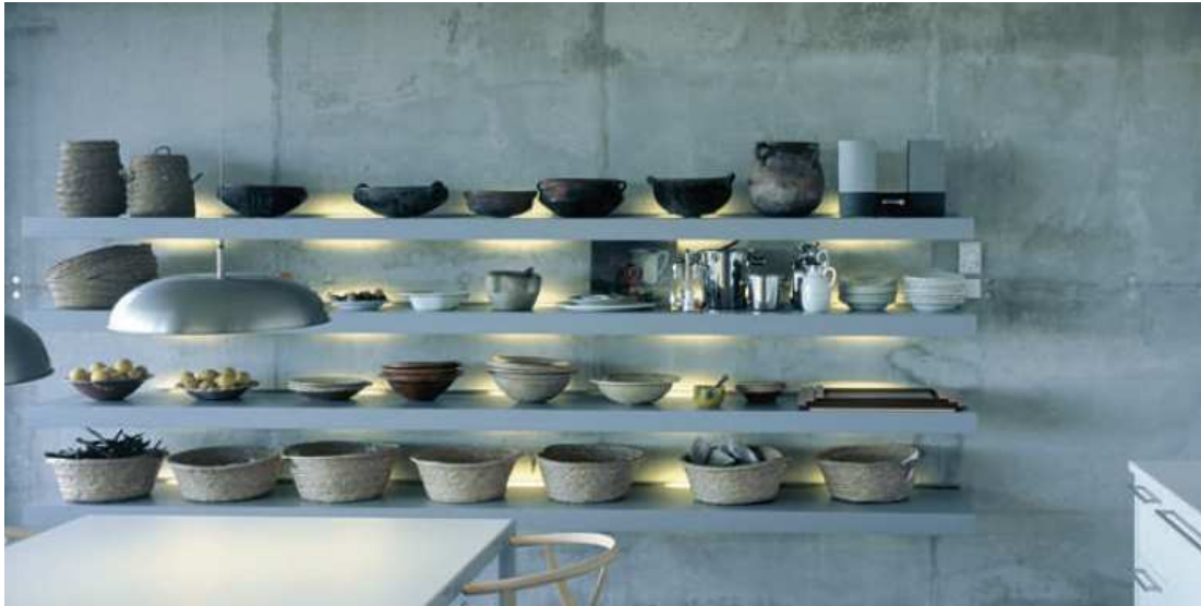
Imagen nº 57 Superficie de hormigón visto en una cocina
