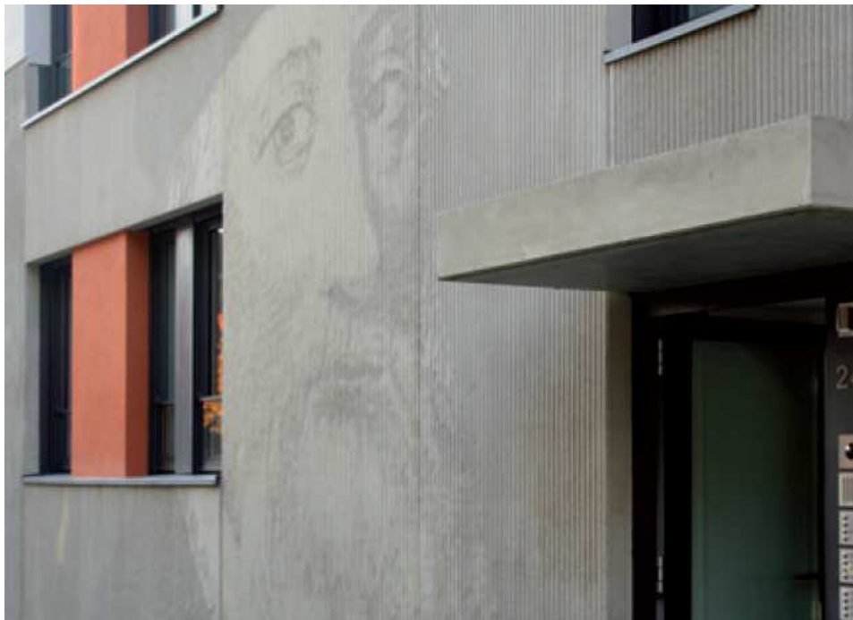
Imagen nº 19 Fotografía materializada en el hormigón de la fachada Fuente: Catálogo RECKLI
