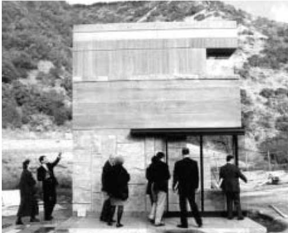
Imagen nº 59 Construcción de prueba para Getty Villas, Malibú, California Fuente: [57]
