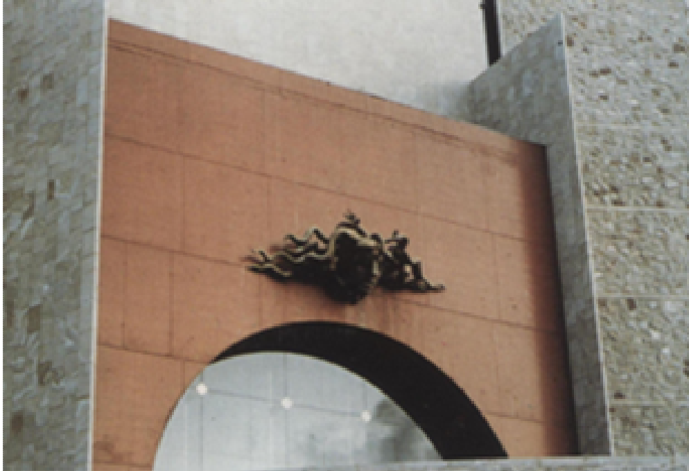
Imagen nº 12. Hormigón velado. Látex acrílico rojo sobre imprimación incolora. Auditorio Alfredo Kraus. Gran Canaria Fuente: [10]
