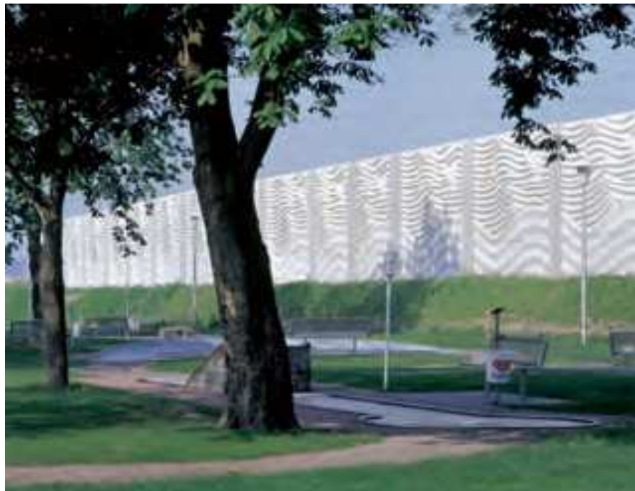
Imagen nº38 aspecto final del paramento vertical Fuente: Catálogo RECKLI
