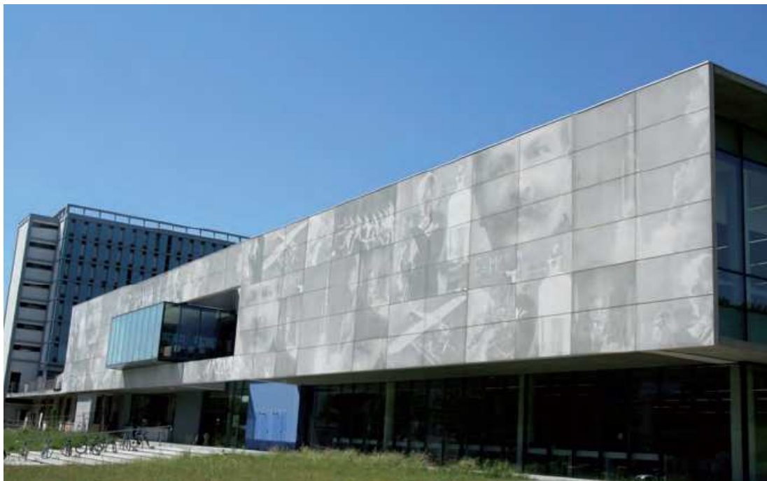
Imagen nº 40 aspecto final de fachada con fotografías materializadas en el hormigón Fuente: Catálogo RECKLI
