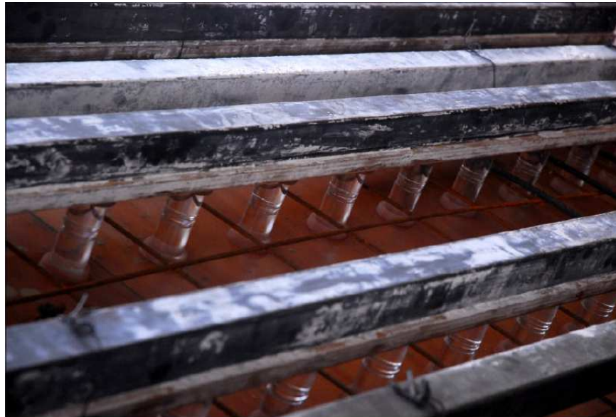
Imagen nº 4 Cilindros anclados para el hormigonado Fuente: [9]
