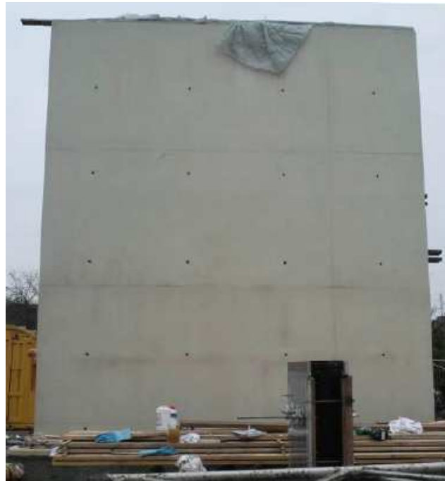
Imagen nº 58 Mock-up test wall in Gifhorn, Germany Fuente: [6]
