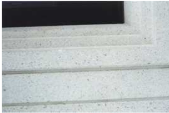
Imagen nº 24. Chorro de arena. Exposición ligera. Véase el aspecto de las esquinas Fuente: [10]
