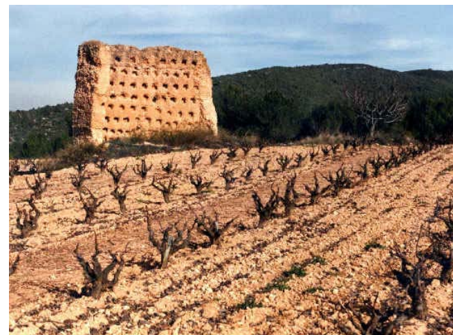
Figura 4.44. Situación del palomar. Imagen antes de la intervención.
