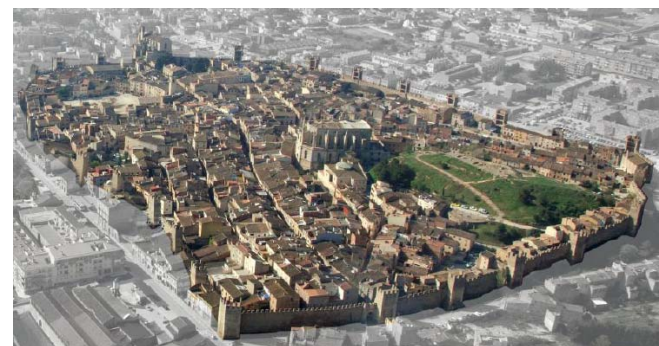
Figura 4.7. Emplazamiento de la muralla.
