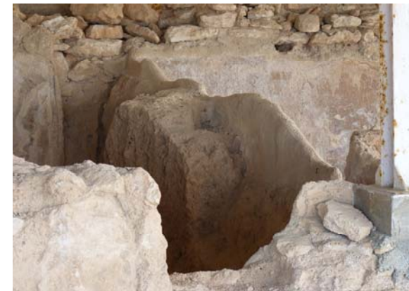
Figura 4.5. Detalles del estado actual de la tapia.
