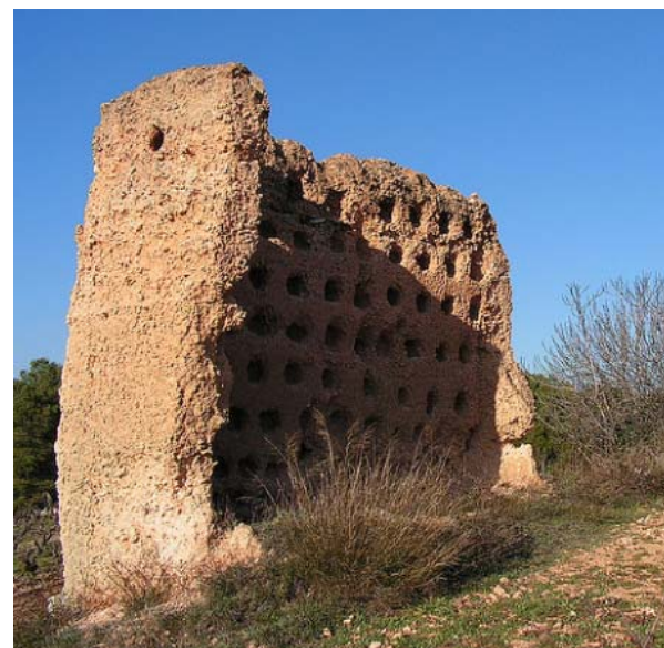
Figura 4.45. Imagen antes de la intervención.
