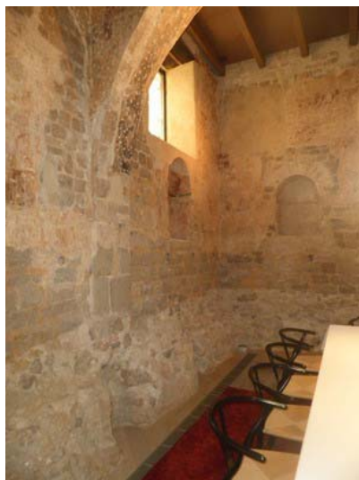
Figura 4.39. Actual biblioteca con la torre de la muralla anexada.
