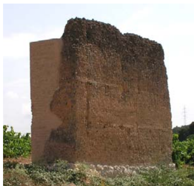
Figura 4.47. Estado actual del palomar.
