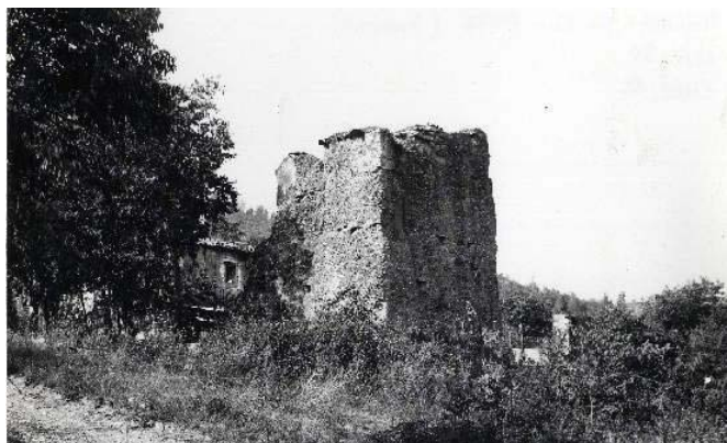
Figura 4.25. Imagen histórica del estado de la torre.
