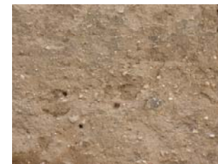
Figura 4.16. Detalle de la tapia de los muros.
