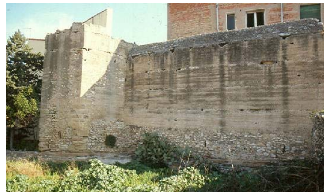
Figura 4.15. Imagen de la muralla antes de la intervención.
