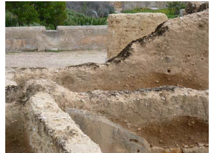
Figura 4.15. Imágenes del estado actual de la tapia.
