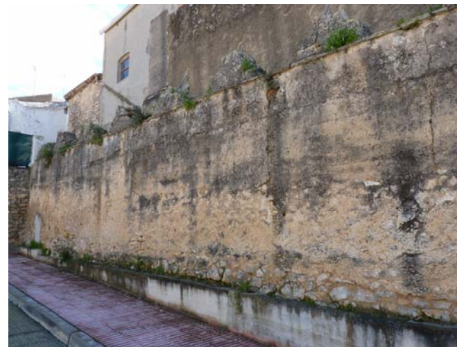
Figura 4.1. Tramo de muralla sin intervenir.
