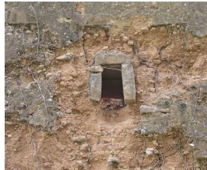
Figura 4.22. Detalle del exterior de la torre.
