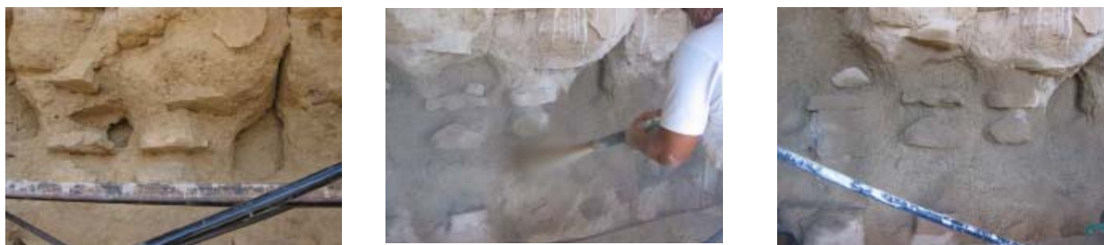
Figura 4.26. Imágenes de la aplicación del silicato potásico.
