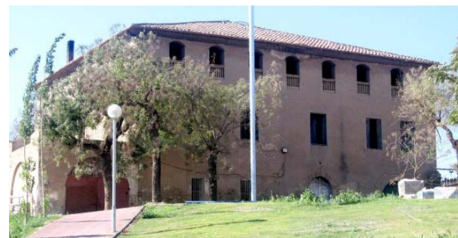
Figura 4.40. Imágenes de la masía antes de la intervención.
