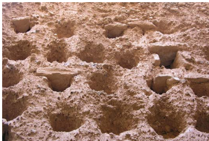
Figura 4.24. Planta de la torre señalando la disposición de las celdas e imagen del detalle.
