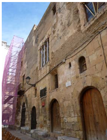
Figura 4.34. Imagen del estado actual del edificio.
