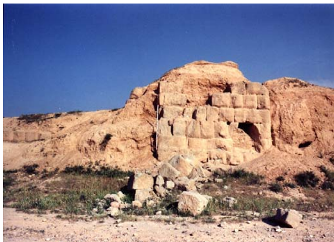
Figura 4.19. Imagen de la torre con base de piedra que presenta un vacío del material.
