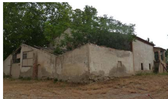
Figura 4.49. Estado actual de las viviendas y establos.
