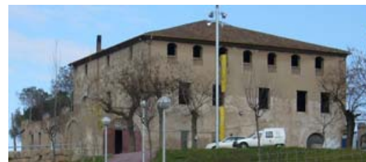
Figura 4.41. Imagen de la masía durante las obras.
