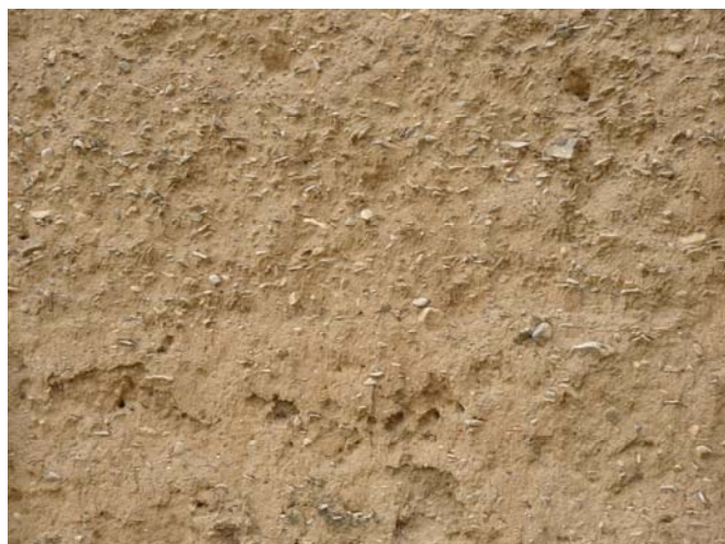
Figura 4.50. Detalle de la tapia del Castell del Remei.
