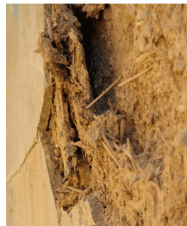
Figura 2.5. Tapia con un revestimiento de tierra arcillosa con paja.
