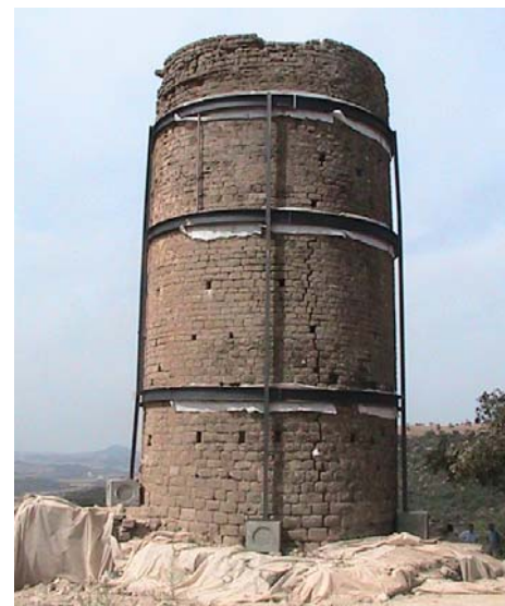
Figura 4.24. Empresillado para garantizar la seguridad.
