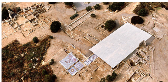
Figura 4.1. Emplazamiento de los restos de tapia en el yacimiento, debajo de la cubierta metálica.
