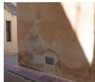
Figura 4.31. Detalle de las humedades actuales.
