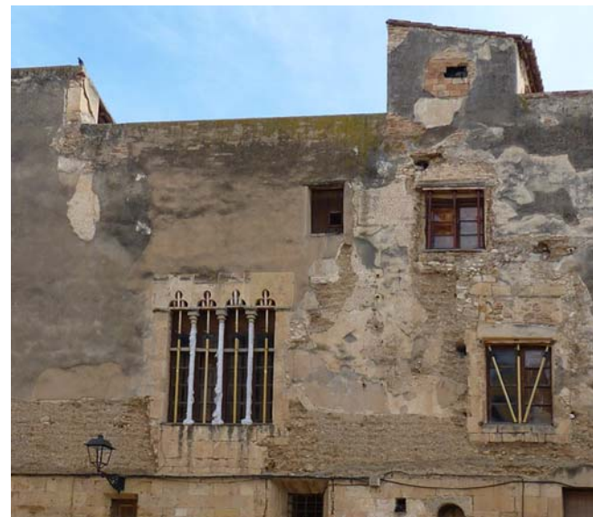
Figura 4.35. Imagen del estado actual del edificio.
