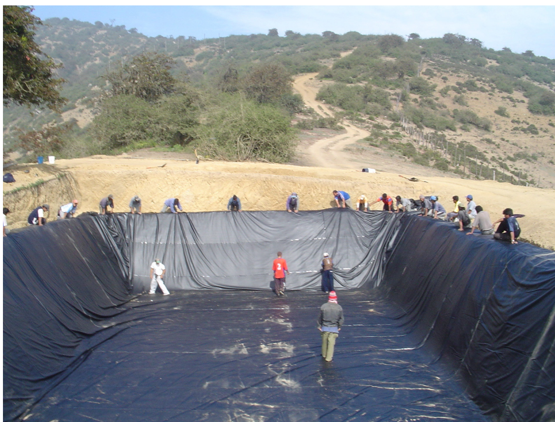
Figura 2-16: Construcción de una balsa de 1 020 m 3 en Lomas de Atiquipa (Perú) (imagen cedida por Percy Jiménez y Luis Villegas (Universidad Nacional de San Agustín de Arequipa-Perú))
