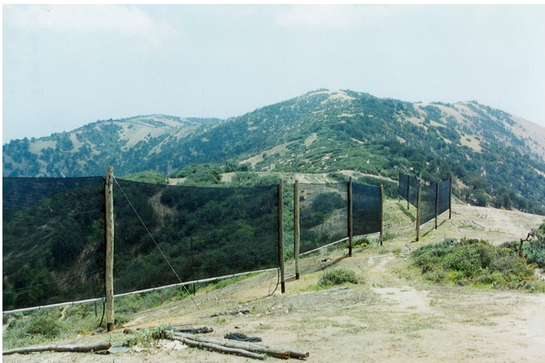
Figura 2-15: Vista del sistema de captación de niebla instalado en Lomas de Atiquipa (Perú) (imagen cedida por Percy Jiménez y Luis Villegas (Universidad Nacional de San Agustín de Arequipa-Perú))
