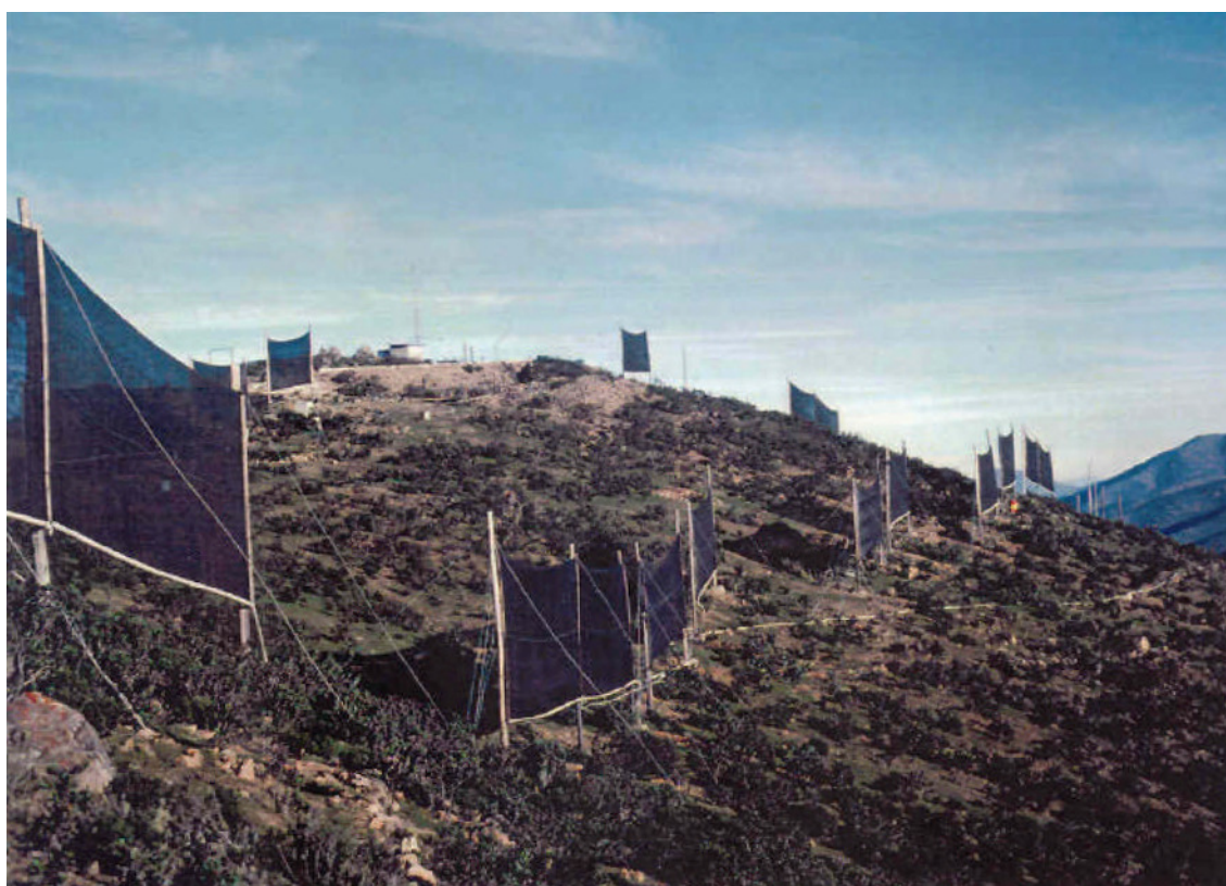
Figura 2-11: Captadores instalados en El Tofo para abastecer a la aldea de Chungungo (Chile) (Schemenauer and Cereceda, 2000)
