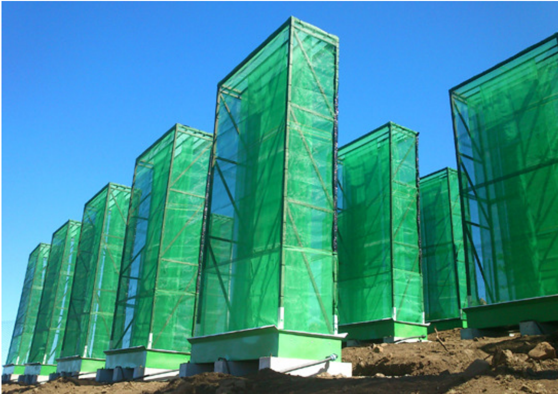
Figura 2-6: Colectores de niebla NRP 3.0, modelo Garoé ( www.innovaspain.com/detalle_noticia.php?noticia=1899 )
