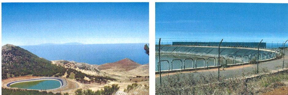
Figura 7-7: Balsa de uso agrícola instalada en Teno Alto (Tenerife), cuya valla protectora se cubrió con malla para la recolección de agua de niebla y que se utilizó como aporte suplementario al llenado de la balsa (Marzol, 2005)
