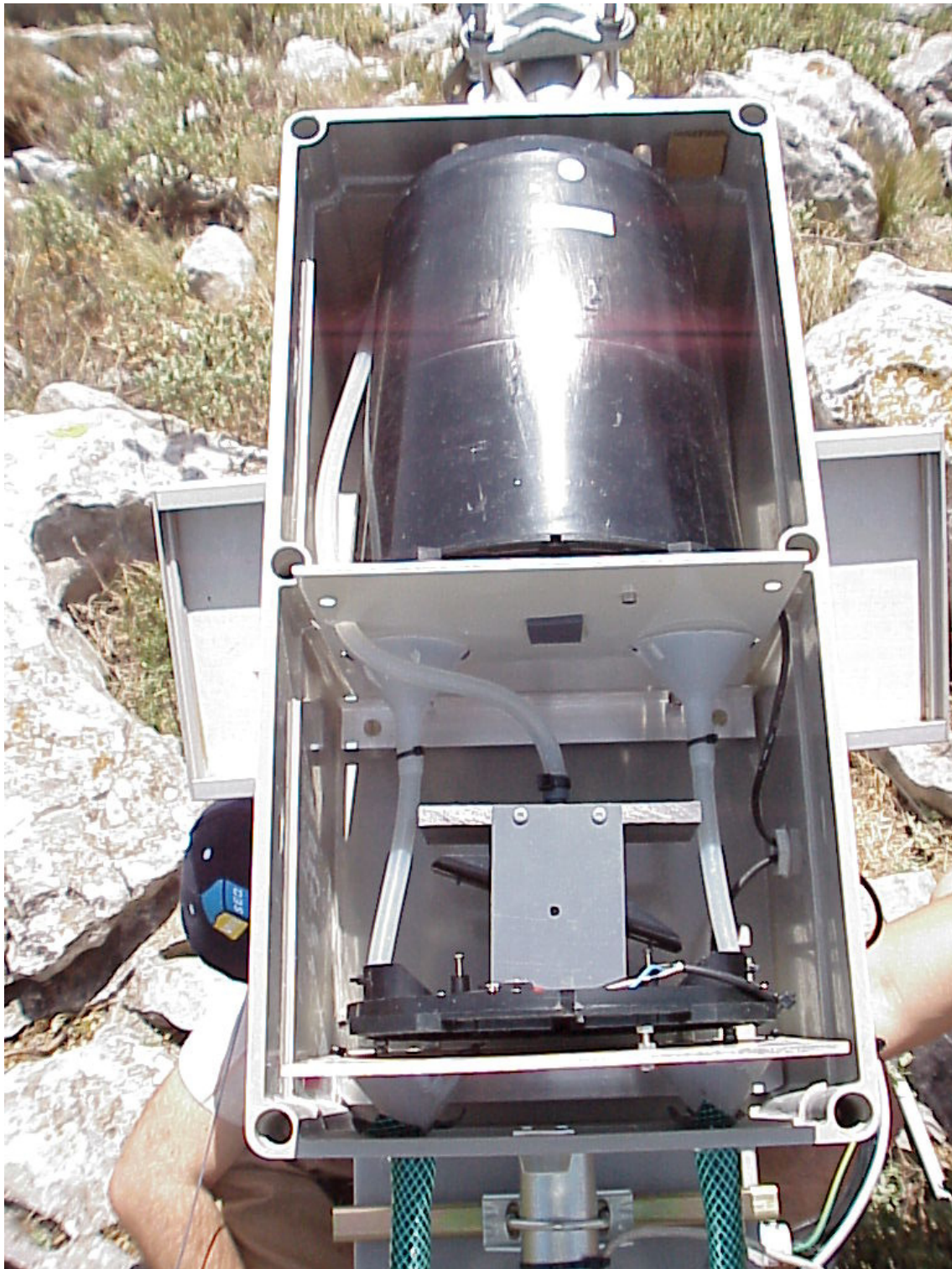
Figura 3-7: Caja intemperie, que contiene dos pluviómetros, uno para la medición del volumen de agua capturada por el colector de niebla (arriba) y otro para la medida de la precipitación (abajo). Una vez contabilizada, el agua es conducida hacia el exterior a través de los embudos y mangueras de desagüe
