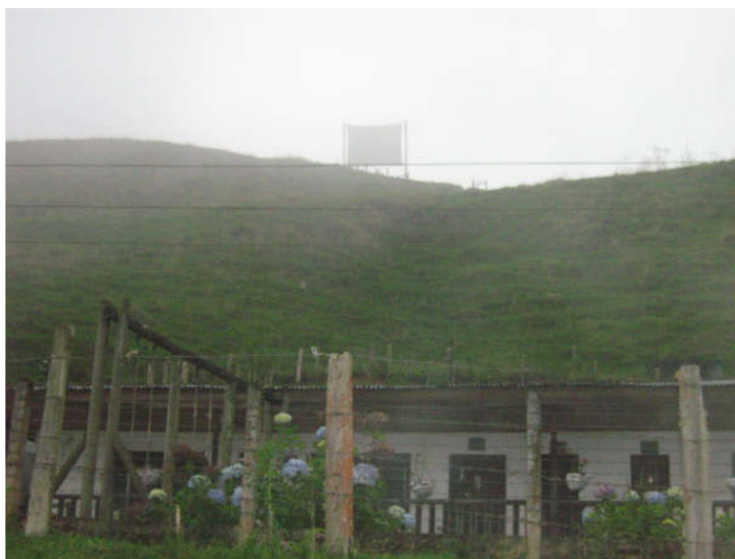
Figura 2-13: Captador de niebla LFC instalado sobre la escuela rural de Frisoles (imagen cedida por José Manuel Molina (Universidad del Estado de Colorado-USA))
