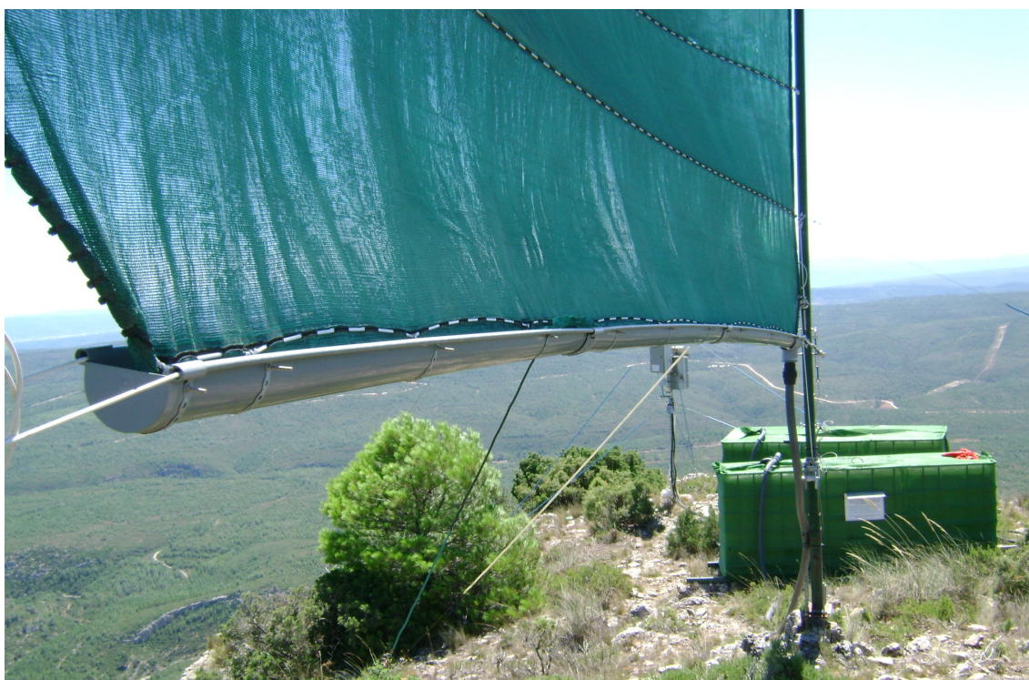
Figura 3-12: Detalles del colector de niebla de tipo LFC instalado en Machos (Ayora, Valencia): malla captadora, canaleta para la recogida de agua y sistema de conducción de agua hasta los depósitos situados al fondo
