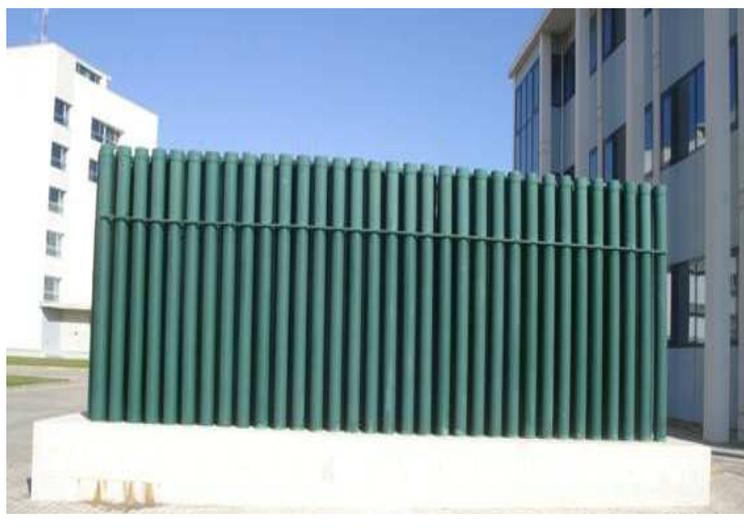
Figura 2.11: Pantalla acústica formada por redes de dispersores aislados. Esta pantalla está situada en el Campus de la Universitat Politècnica de València [11].
