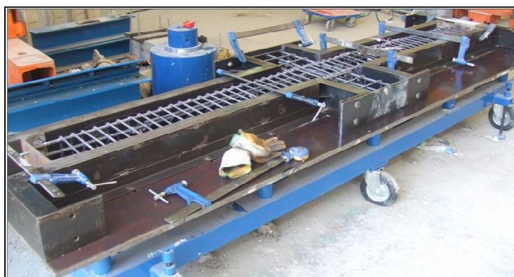
**Figura 4.15** Armadura en el encofrado auto-vibrante preparado para el hormigonado.
