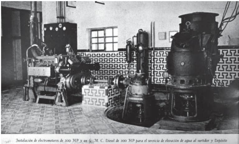
Instalación de electromotores de 300 HP y un G. M. C. Diesel de 300 HP para el servicio de elevación de agua al surtidor y Depósito
