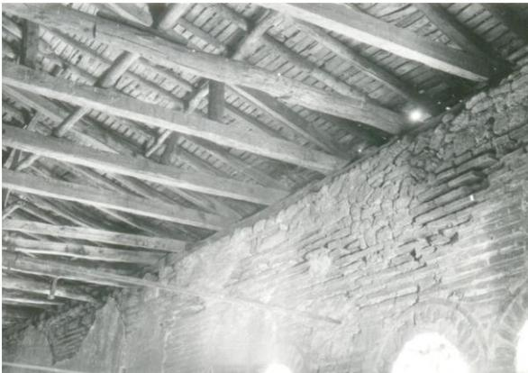
Fig. VI-15: El sistema de la cubierta en el exonártex.
