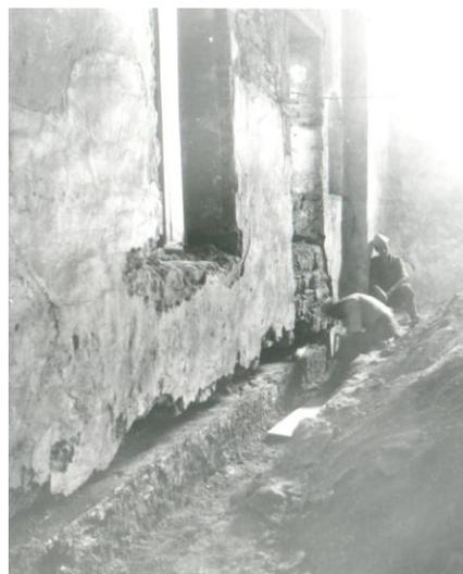
Fig. VI-40: Elaboración de zuncho de hormigón armado, muro norte del naos.
