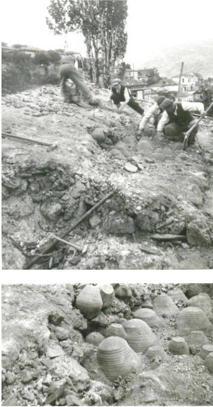
Fig. VI-41: Recipientes de cerámica bizantina embebidos en el relleno con el fin de disminuir la carga de la bóveda.
