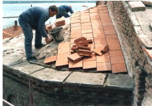
Fig. VII-10: Sistema de ventilación de la cubierta del ábside central elaborado con bloques huecos de cerámica.
