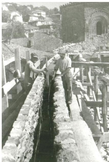
Fig. VI-46: Elaboración de zuncho de hormigón armado en el remate del muro oeste del exonártex.
