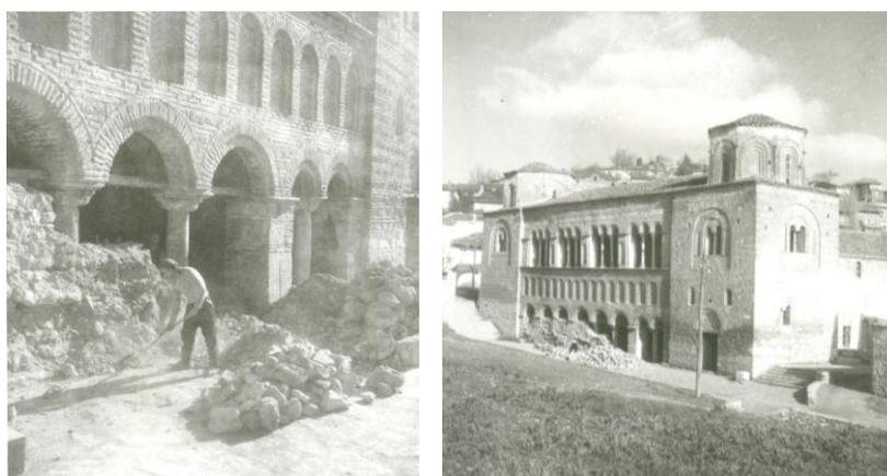
Fig. VI-61: Eliminación de la terraplén que cubría la fachada oeste del exonártex.
