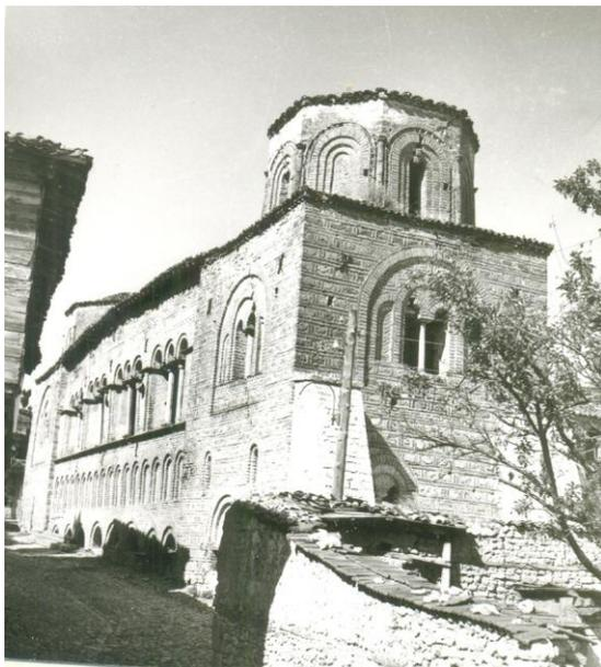
Fig. VI-03: Estado del exonártex antes de su restauración. Se puede observar la inclinación de la fachada oeste.
