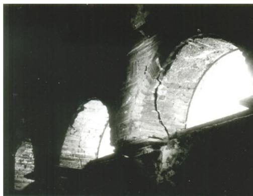
Fig. VI-13: Aparición de agrietamiento de los arcos en el pórtico del exonártex.
