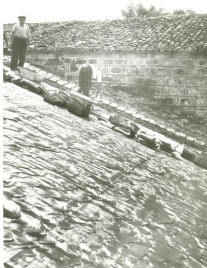
Fig. VI-42: Elaboración del tejado embebiendo las tejas en una capa de arcilla.
