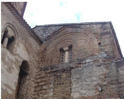
Fig. IV-19: Reconstrucción turca del sistema de cubiertas en el nártex y exonártex. Elevación de los tímpanos mediante una fábrica simple. S. XV-XVI.
