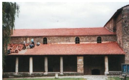
Fig. VII-11: Instalación de la cubierta de tejas mediterráneas nuevas en el pórtico norte.
