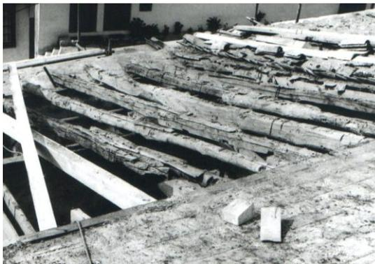
Fig. VII-08: Estado anterior de la construcción de madera de la cubierta en la nave sur del naos.
