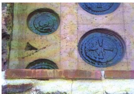
Fig. VII-20: Fallos constatados en la obra de las transennas: huellas del encofrado y armadura vistas, tono no homogéneo.
