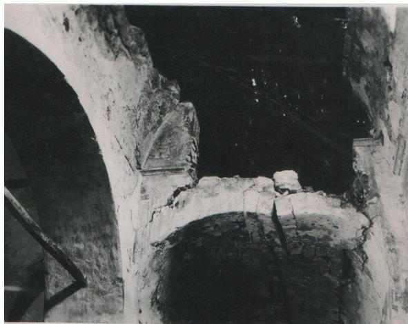
Fig. V-06: Vista de la bóveda de cañón de la nave sur, parcialmente derrumbada, y la bóveda agrietada del diaconicón. Estado en 1935.
