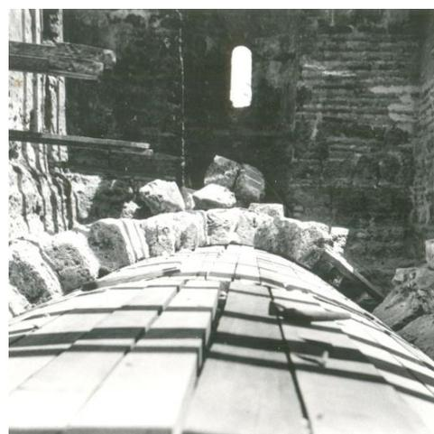
Fig. VI-28: Trabajos preparativos. A: Deshabilitación de la conexión entre el muro sur y la bóveda y B: Desmontaje de la bóveda en el diaconicón.
