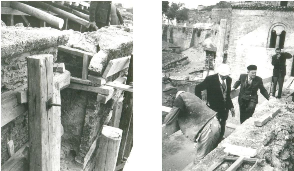
Fig. VI-36: Enderezamiento del muro sur del naos. A: rotación del primer fragmento completa y B: Ferdinando Forlati y Bastianello Romano revisando la primera fase de las obras acabada con éxito.
