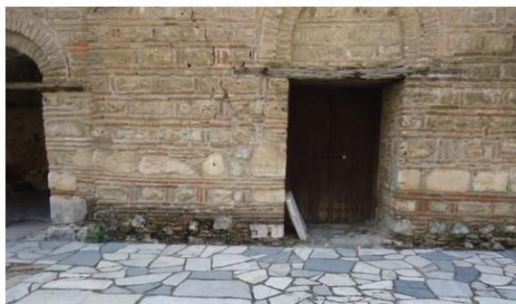
Fig. VIII-02: Estado actual (2014). Daños de humedad, fachada oeste del exonártex.
