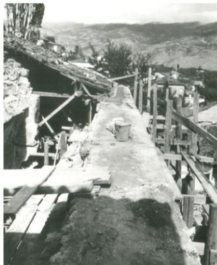
Fig. VI-37: Enderezamiento del muro sur completo.
