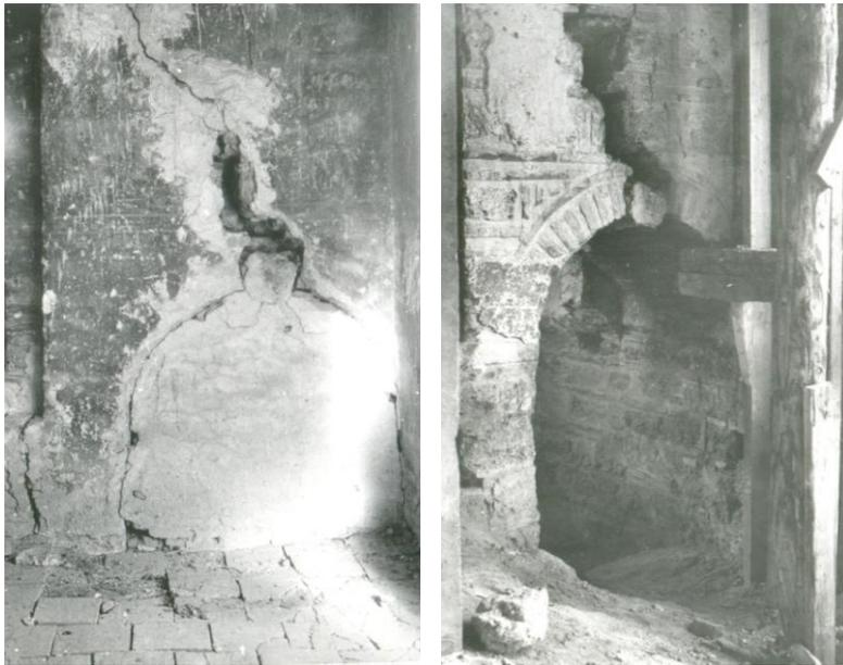
Fig. VI-02: Grietas profundas en el interior del exonártex, torre sur.
