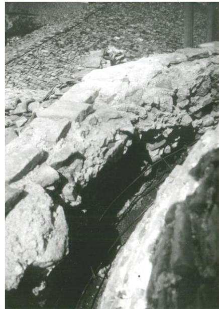
Fig. VI-49: Elaboración de zunchos de hormigón armado tanto en las bases de los tambores como en los arranques de las cúpulas de las torres laterales del exonártex.
