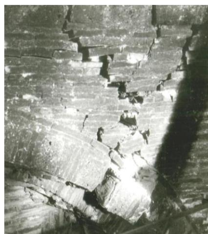
Fig. VI-14: Daños estructurales de la planta alta del exonártex.
