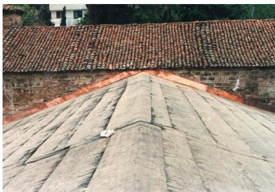
Fig. VII-09: Vista de la cubierta del naos con el aislamiento hídrico y los bordes y goterones de cobre instalados.
