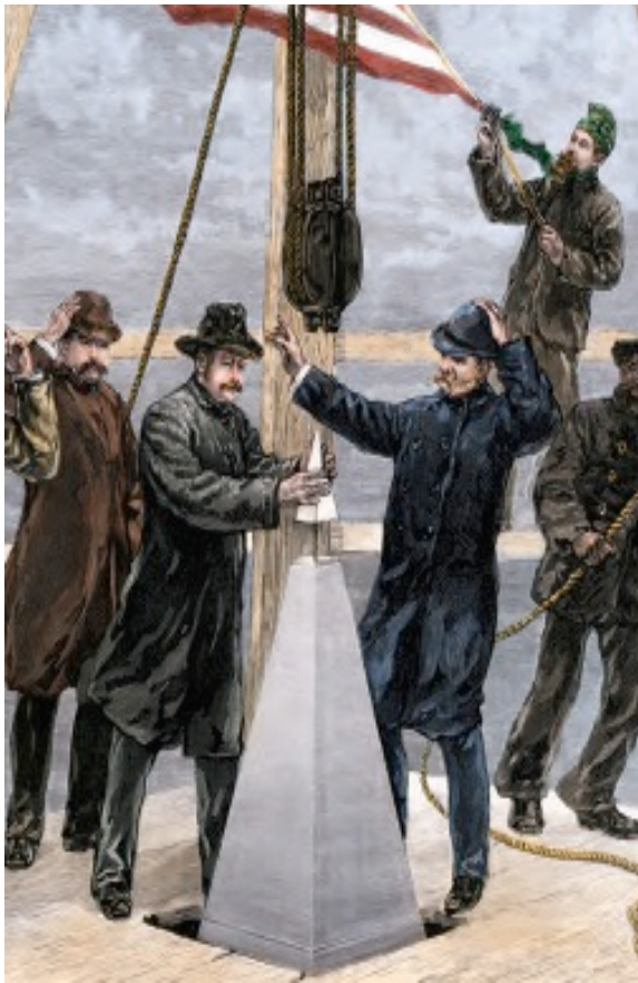
La instalación de la cúpula de aluminio fue un asunto exclusivamente de hombres
