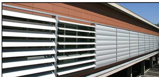
Figura 270: (1) Pérgola de lamas orientables, tipo brise-soleil motorizado. (2) Sistema brise-soleil de lamas regulables horizontales
