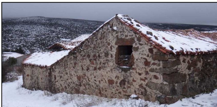
Figura 201: Vivienda con muros de piedra. Sierra de Gredos (Ávila) Fuente: Martín 2013
