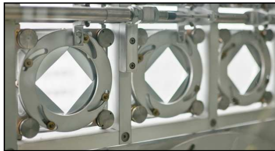
Figura 273: Diafragmas mecánicos de acero. Celosía fachada Fuente: Duque 2013
