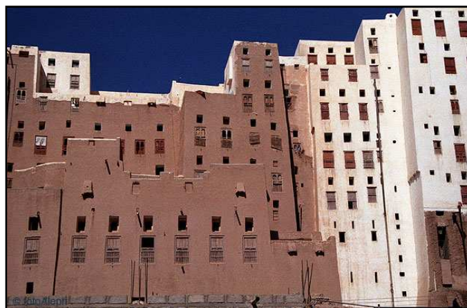
Figura 204: Edificios de adobe en Shibam (Yemen)
