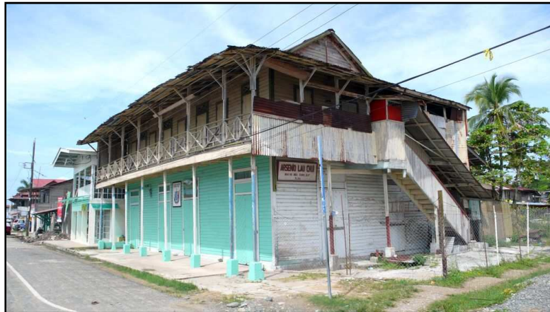
Figura 160: Construcción de madera en Bocas del Toro (Panamá)
