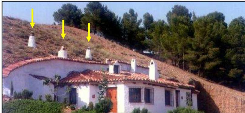
Figura 175: Chimeneas de aireación. Casa-cueva (Granada)
