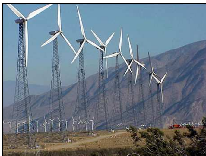
Figura 224: Proyecto de energía eólica. Mohave (Arizona)
