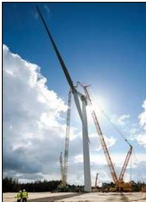
Figura 226: Aerogenerador para abastecer a 6.000 hogares Fuente: Merino 2012
