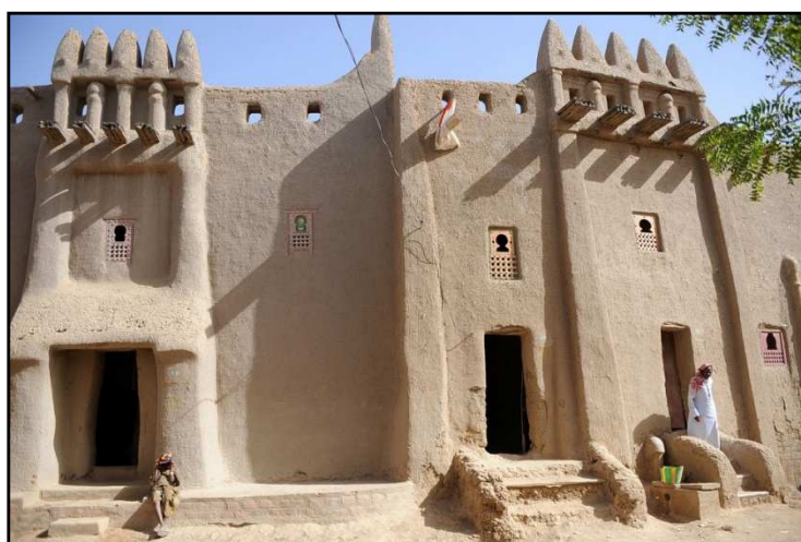
Figura 103: Edificio de barro en Djenné
