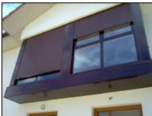
Figura 268: Persiana de aluminio perfilado rellena de poliuretano (Donosti)
