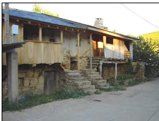
Figura 213: Edificio de dos plantas. Establo en planta baja y vivienda en planta primera
