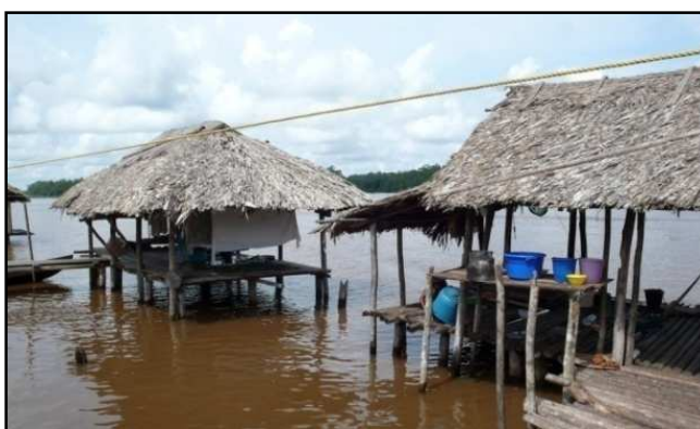
Figura 67: Palafito con ausencia de paredes
