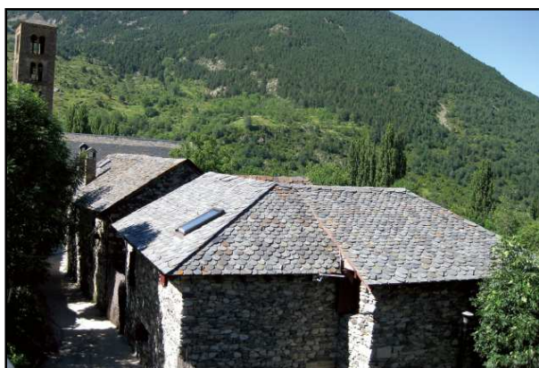
Figura 133: Cubierta de pizarra
