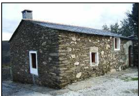
Figura 339: (1-3) Muro de alta inercia térmica. Vivienda tradicional. (2-4) Muro de hormigón. Vivienda en Corea del Sur. Estudio de arquitectura: Unsangdong Architects
