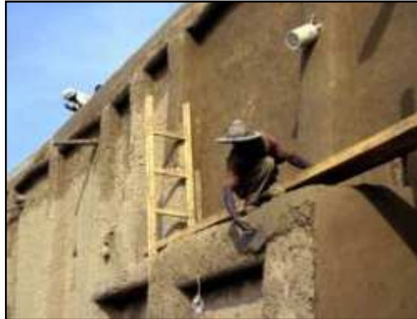
Figura 116: Aplicación revoco de barro sobre muro. Djenné (Malí)
