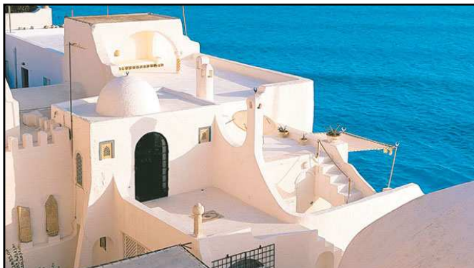
Figura 140: Cubierta plana (Túnez)
