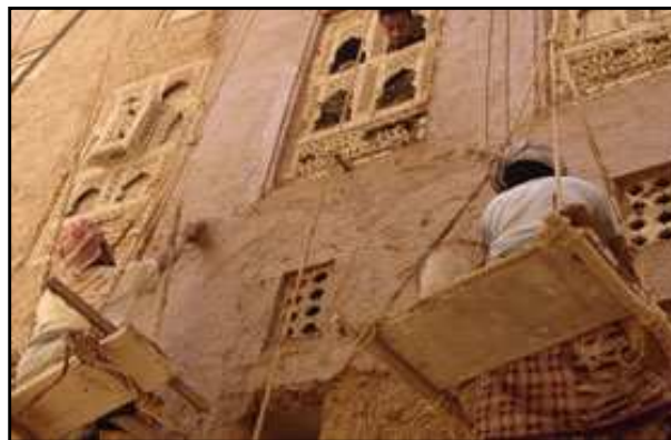
Figura 153: Reparación una vivienda en Shibam (Yemen)
