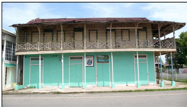
Figura 62: Construcción de madera en Bocas del Toro (Panamá) Fuente: Farfan 2009
