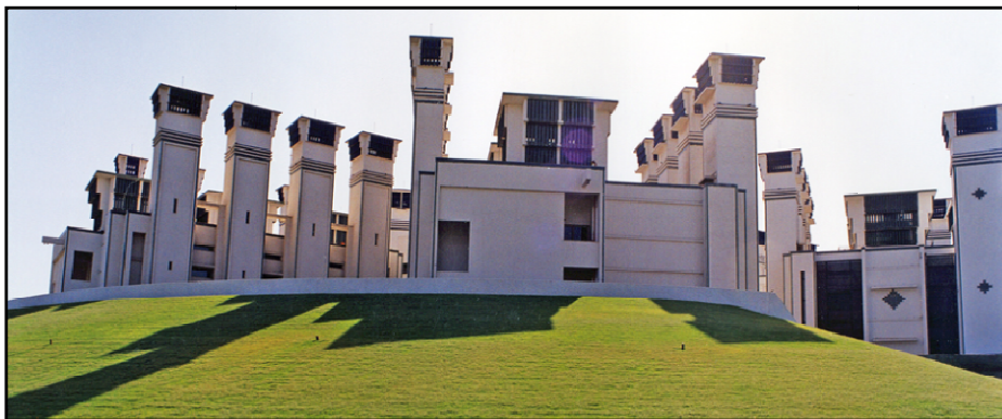
Figura 310: Torres eólicas. Centro de Investigación de Ahmedabad en la India Fuente: Dalh 2013
