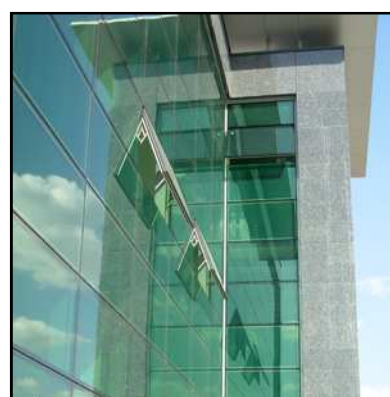
Figura 274: (1) Fachada de vidrio reflectante. (2) Fachada de vidrio de baja emisividad
