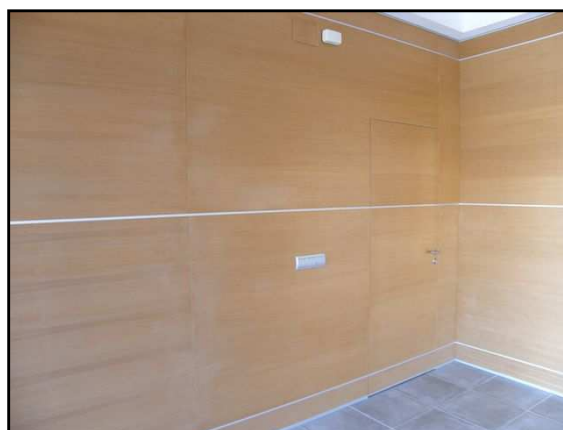
Figura 323: (1) Revestimiento de tablas machihembradas. (2) Revestimiento de tableros contrachapados
