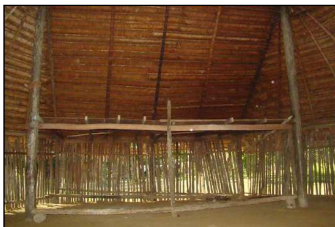
Figura 84: Maloca Indígena. Vista interior de los muros
