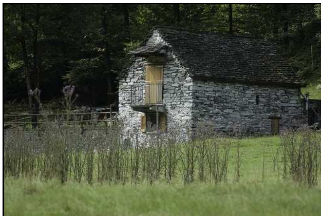
Figura 14: Vivienda de piedra del valle Verzasca (Suiza) Fuente: Felgner 2012
