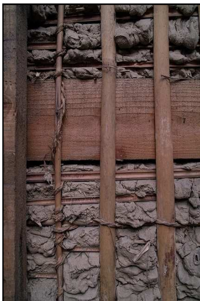
Figura 196: Cerramiento de arcilla con estructura de madera y bambú
