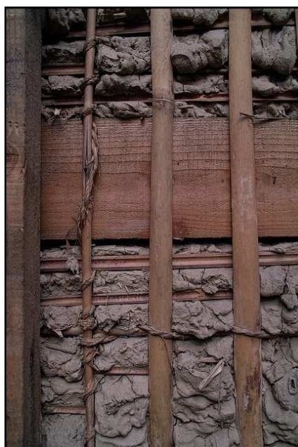
Figura 59: Cerramiento de arcilla con estructura de madera y bambú
