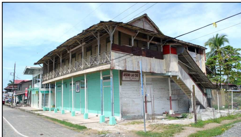
Figura 61: Construcción de madera en Bocas del Toro (Panamá) Fuente: Farfan 2009
