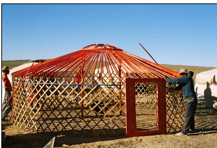
Figura 10: Armazón de sauce de una yurta Fuente: Tkn20 (anónimo) 2007
