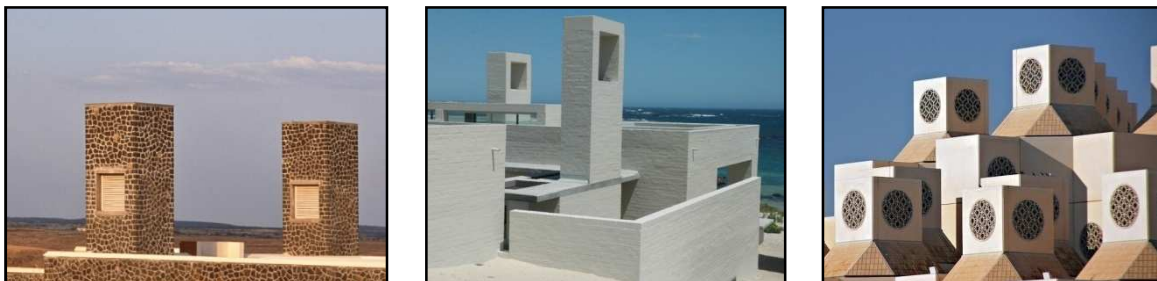
Figura 305: (1-2) Torre de viento con una abertura. (3) Captador de viento con cuatro aberturas
