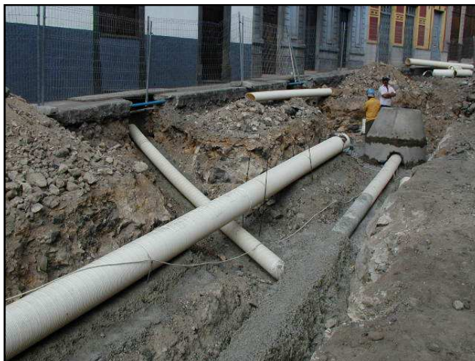
Figura 227: Sistema separativo de saneamiento en Gran Canaria Fuente: Alemán 2004
