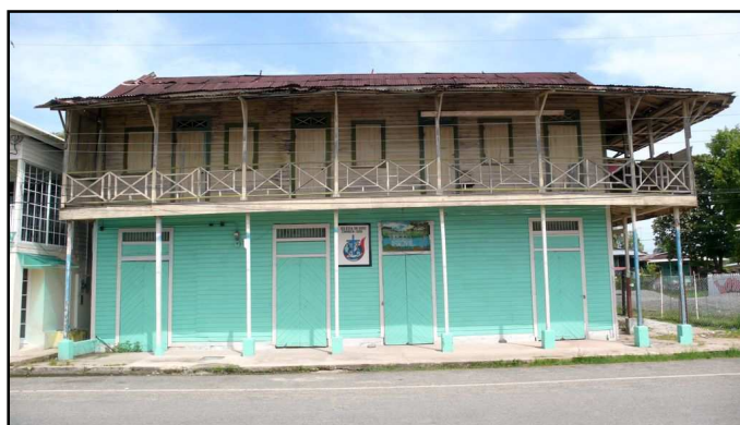
Figura 177: Construcción de madera en Bocas del Toro (Panamá)
