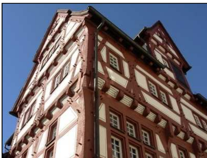
Figura 24: Vivienda con entramado de madera
