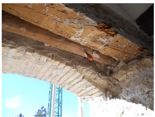
Imagen 1-Observaciones. Se observan los tres dinteles de hueco de ventana en fachada del Ala Sud, donde ha quedado completamente clavado un destornillador en el dintel circular mientras se comprobaba su estado. Imagen 2-Observaciones. Zoom de la Imagen 1-Observaciones, donde se aprecia la profundidad a la que ha quedado clavado el destornillador.
