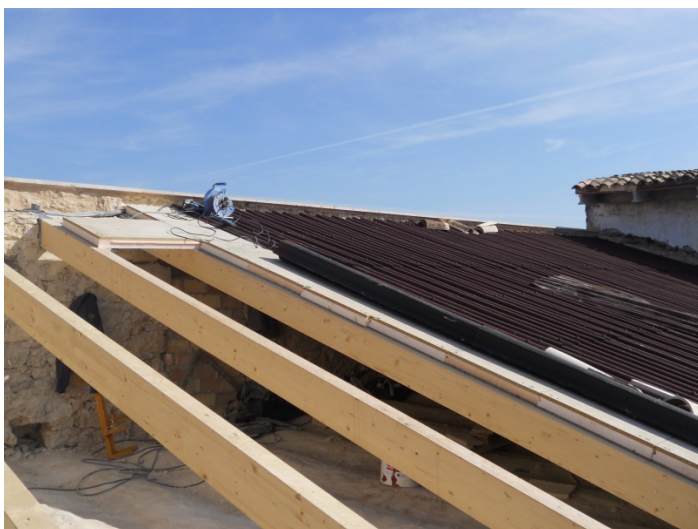
Imagen 1-Observaciones. Material acopiado sobre las placas onduladas de fibroasfalto, y material acopiado bajo cubierta.
