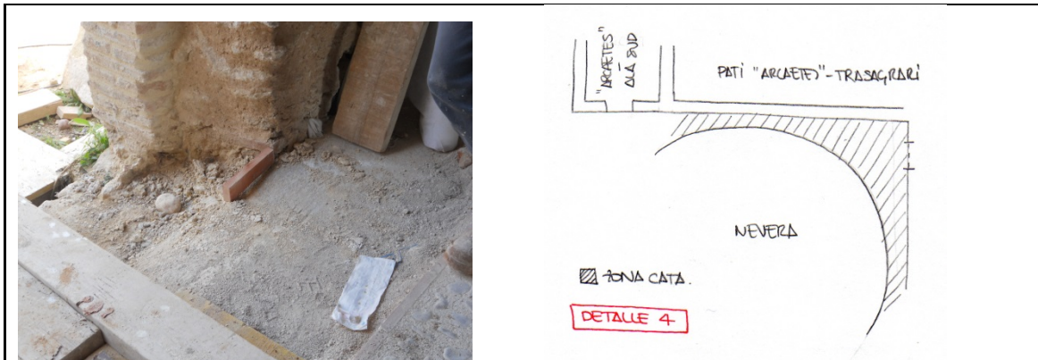
Imagen 1. Se muestra el replanteo y ubicación de las baldosas para resolver la parte de enmorrillado que falta por ejecutar, así como el acceso a la planta baja de “les Arcaetes”.
