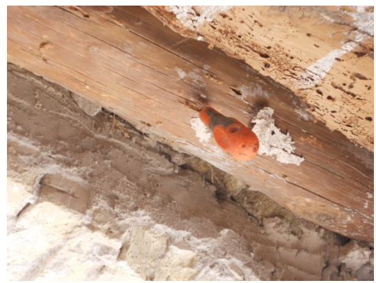
Imagen 1-Observaciones. Se observan los tres dinteles de hueco de ventana en fachada del Ala Sud, donde ha quedado completamente clavado un destornillador en el dintel circular mientras se comprobaba su estado. Imagen 2-Observaciones. Zoom de la Imagen 1-Observaciones, donde se aprecia la profundidad a la que ha quedado clavado el destornillador.
