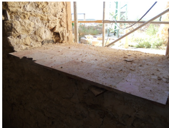
Imagen 1-Observaciones. Rotura baldosa vierteaguas en planta segunda del edificio Ala Sur.
