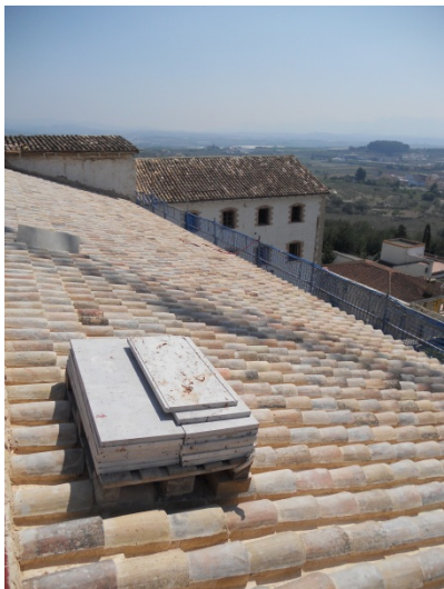
Imagen 1-Observaciones. Cubierta del edificio Ala Sur. Apilado de baldosas del andador.
