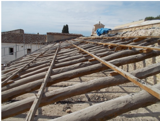
Imagen 1. Se observa cómo ha quedado la cubierta después de la retirada de las placas de fibrocemento.
