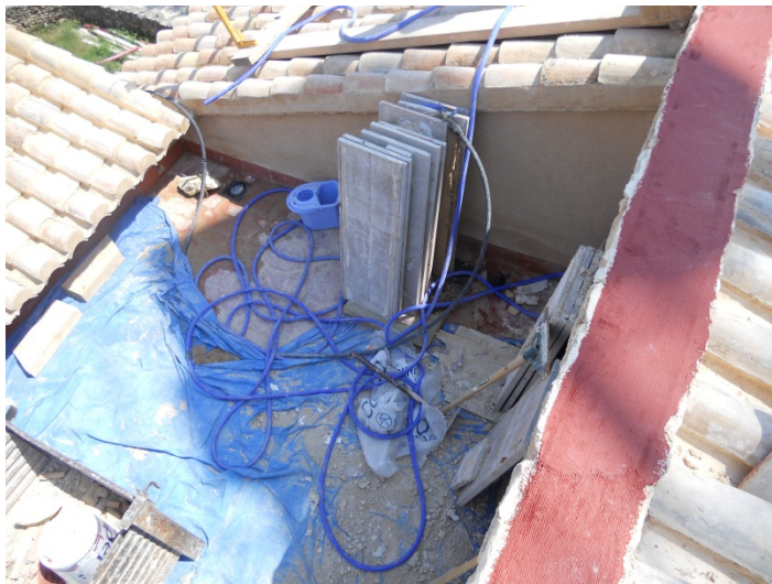
Imagen 1-Observaciones. Cubierta del edificio Ala Sur. Apilado de baldosas del andador.
