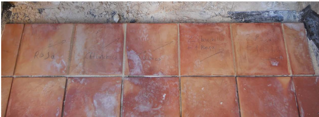
Imagen 1. Muestras de los distintos colores posibles para rejuntar el pavimento del patio de “les Arcaetes”. De izquierda a derecha: Roja, Chinchilla, Blanco, 2 Chinchilla + 1 Roja, y 2 Roja + 1 Chinchilla.
