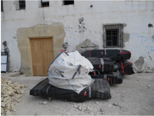
Imagen 1-Observaciones. Acopio en la entrada al Convento de los paquetes que envuelven las placas de fibrocemento retiradas el pasado lunes 24 de febrero.
