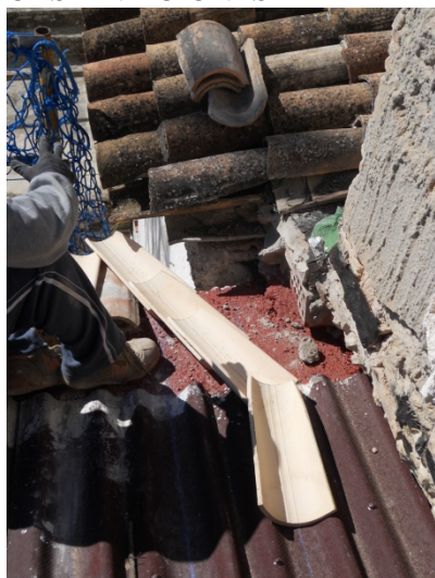
Imagen 1-Observaciones. Disposición constructiva del encuentro del tejado.
