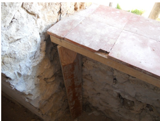
Imagen 1-Observaciones. Rotura baldosa vierteaguas en planta segunda del edificio Ala Sur.
