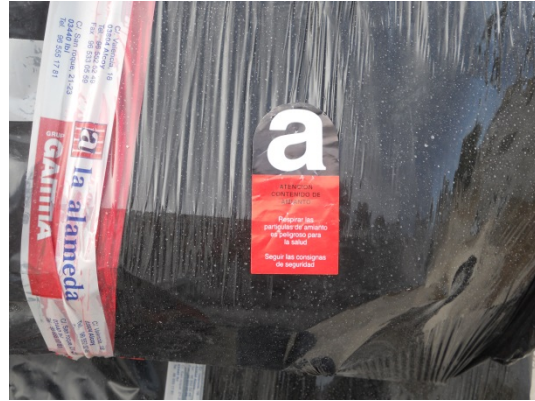
Imagen 1-Observaciones. Acopio en la entrada al Convento de los paquetes que envuelven las placas de fibrocemento retiradas el pasado lunes 24 de febrero.
