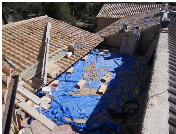
Imagen 1-Observaciones. Disposición constructiva del encuentro del tejado.
