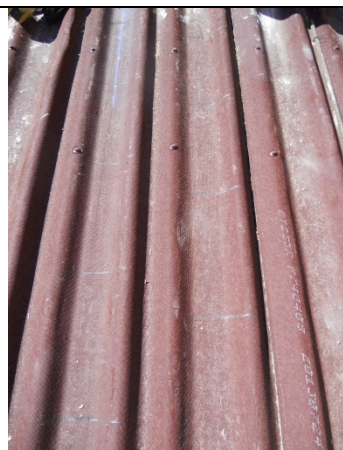
Imagen 1. Se muestra el replanteo de las tejas en la placa de fibroasfalto de la cubierta del edificio Ala Sur.
