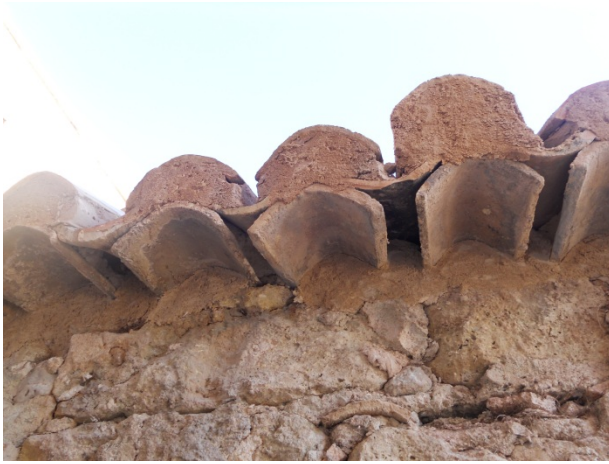
Imagen 1-Observaciones. Amortizado de las bocatejas del tejado de la nevera.
