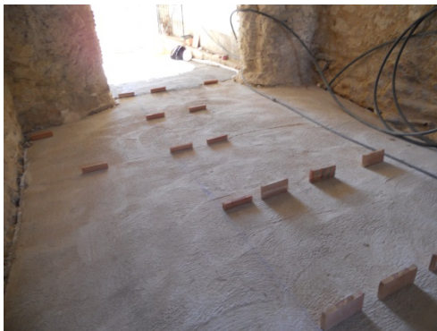
Imagen 1. Replanteo del enmorrillado en la planta baja Ala Sud - “les Arcaetes”.
