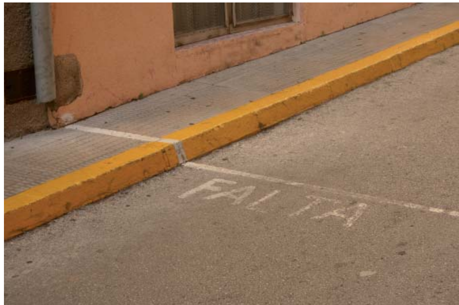
Ratlla de falta en el Carrer de Dalt de Parcent.
