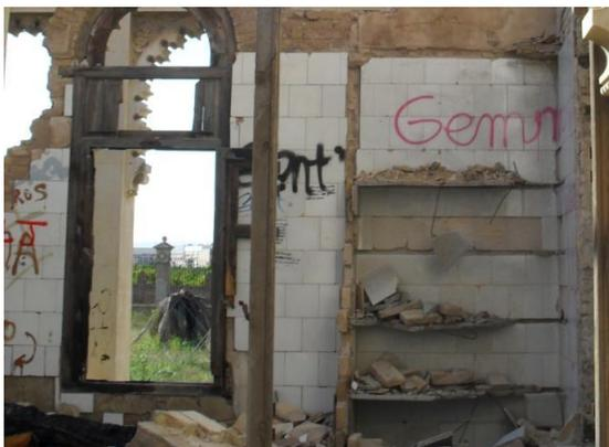
*Fig.111 - Revestimiento vertical en zonas húmedas (2014) -*
