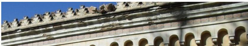
*Fig.136 - Grietas y fisuras en alero (2014) - Fuente propia*
