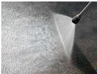
*Fig.151 - Proyección chorro de agua a presión - [www.construmatica.com](http://www.construmatica.com)*
