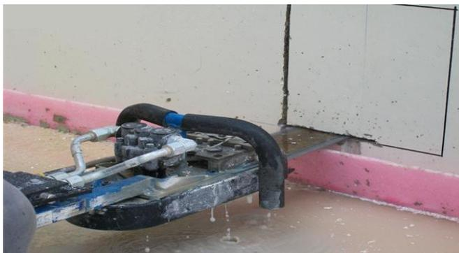
*Fig.153 - Corte mediante espada de diamante - [www.aracorte.com](http://www.aracorte.com)*
