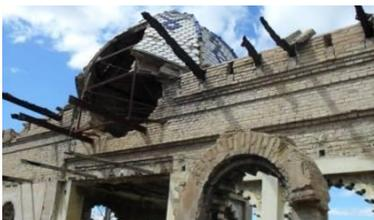
*Fig.133 - Desmoronamiento de cubierta y parte de la cúpula (2014) - Fuente propia*
