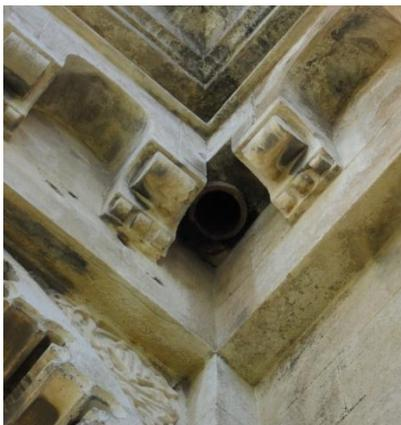
*Fig.113 - Orificio de bajante (2014) - Fuente propia*
