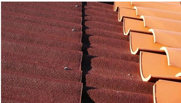
*Fig.155 - Onduline Bajo Teja 235 con teja curva -
