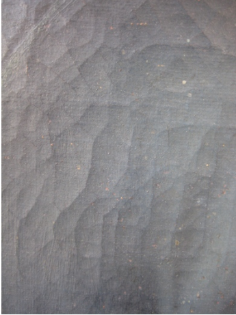
Fig.45. Red de craqueladuras.
