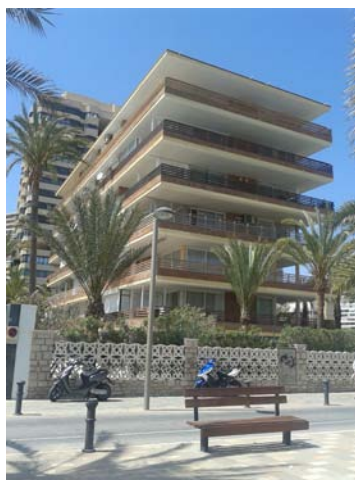
Figura 7_5: Apartamentos Alhambra, Vista de la fachada sur en la que se ve la continuidad de la línea de balcones con la utilización de lamas horizontales, evitando la descomposición del alzado. Este elemento también se utilizará en la composición de las torres-hito propuestas en la Ordenación del 1º Polígono de la Playa de San Juan .
