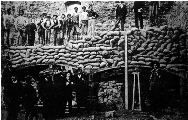
Fig. 53: Prueba de carga depósito Gijón, 1912 (Fernández, J.A. y Navarro, J.R. 1999)
