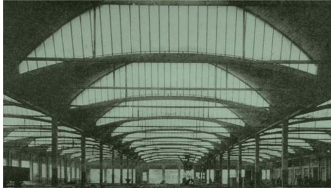
Fig. 57: Cubierta talleres Bagnaux, 1928-1929. ( http://arquitecturamashistoria.blogspot.com.es/ )
