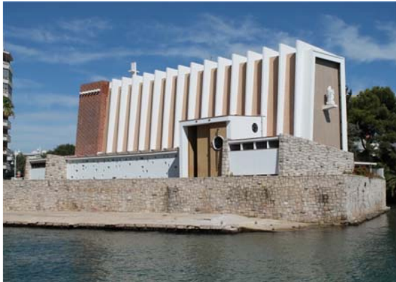
Fig. 47: Vista de la Fachada Oeste y Sur. Sacristía. (Arnau, F. 2013)
