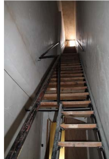
Fig. 40: Escalera acceso a cubierta.
