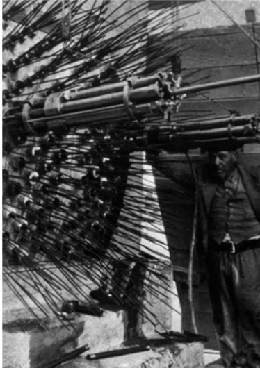
Fig. 100: Tesado de los cables por el Método Barredo. (González, F, 2007)
