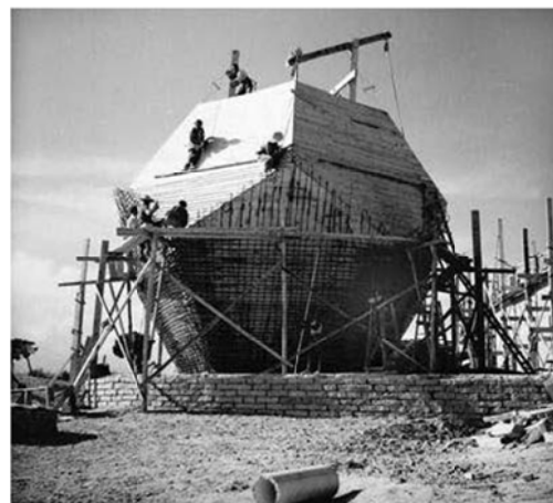
Fig. 75: Depósito ITC CET. 1959. (García, R. 2007)
