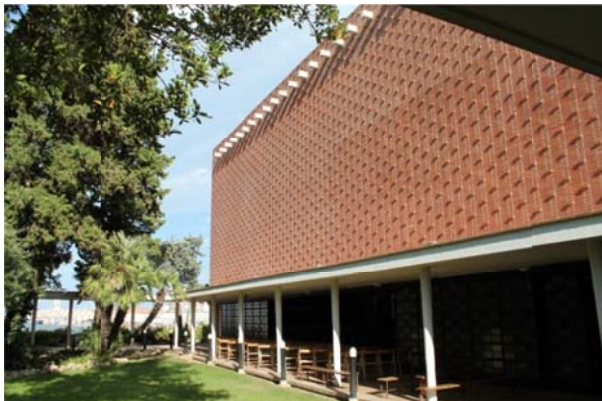
Fig. 34: Vista Fachada Norte. Abertura al claustro. (Arnau, F. 2013)
