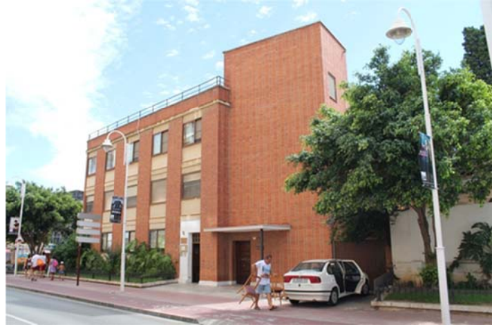
Fig. 26: Fachada Oeste Casa Abadía. Av. de la Pau (Arnau, F. 2013)
