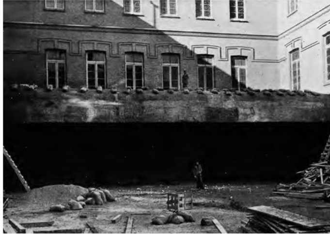
Fig. 83: Cubierta Patio Escuela Elemental de Trabajo. 1935. (Fernández, J.A. y Navarro, J.R. 1999)
