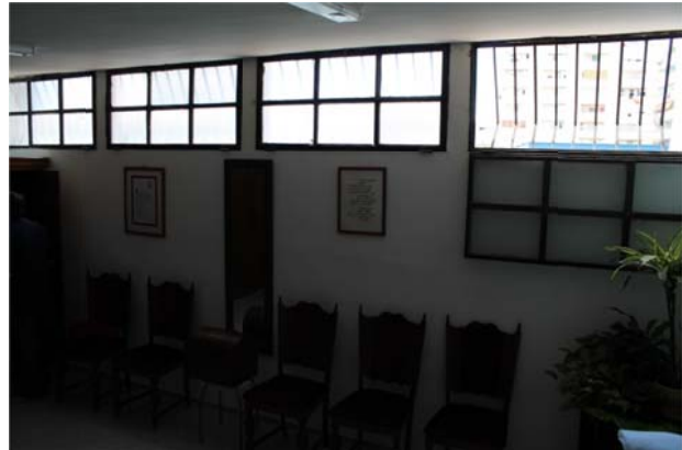
Fig. 48: Interior Sacristía (Arnau, F. 2013)
