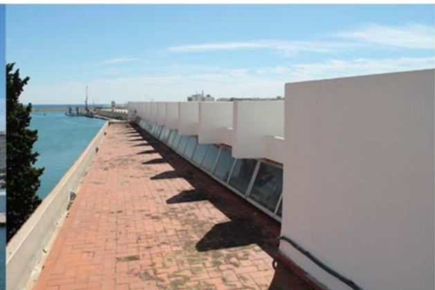
Fig. 38: Lucernario en cubierta (Arnau, F. 2013)
