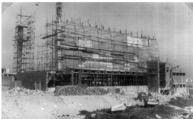
Fig. 107: Vista del Encofrado de lámina Sur. (Sala, R. 2012)
