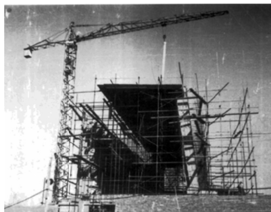
Fig. 108: Vista del encofrado de cubierta. (Sala, R. 2012)
