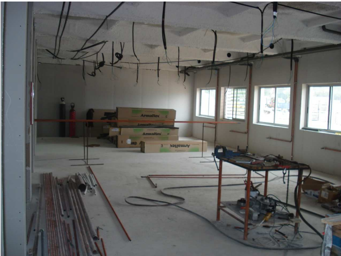
Cerrado de tabiquería de pladur una vez colocadas las instalaciones empotradas en aula de secundaria
