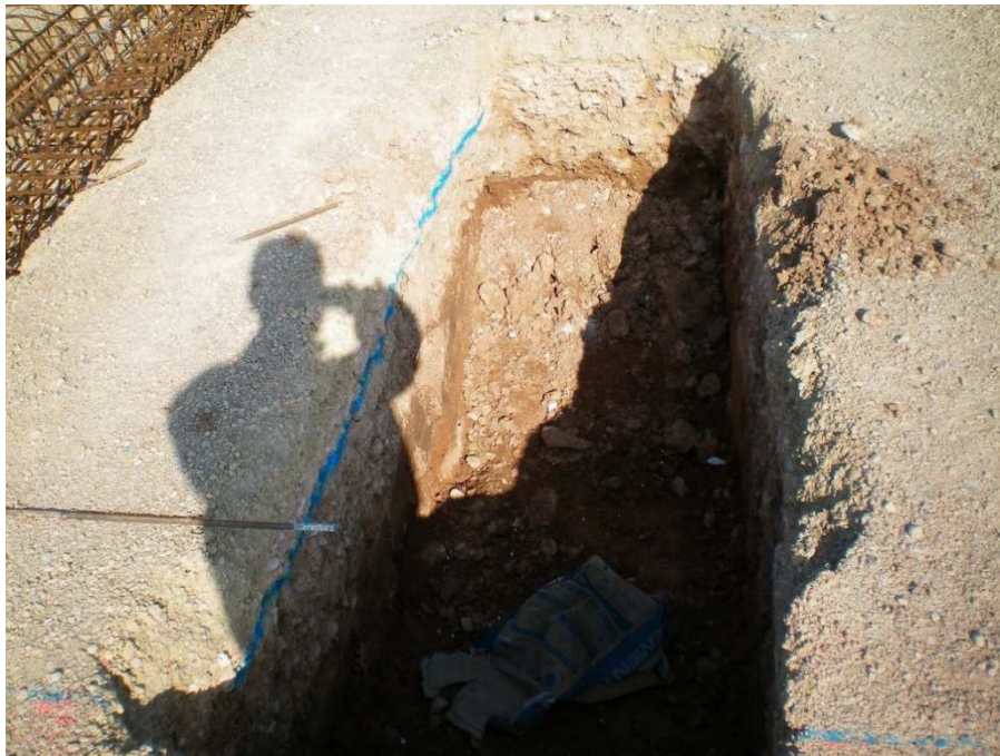
Zanja de zapata de cimentación para apoyo de escalera
