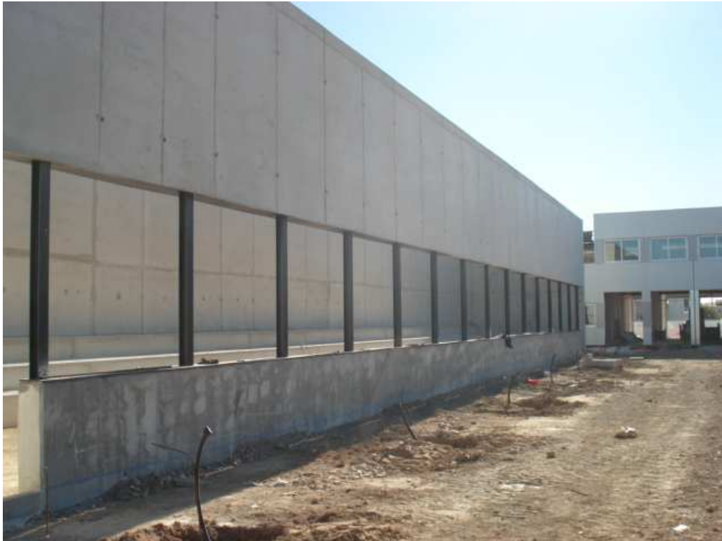
Muro de hormigón y cerrajería en juegos de pelota valenciana
