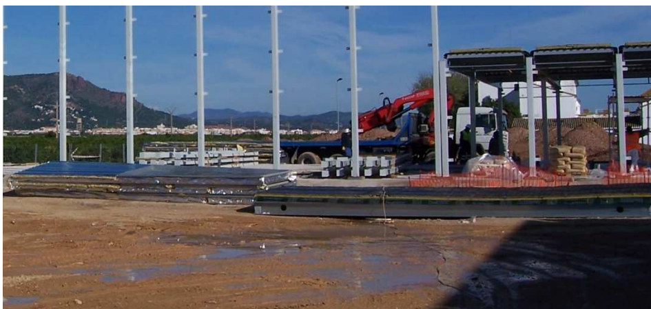
Módulos de cubierta preparados para su colocación
