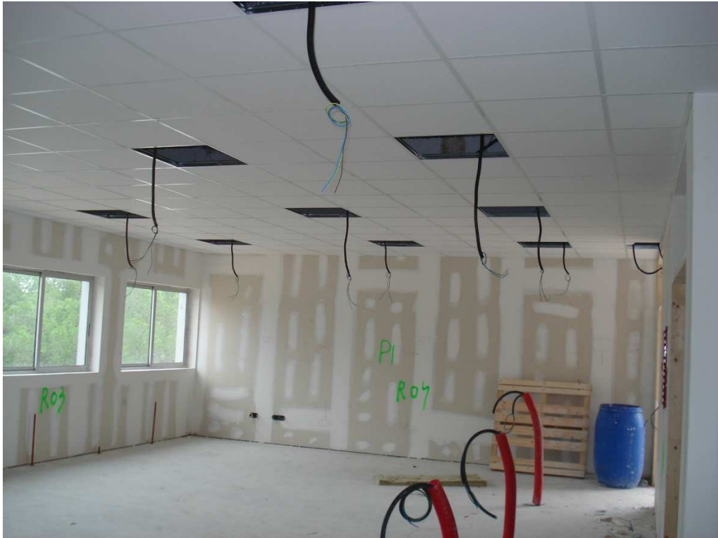
Falso techo desmontable en aulas de secundaria
