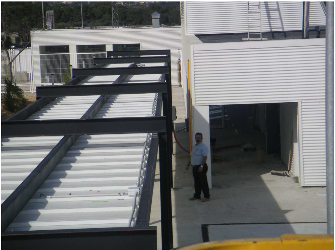
Marquesina cubierta de unión entre edificio de secundaria y gimnasio
