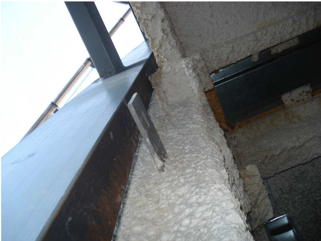
Revestimiento contra el fuego de pilar y chasis de forjado
