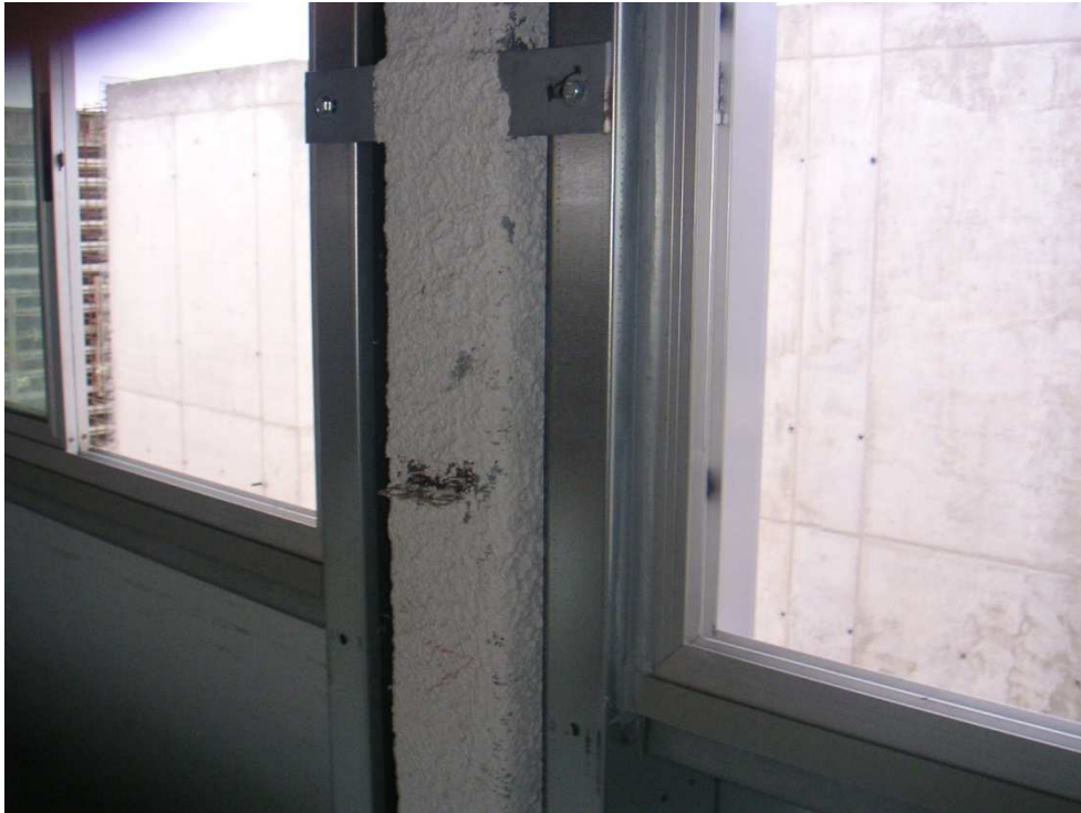
Módulos de fachada de edificio de secundaria
