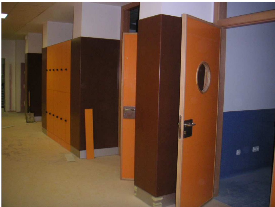
Encuentro de taquillas con revestimiento de DM en edificio de secundaria
