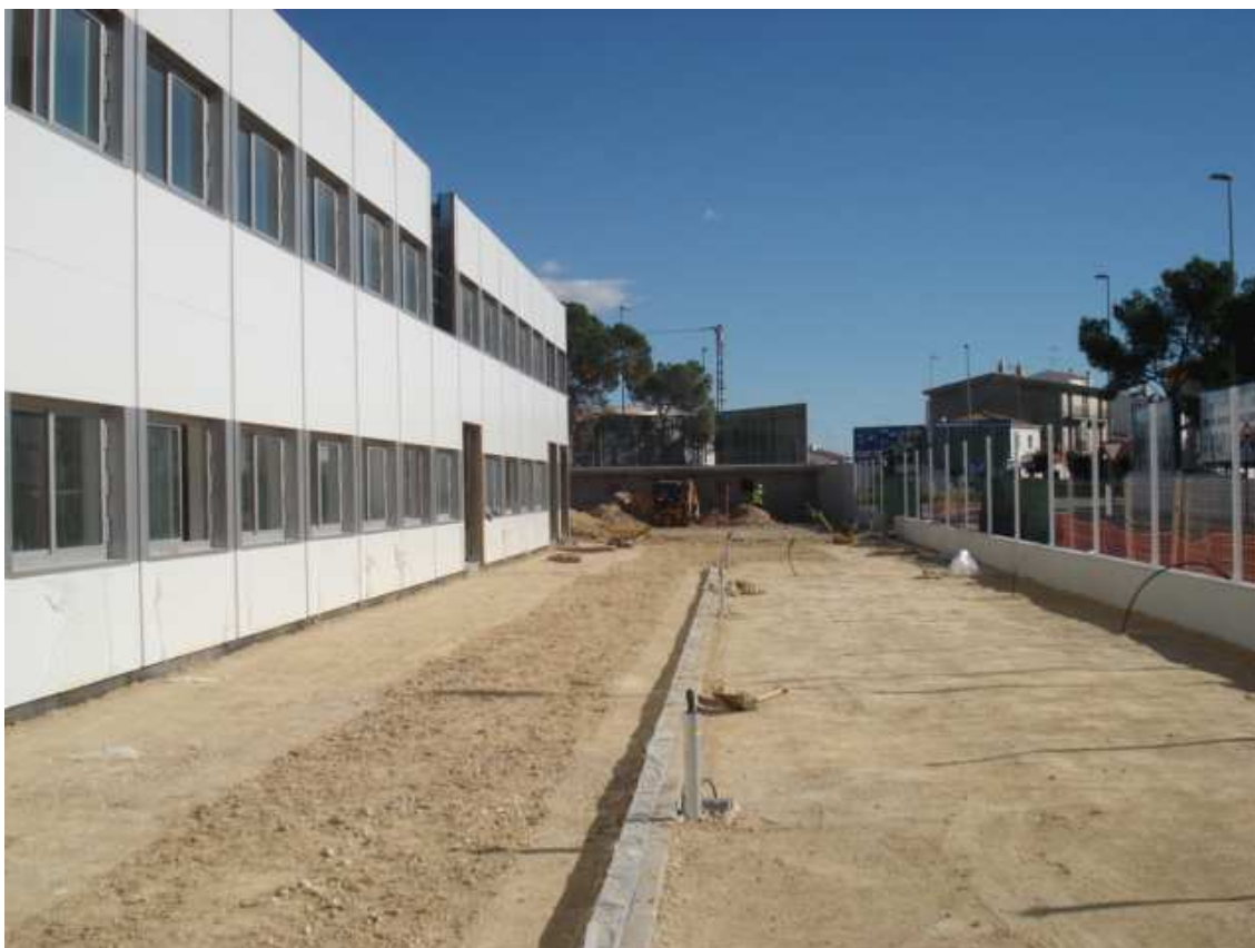
Colocación de canaleta de drenaje y de postes de vallado de obra
