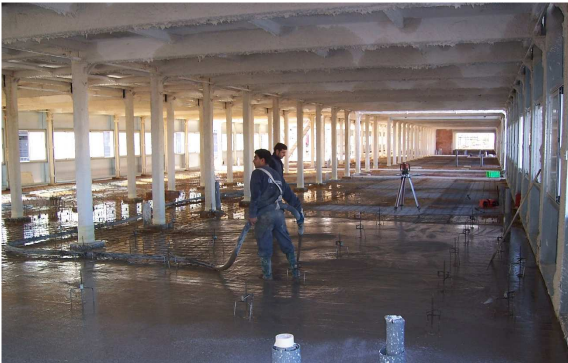
Aplicación de mortero autonivelante en edificio de secundaria.
