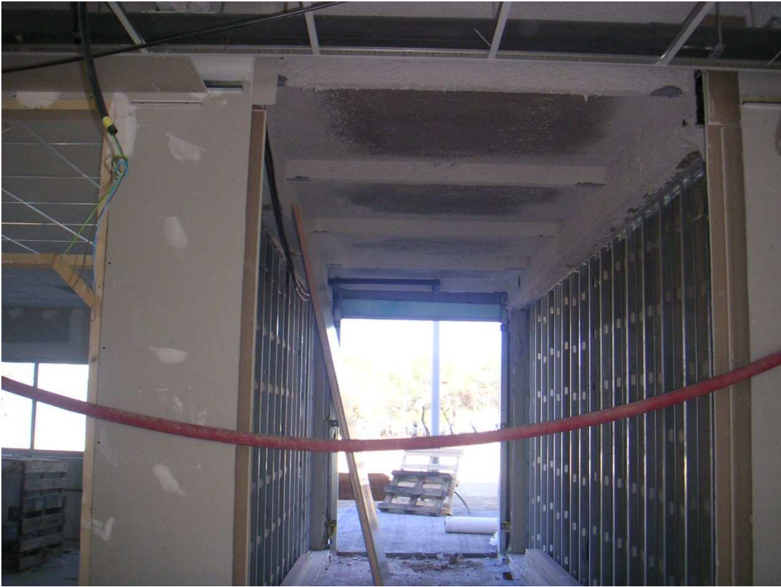
Colocación de estructura de pladur y primeras caras en edificio de secundaria
