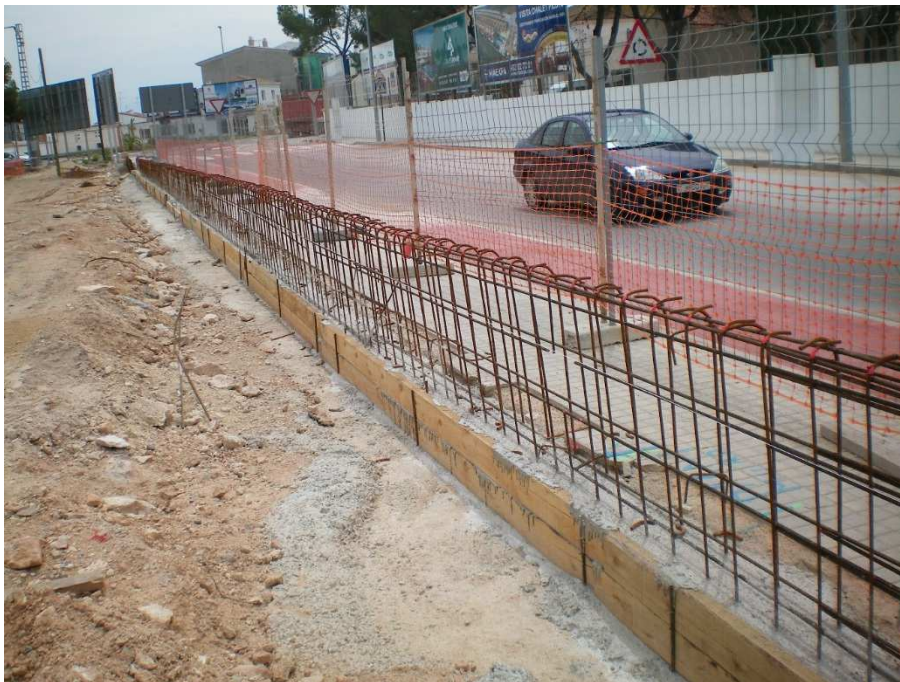
Armado de muro valla perimetral
