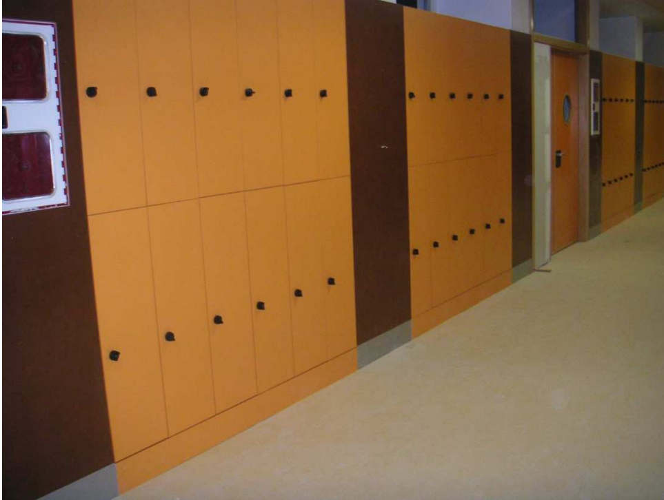
Encuentro de taquillas con revestimiento de DM en edificio de secundaria
