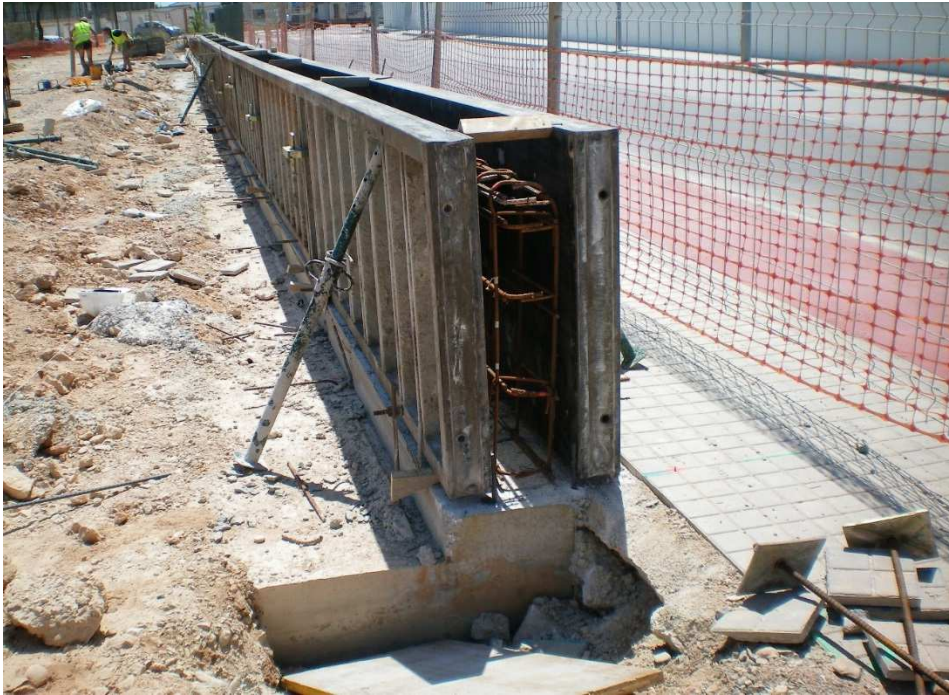
Encofrado de muro valla perimetral
