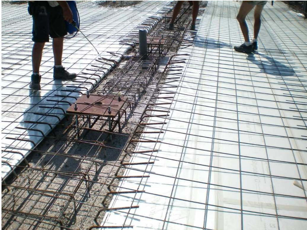
Solera colaborante de edificio de secundaria lista para hormigonar
