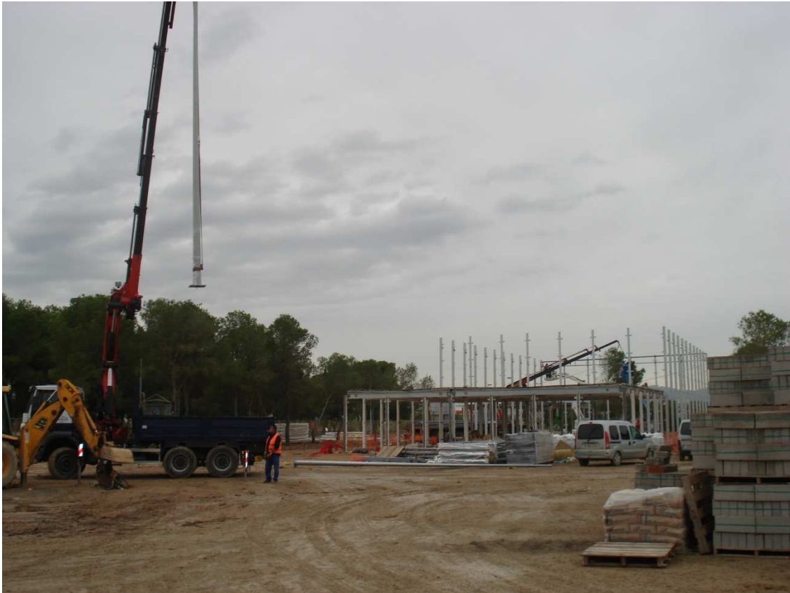
Pinchado de pilares de gimnasio
