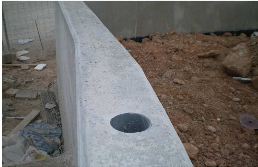
Muro de valla perimetral con pasatubos para empotrar poste de valla
