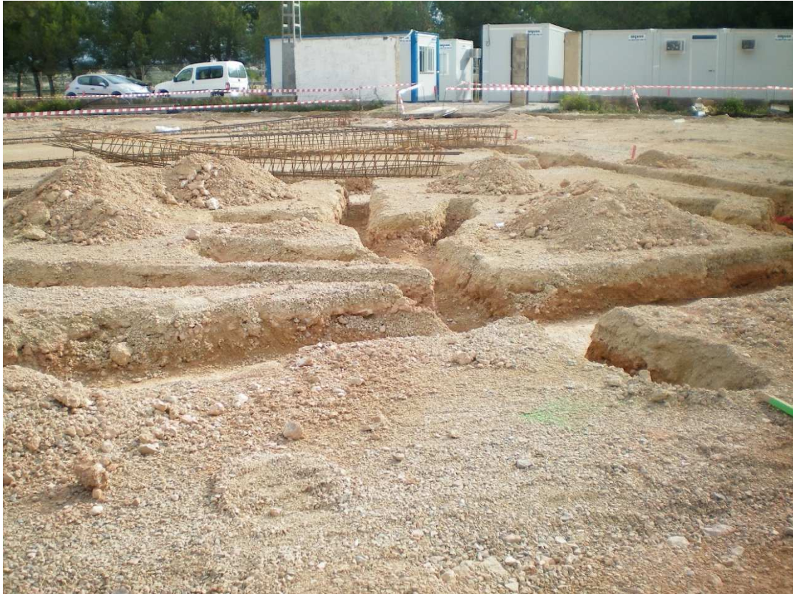
Zanjas de cimentación y saneamiento enterrado en edificio de secundaria
