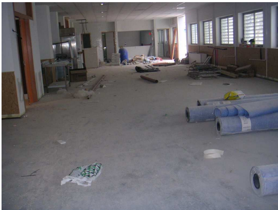
Panelado y revestimiento de pvc en el comedor de secundaria
