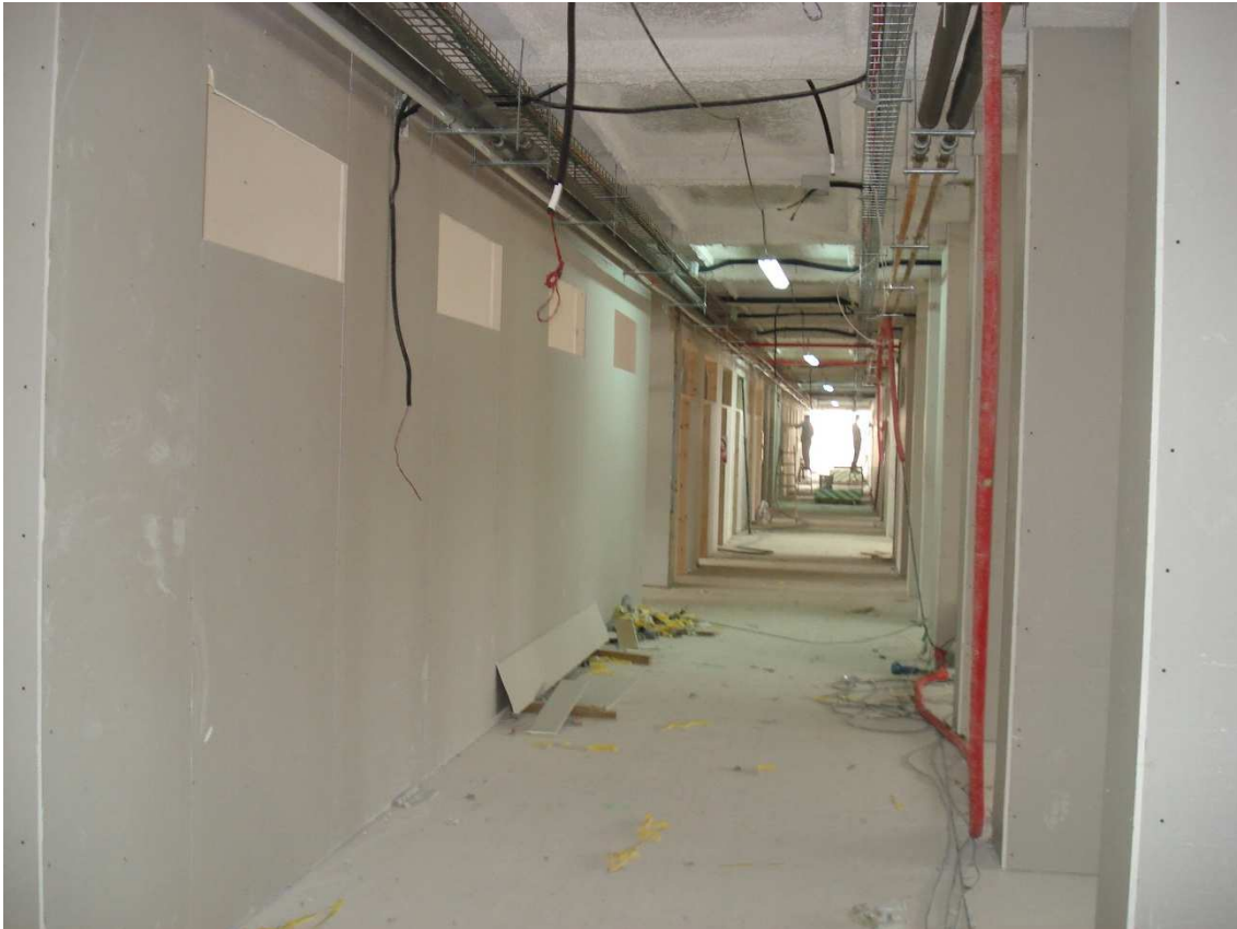
Cerrado de tabiquería de paldur una ve colocadal las instalaciones empotradas en aula de secundaria
