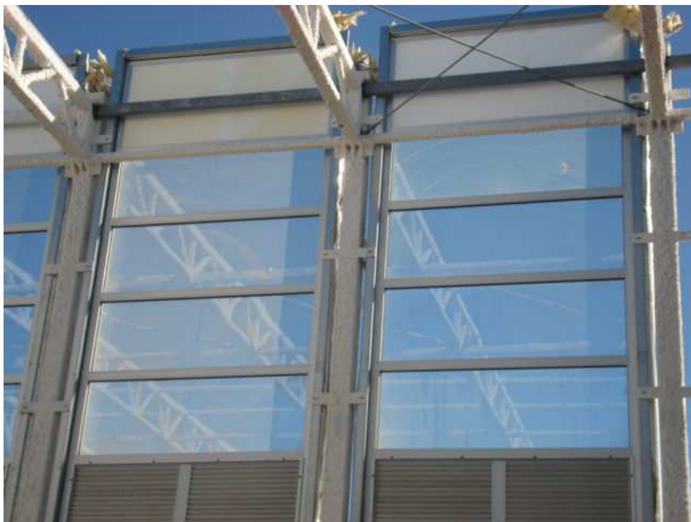
Modulos de fachada de edificio gimnasio.
