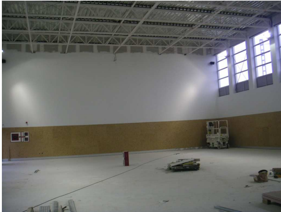
Pintura y panelado de gimnasio
