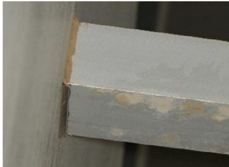
Ilustración 55. Encuentro entre los dos muros cortina. 2014. Fuente propia
