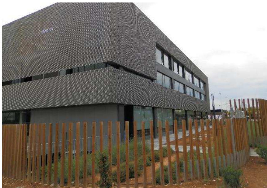
Ilustración 21. Exterior Centro Multiusos de Llíria. 2014. Fuente propia
