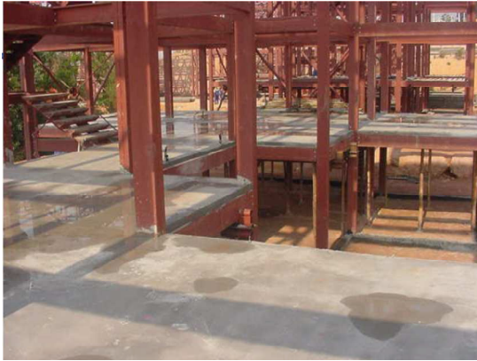
Fotografía 5. Losas prefabricadas.
