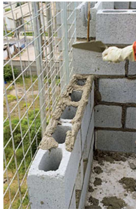
Fotografía 2. Albañilería estructural
