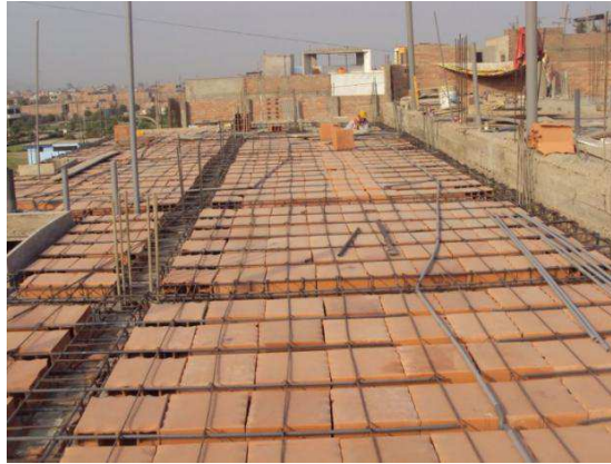
Fotografía 6. Forjado de bovedillas cerámicas
