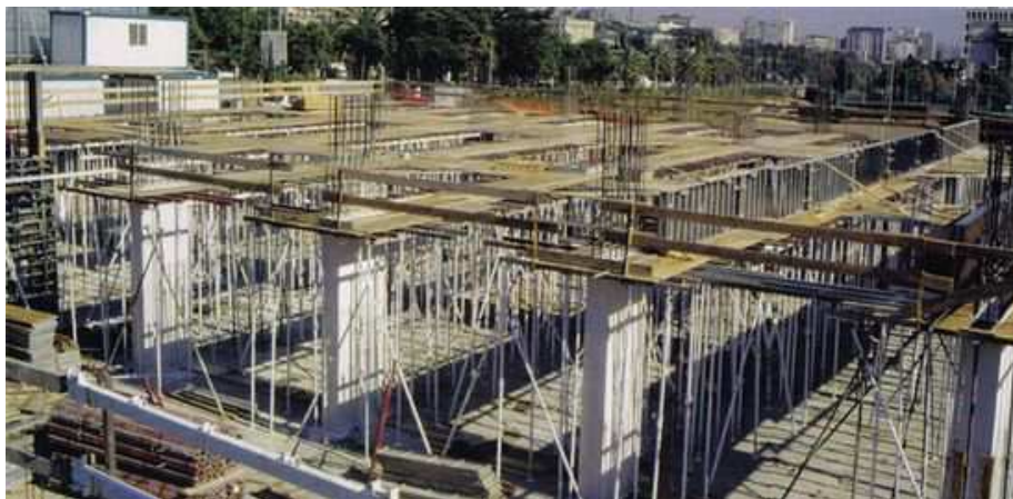
Fotografía 3. Encofrado parcial
