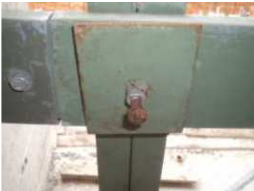
Fotografía 23. Detalle unión de elementos por tornillos
