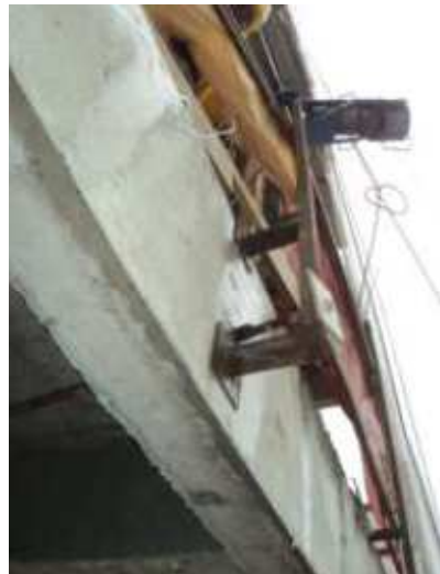
Fotografía 17. GcR fijado por apriete
