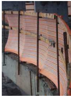
Fotografía 15. GcR fijado con tornillos
