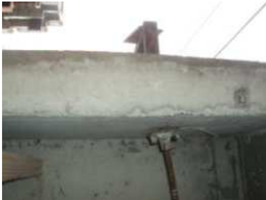
Fotografía 16. Detalle fijación por apriete
