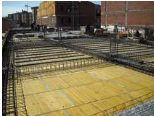
Fotografía 9. Encofrado horizontal total
