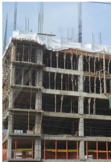
Fotografía 7. Puntales de encofrado de madera
