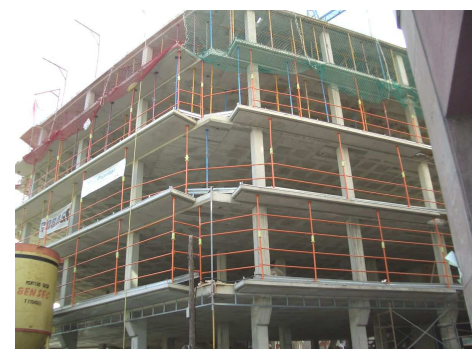
Fotografía 29. SPPB de puntales
