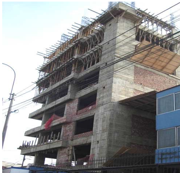
Fotografía 34. Ejemplo SPPB albañilería (Perú)
