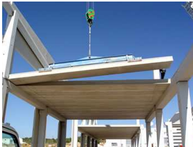
Fotografía 10. Proceso de colocación de losa alveolar.
