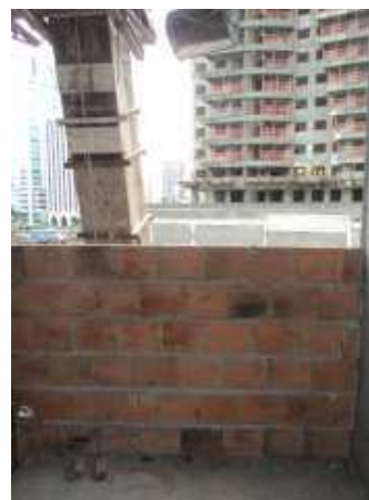
Fotografía 27. GcR de albañilería
