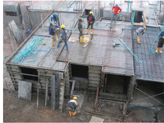
Fotografía 1. Cerramientos de hormigón
