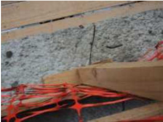
Fotografía 12. Fijación por cuña
