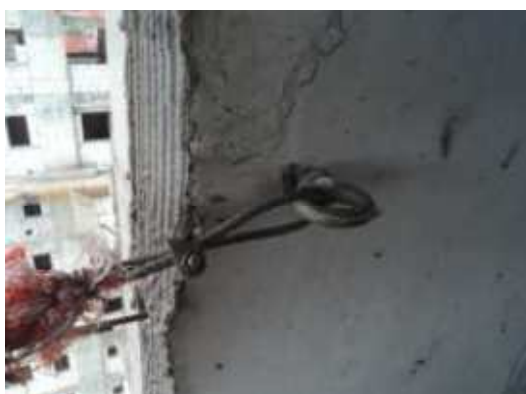
Fotografía 26. Detalle fijación por casquillos
