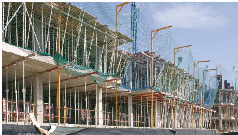
Fotografía 8. Encofrado horizontal total para forjado
