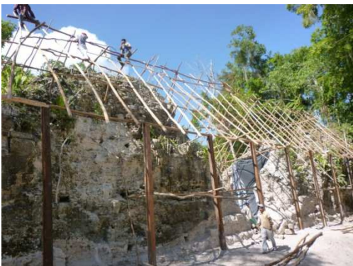
Figura 62. Construcción de una de las cubiertas de protección. Imagen PLB.
