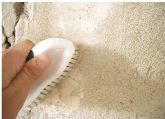
Figura 98. Cepillado del velo blanquecino que aparece por exudación de sulfato de calcio. Fotografía PLB.
