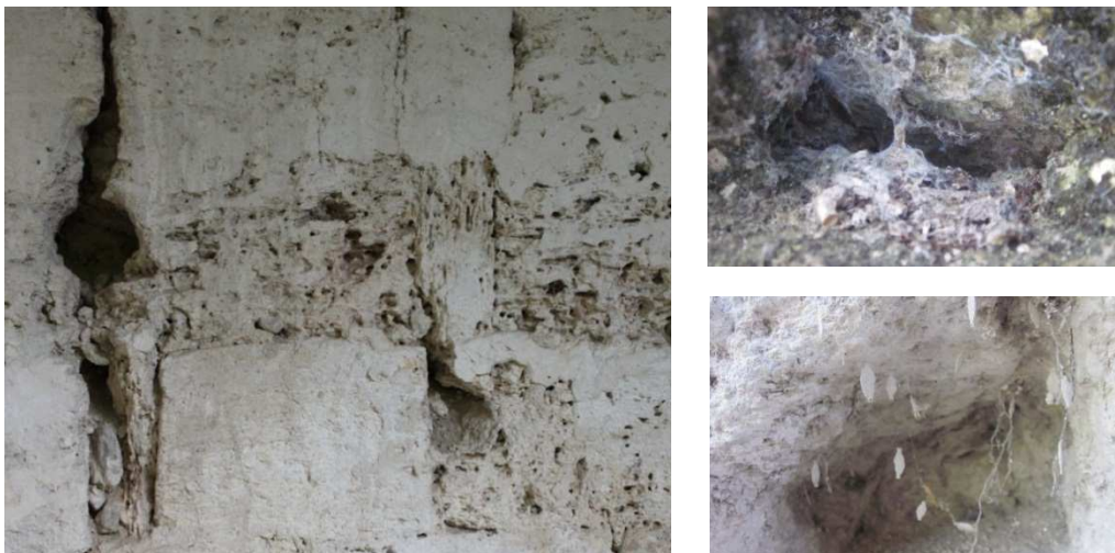
Figuras 72, 73 y 74. Alveolización de la piedra caliza y presencia de pequeños animales que hacen sus nidos en estas cavidades acelerando el proceso de deterioro.
