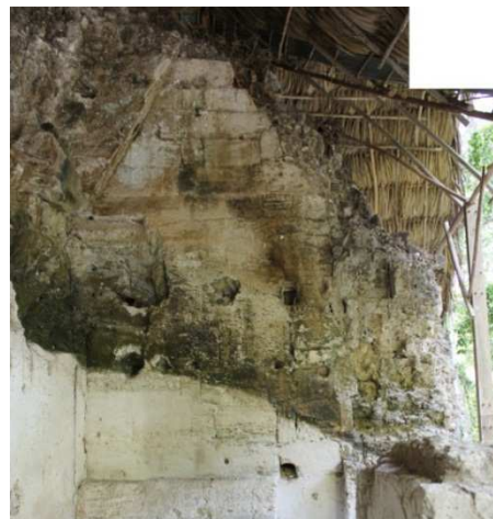
Figura 78. Concreciones biológicas en la mitad superior del muro que corresponde a la zona que se mantuvo expuesta del Cuarto 14.
