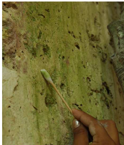
Figura 99. Limpieza de la pátina biológica. Fotografía PLB.
