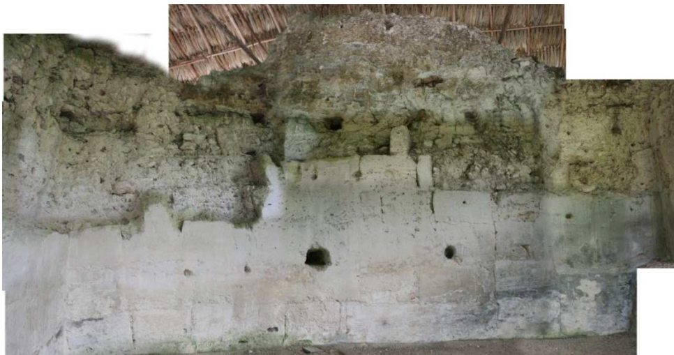
Figura 92. Estado actual de conservación del Cuarto 9.
