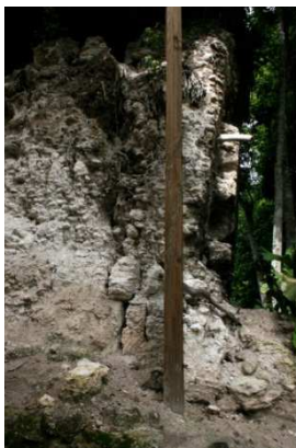
Figuras 95 y 96. Desplome del muro Este del Cuarto 18.
