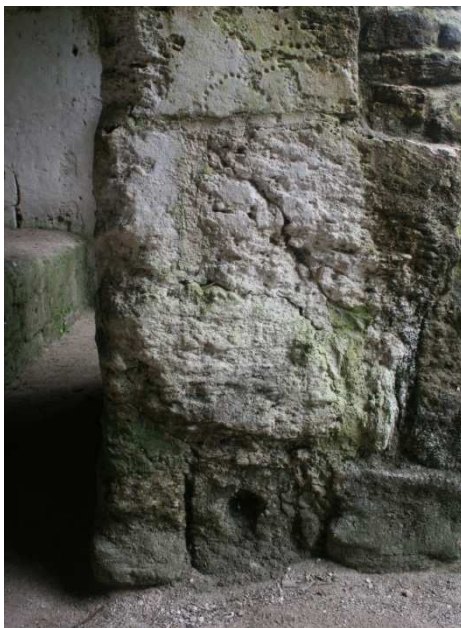
Figuras 70 y 71. Detalle de la erosión producida por los cordeles en las jambas del Cuarto 11.
