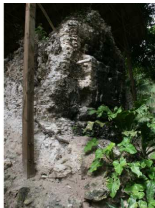
Figuras 95 y 96. Desplome del muro Este del Cuarto 18.
