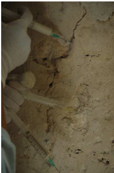
Figura 100. Consolidación de estucos por inyección de mortero. Fotografía PLB.
