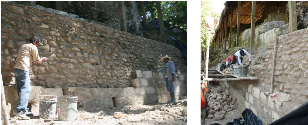
Figura 103 y 104. Trabajos de restauración en el extremo suroeste del basamento de la Acrópolis de La Blanca. Fotografías PLB 2013.
