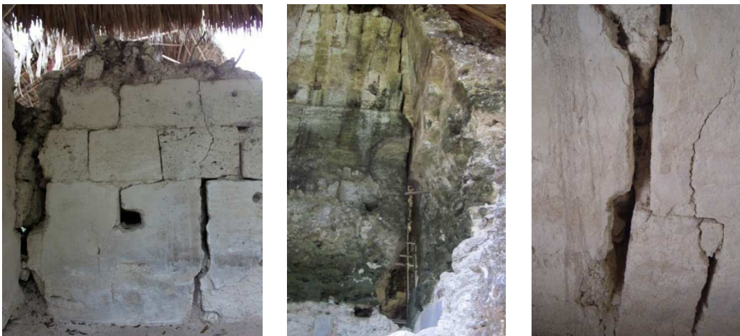
Figuras 83, 84 y 85. Lesiones derivadas de acciones mecánicas de los Cuartos 18, 13 y 16 respectivamente.
