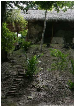
Figura 106. Escalera de acceso a la Acrópolis de La Blanca.
