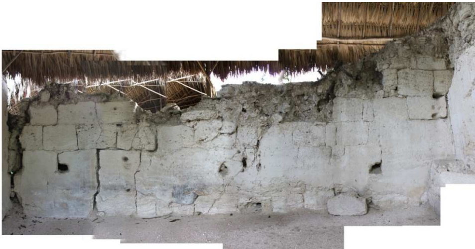
Figura 93. Estado actual de conservación del Cuarto 18.
