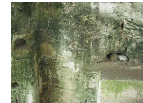
Figura 89. Detalle de concreción biológica en el Cuarto 4.
