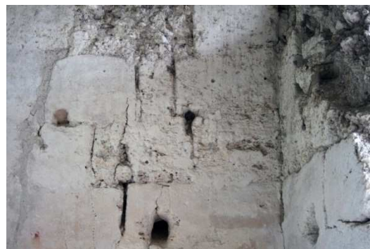
Figuras 66 y 67. Erosión de los materiales pétreos en las zonas superiores e inferiores de los muros, esta erosión lleva consigo la pérdida de volumen y la pérdida del mortero de agarre.
