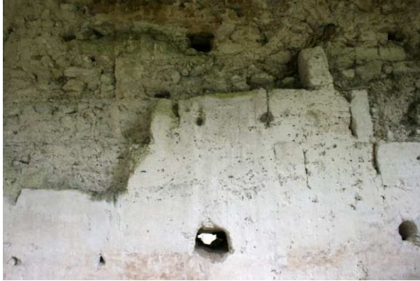
Figura 47. Orificio de ventilación situado en el muro Este del Cuarto 9.
