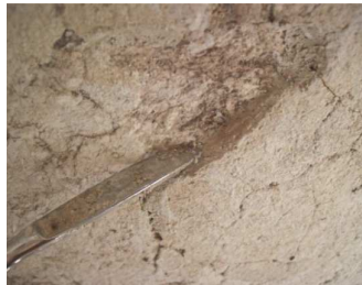
Figura 102. Rebordes perimetrales para consolidar los estucos. Fotografía PLB.
