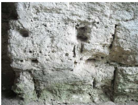
Figuras 66 y 67. Erosión de los materiales pétreos en las zonas superiores e inferiores de los muros, esta erosión lleva consigo la pérdida de volumen y la pérdida del mortero de agarre.
