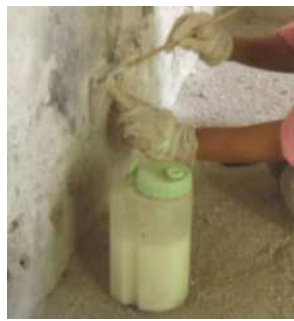
Figura 101. Aplicación de papel japonés sobre el estuco para su consolidación por inyección. Fotografía PLB.
