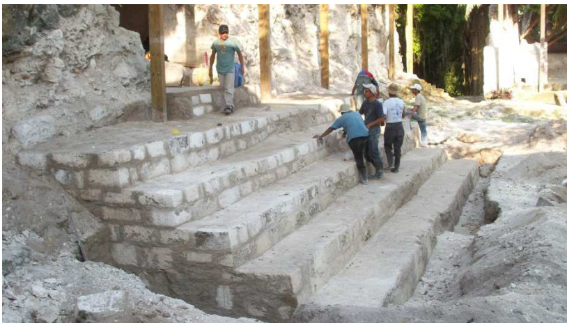
Figura 105. Trabajos de restauración en las escalinatas en el patio interior de la Acrópolis de La Blanca.
