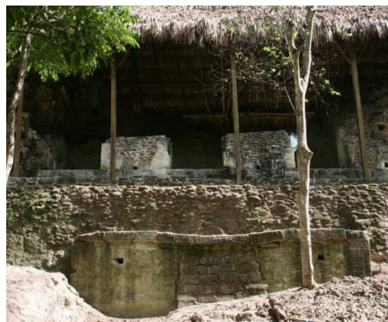
Figura 28. Subestructura 2 al Oeste de la Acrópolis bajo el Cuarto 11 del edificio 6J2. Fotografía PLB 2013.
