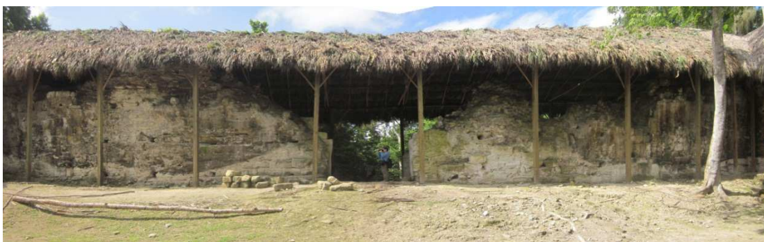
Figura 51. Muro Norte del interior del Patio de la Acrópolis.
