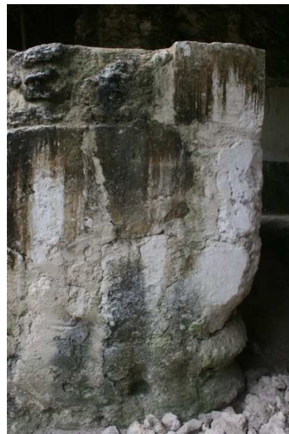
Figuras 70 y 71. Detalle de la erosión producida por los cordeles en las jambas del Cuarto 11.
