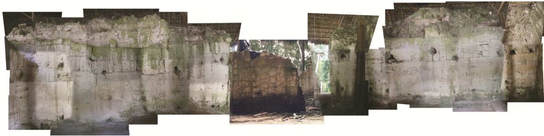
Figura 90. Estado actual de conservación del Cuarto 7.
