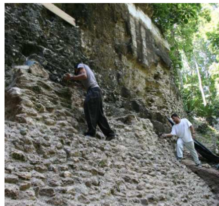
Figura 97. Trabajos de recalce del muro Este del Palacio de Oriente en 2007. Fotografía PLB.
