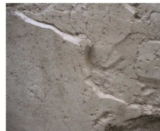
Figura 102. Rebordes perimetrales para consolidar los estucos. Fotografía PLB.
