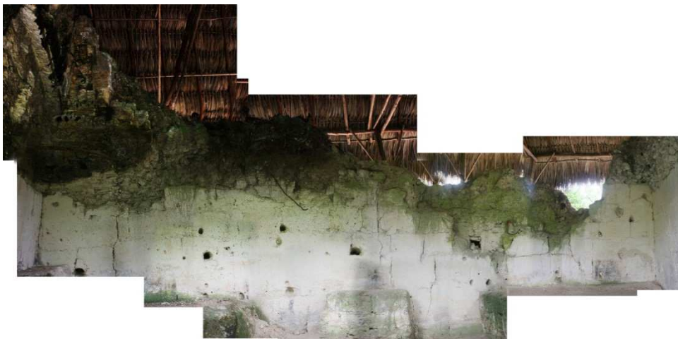
Figura 91. Estado actual de conservación del Cuarto 11.
