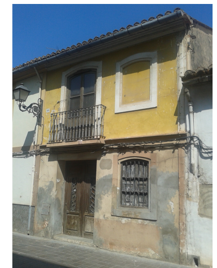
Fotografía 14: Aspecto general de la fachada
