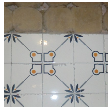
Fotografía 17: Eflorescencias detectadas
