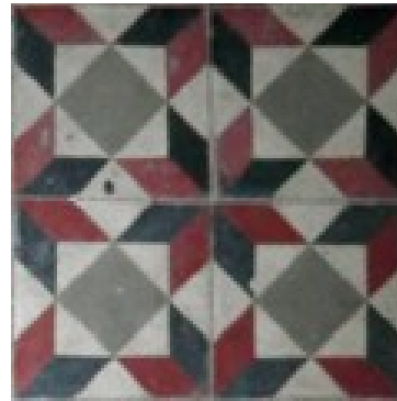
Fotografía 8: Losetas pavimento hidráulico original de 20x20 cms
