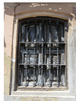
Fotografía 10: Reja en hueco de fachada
