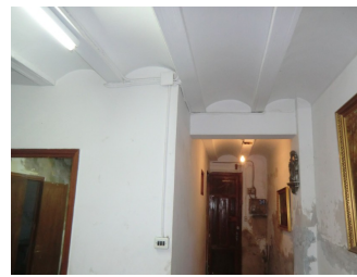
Fotografía 4: Forjado techo de planta baja
