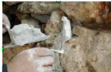
Fotografía 21: Aplicación de mortero transpirable en muro de mampostería
