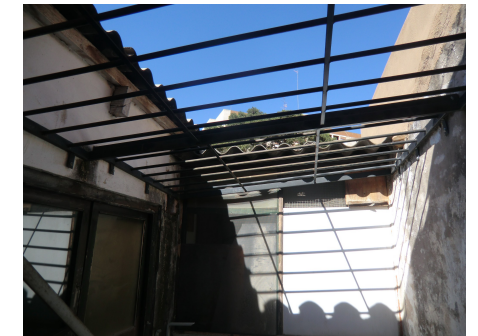
Fotografía 6: Cubierta con placas de fibrocemento
