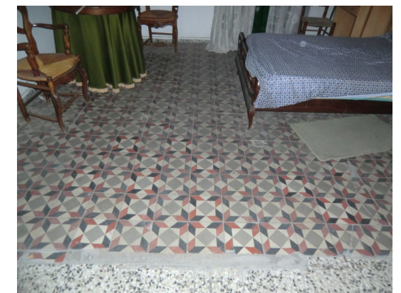
Fotografía 7: Pavimento original de la vivienda situado en planta superior
