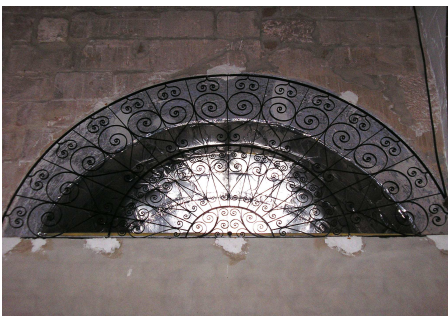
VENTILACION CAPIILA DE CALDERA
