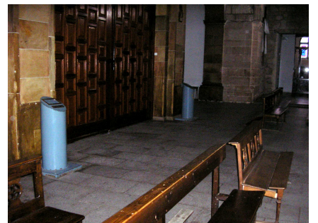
PUERTA CORTAVIENTOS Y PAVIMENTO
