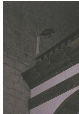
INTERIOR ESQUINA FACHADAS
