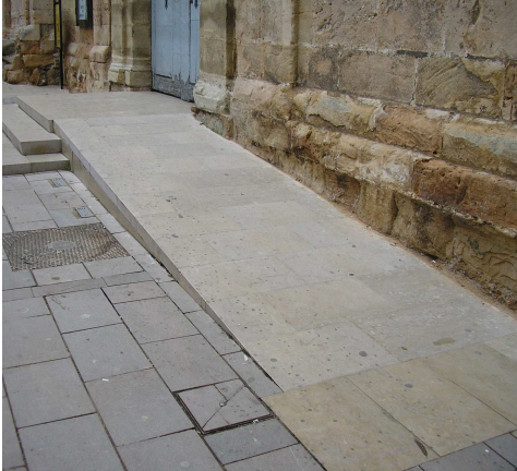
RAMPA ACCESO C/ STA MARÍA
