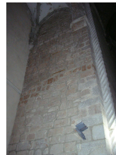
VISTA PUERTA CORTAVIENTOS CONTRAFUERTA SEPARACIÓN
