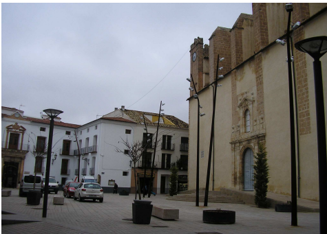
PLAZA DEL AYUNTAMIENTO – FACHADA IGLESIA
