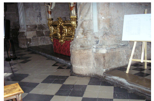
PAVIMENTO, CAPILLA Y PILASTRA (ZONA ACTUACIÓN)
