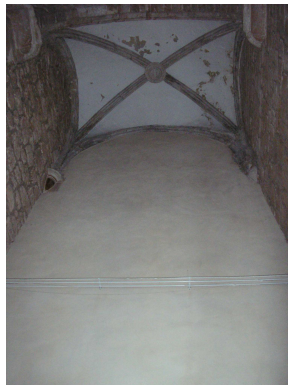
CUBIERTA CAPILLA LATERAL
