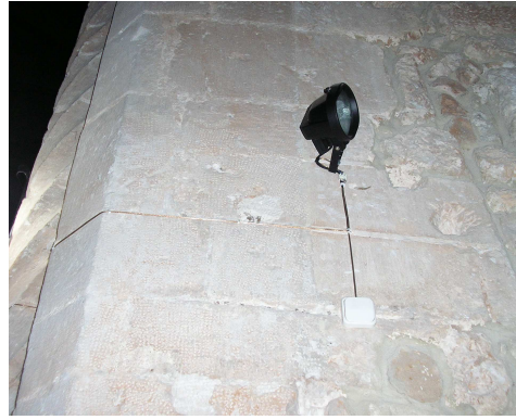
CONTRAFUERTE Y PILASTRA ADOSADA
