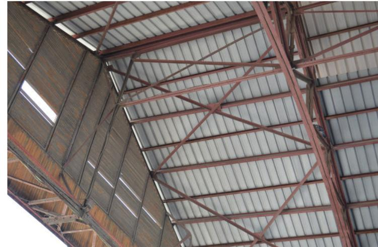
Fig. 41. Vista real del arriostramiento perimetral.
