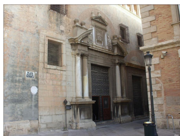
Fig. 20. Puerta de acceso al Patriarca
