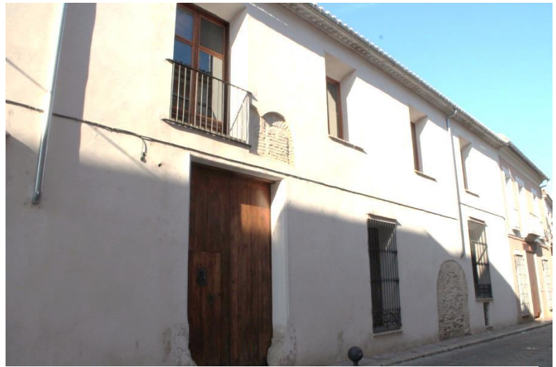
Fig. 26. Fachada de la vivienda.
