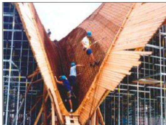
5.20. Armado base de unos de los nervios de la cubierta
