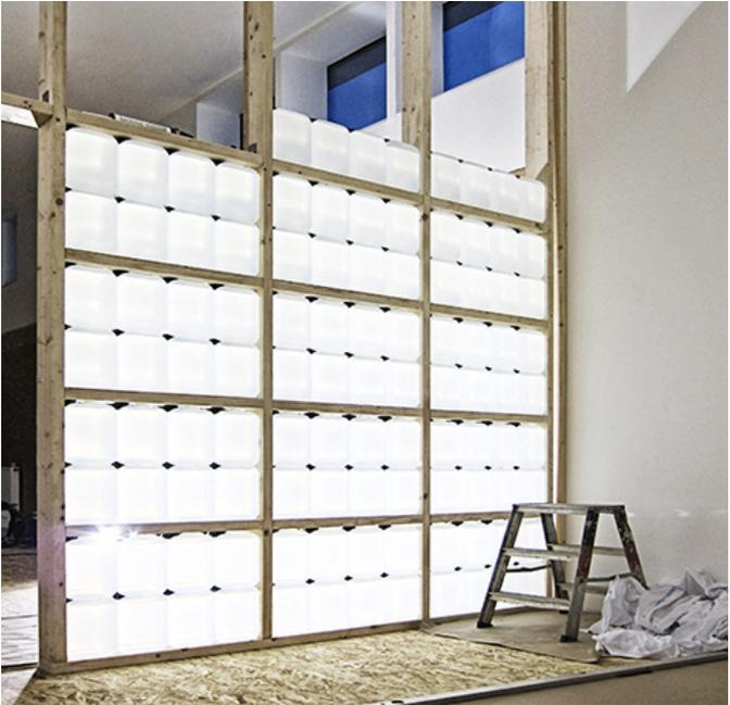
Fig.69. Sistema de energía solar pasiva
