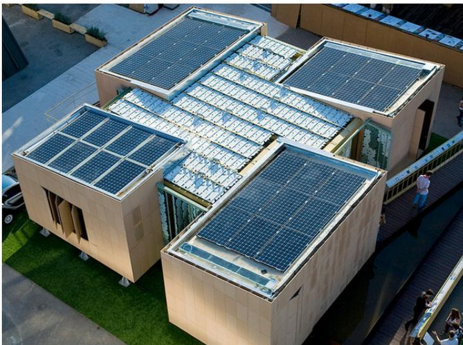
Fig.51. Cubierta del prototipo en la que se aprecian el sistema de paneles fotovoltaicos y las parras tecnológicas.
