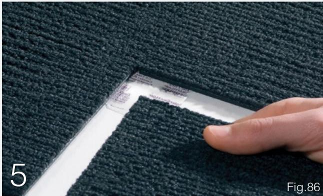
Instalación: La base de bitumen tiene una emisión baja de compuestos orgánicos volátiles (COV) y se puede instalar con un sistema adhesivo sin cola que ayuda a mantener la calidad del aire. Por otro lado, en aquellos proyectos donde se necesite un diseño más aleatorio, el uso de moquetas no direccionales significa que las losetas se pueden cortar para adaptarse a la forma de cualquier habitación, reduciendo drásticamente los residuos de la instalación.
