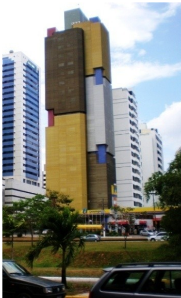
Figura 4. Finca comercial proyectada por Fernando Peixoto. (Av. ACM).
