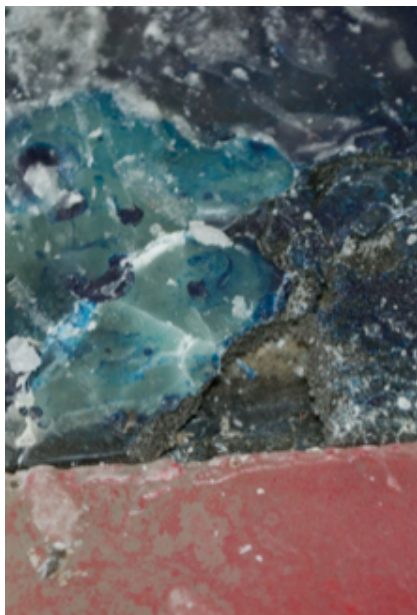
Fig. 29: Detalle del desprendimiento de la espuma de polietileno con cera.
