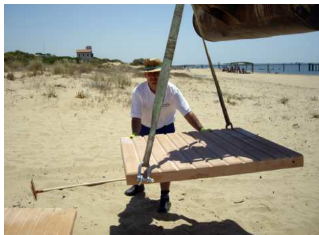
Ilustración 8 _Pasarela articulada de hormigón
