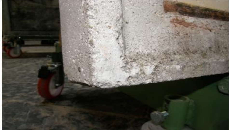
Imagen 21. Detalle de la esquina inferior izquierda.
