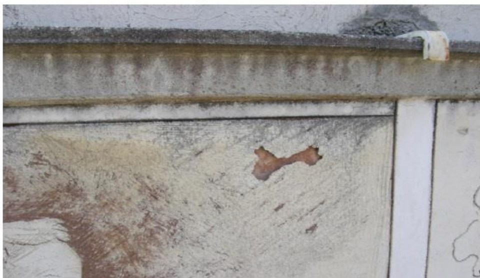
Imagen 23. Laguna antes de la preconsolidación.
