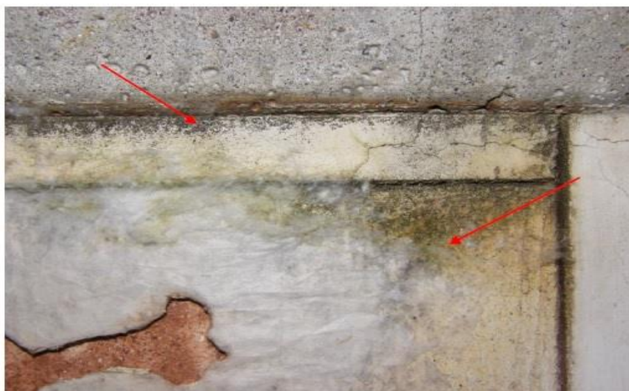
Imagen 28. Detalle del borde después de la eliminación de los empacos. Las flechas indican la reacción del Biotin.
