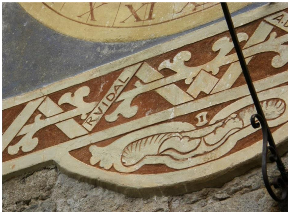
Imagen 13. Detalle del esgrafiado donde se aprecian los diferentes colores utilizados y los distintos niveles de intonaco .
