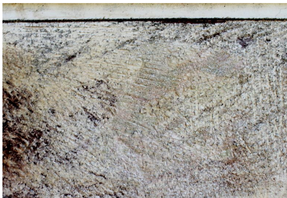
Imagen 38. Detalle de la laguna ya estucada y reintegrada.
