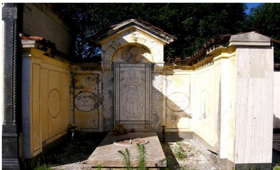
Imagen 10. Vista general de los esgrafiados en el cementerio de Miasino, Italia, realizados en 1936.
