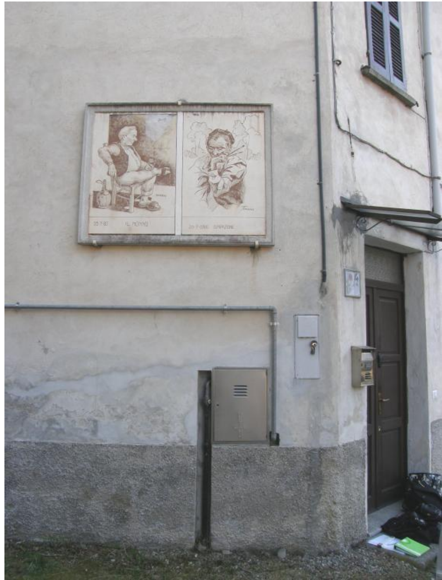
Imagen 2. Vista general de la fachada donde se ubica la obra.
