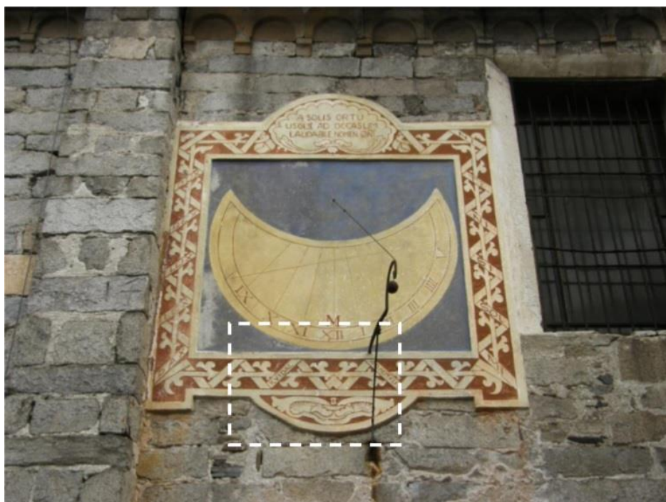
Imagen 12. Reloj de sol hecho con la técnica del esgrafiado en la iglesia de San Ambrosio, en Omegna, Italia, realizado en 1941.
