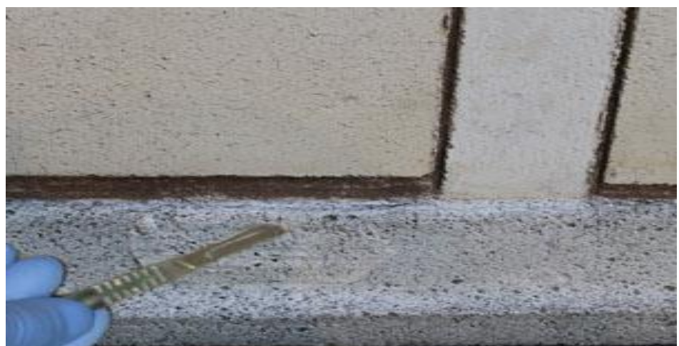
Imagen 37. Eliminación del estuco sobrante del marco.
