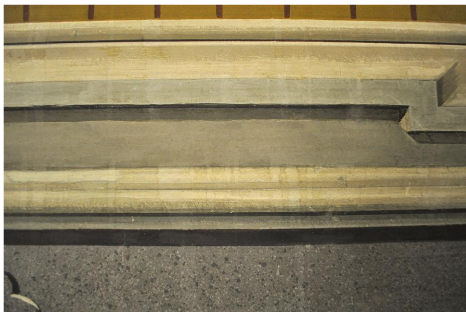
Figura 42. Manchas oscuras en la esquina de los paneles 5 y 6.
