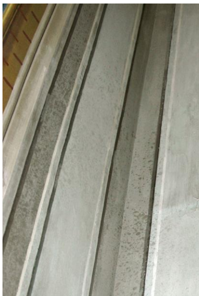
Figura 42. Manchas oscuras en la esquina de los paneles 5 y 6.
