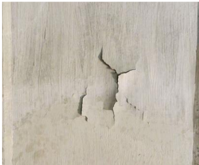
Figura 47. Manchas de decoloración en el panel 4.
