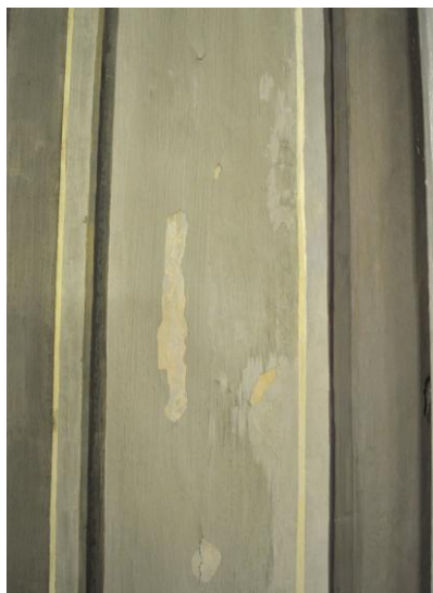
Figura 31. Grieta alrededor de la puerta.
