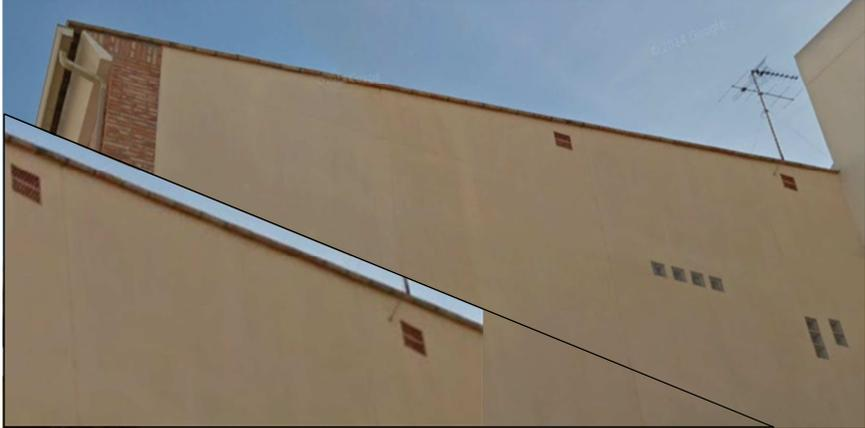
*Imagen 21. Huecos cubierta muy ventilada*
