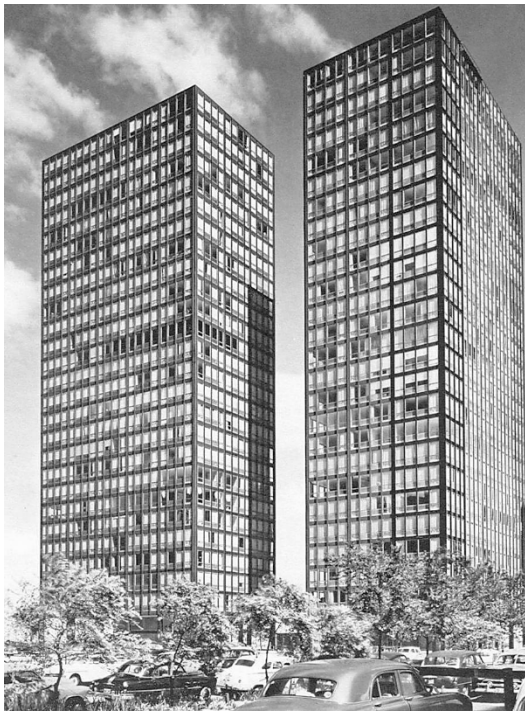
Figura 5.1. Vista de las torres en 1950.
