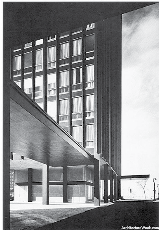
Figura 5.5. Vista de uno de los voladizos.
