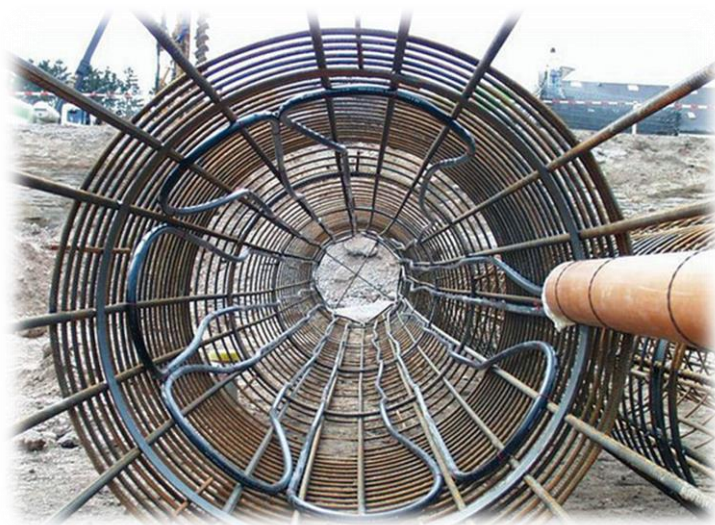
Figura 7.6. Pilote con colocación de conductos. Fuente: web34.
