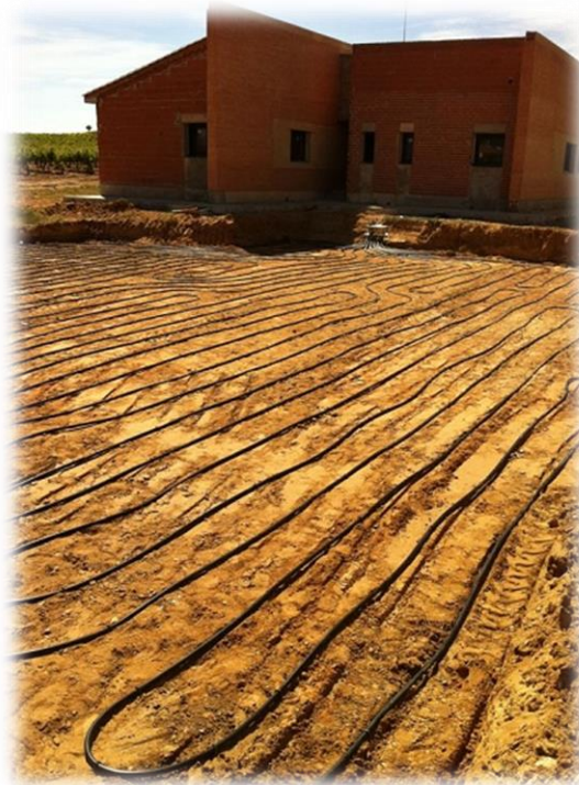
Figura 7.1. Red de captadores horizontales. Fuente: web4.
