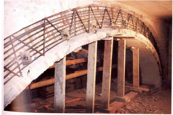
Imagen 21: El Claustro al inicio de las obras, Imagen 22: Refuerzo del arco en vestíbulo a c/Nave. Fuente: Libro Rehabilitación del edificio “La Nau”
