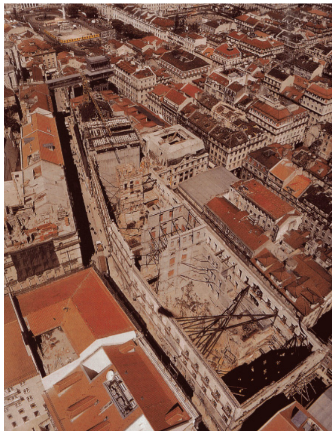
Vista aérea del la zona afectada por el incendio.
