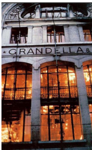
Edificio Armazém Grandella.
