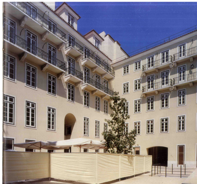
Imagen del patio interior del Bloque A.
