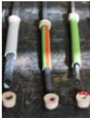
Figura 40: Preparación de moldes y barras para vertido de hormigón: tubos PVC y tapones
