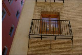
Fig. 6. Balcón de forja con barras a modo de ménsulas empotradas en el muro. Fig. 7. Roscas de ladrillo dobles y simples para la formación de dinteles.
