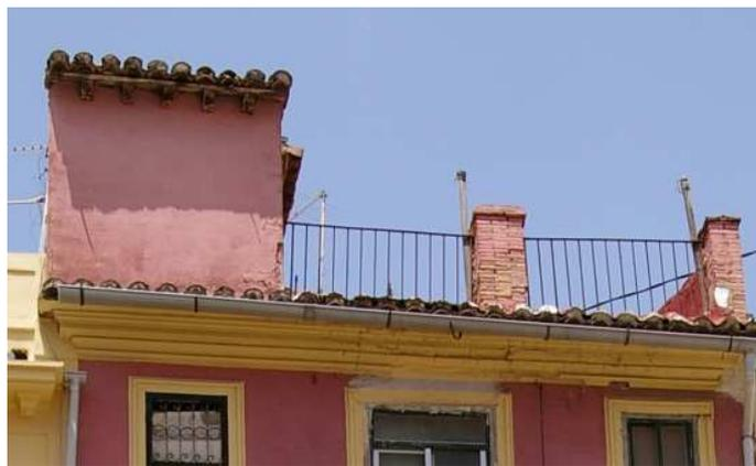
FIG. 16 Detalle de cubierta plana con antepecho de pilastras de ladrillo y barandilla metálica. (MARÍN)
