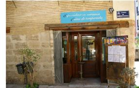
Fig. 10. Tranquero del hueco de acceso al bajo comercial del edificio.
