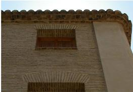
Fig. 8. Detalle de cornisa con hiladas a tizón y triscadas. Revestimiento de mortero de cal en una de las esquinas de la fachada principal.
