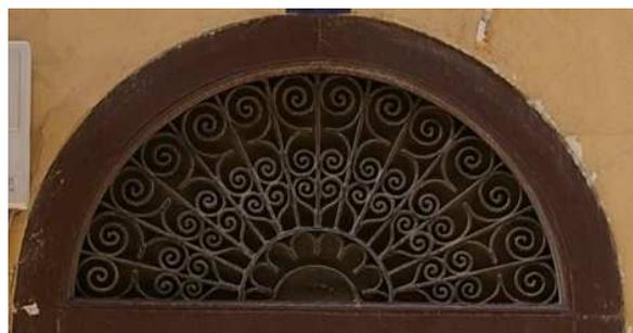
FIG. 14 Detalle de tragaluces con reja situados sobre las puertas principales de los edificios. (MARÍN)
