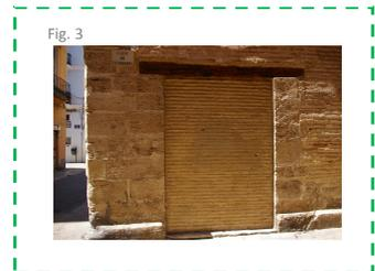
Fig. 3. Tranquero y hueco cegado de planta baja. Fig. 4. Ventana de madera, hueco recercado con mortero de cal y rosca simple de ladrillo para la formación de dintel.
