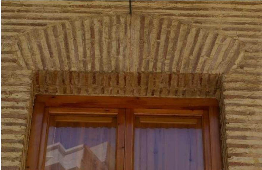
FIG. 10 Ejemplo de arco adintelado realizado con ladrillo. (MARÍN)
