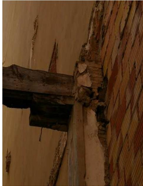
FIG.6 Muro de fachada de pie y medio de espesor. Pilastra adosada a muro de medianera (MARÍN)
