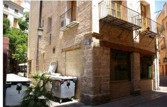
Fig. 9. Fachadas a calle del Olmo y a calle Ercilla, en las que se aprecian los tranqueros, uno de ellos cegado con ladrillo visto dispuesto como el original.
