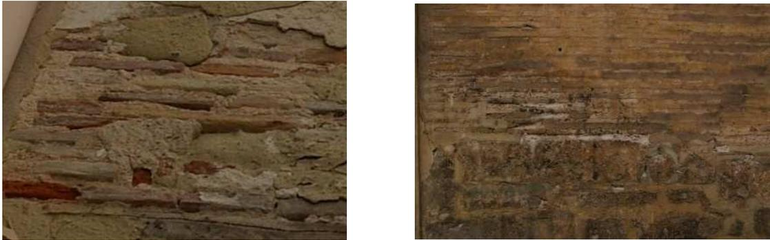
FIG.22 Detalle de muros de ladrillo con humedades, eflorescencias, escamaciones, disgregación y pulverización. (MARÍN)
