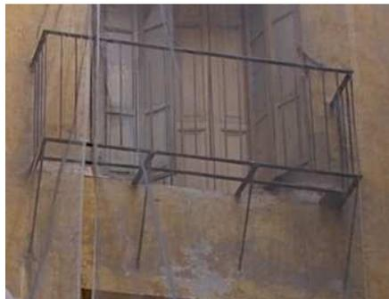
FIG.13 Detalle de dos balcones con la estructura vista y los apoyos tipo ménsula empotrados en el muro. (MARÍN)
