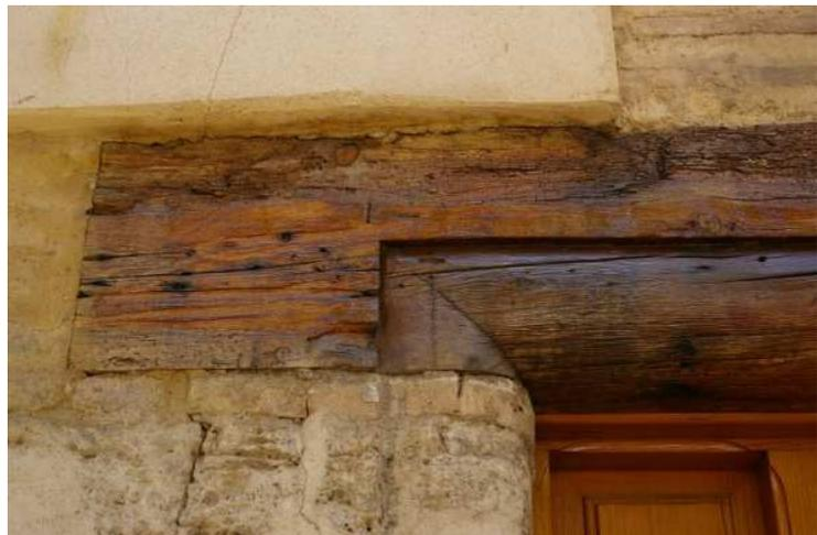
FIG. 9 Ejemplos de tranquero de madera y continuidad de los muros de piedra en las jambas y telares de los huecos de planta baja. Como se observa en la imagen la pieza de dintel es continua, sobrepasando la del hueco, y reproduce la misma forma que la jamba de piedra dándole continuidad a la parte redondeada. (MARÍN)
