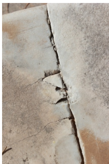
Fig. 26. Ejemplo de levantamiento del pavimento que ha provocado la rotura de las baldosas. (Fotografía de autor)
