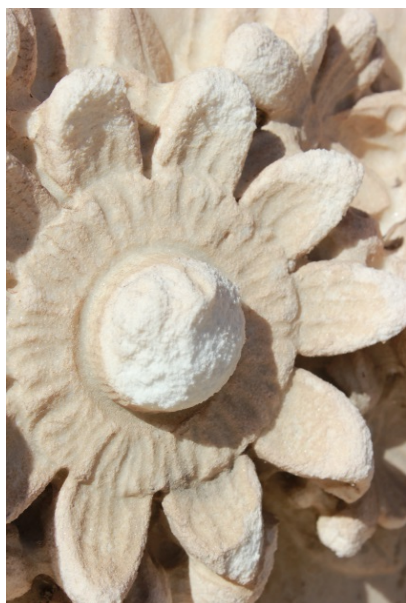
Fig. 36. Ejemplo de eflorescencias en superficie que han provocado la pérdida de formas. (Fotografía de autor)
