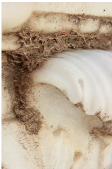
Fig. 33. Ejemplo de depósito de tierra y polvo. (Fotografía de autor)
