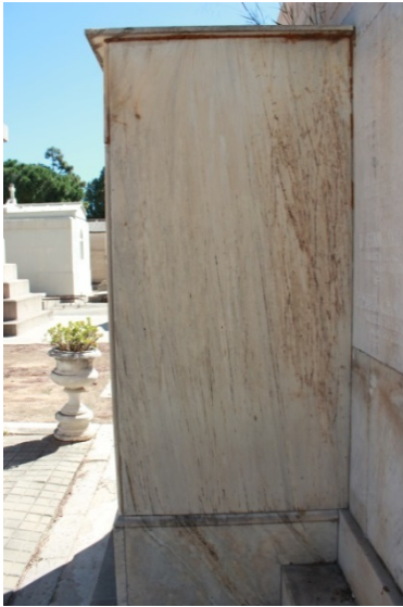
Fig. 48. Ejemplo de abrasión de la superficie por una mala metodología de trabajo. (Fotografía de autor)
