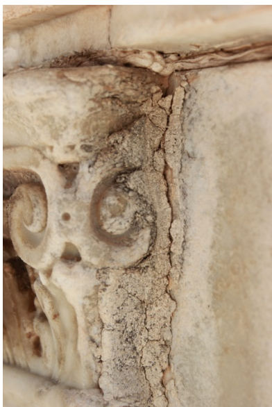
Fig 46 y 47. Ejemplos de aplicación incorrecta de los materiales de reparación. (Fotografía de autor)
