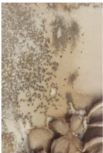
Fig. 40. Ejemplo de erosión de la superficie marmolea. (Fotografía de autor)
