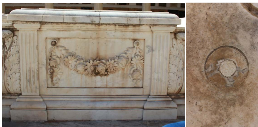
Fig. 24. Ejemplo de combamiento en una de las lápidas que cubren uno de los sarcófagos principales. (Fotografía de autor)
