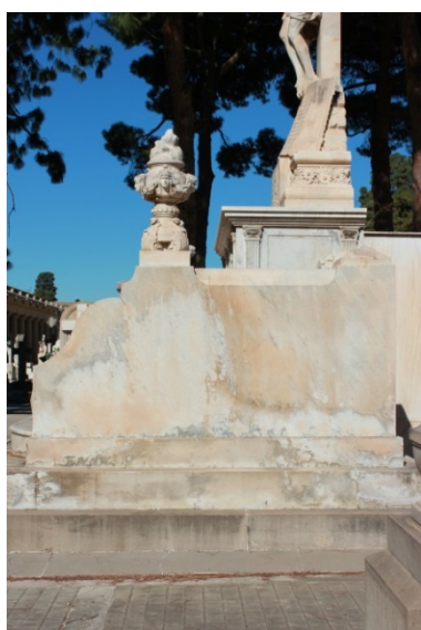
Fig. 28. Ejemplo de Mancha de humedad con microorganismos. (Fotografía de autor)
