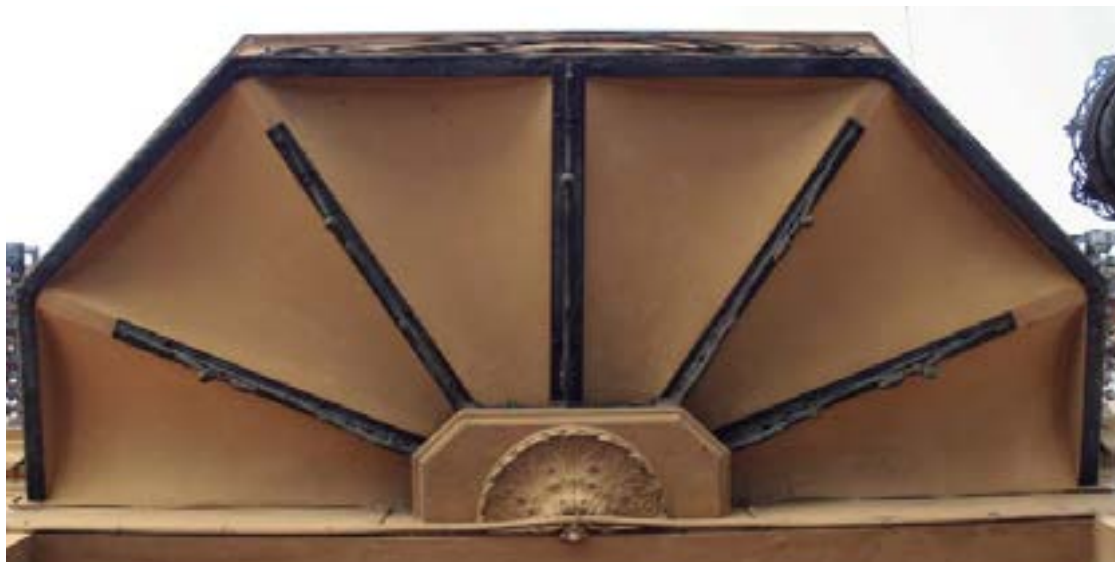
Fig. 8.125 Estructura de sostén del piso volado. Mirador de la casa n.2 de Plaza San Lorenzo, (PP)
