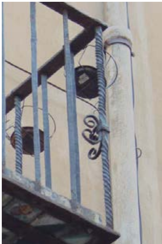
Fig. 8.38 Barrote entorchado. Edificio Cat. CA-99.(PP)
