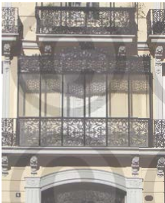
Fig. 8.68 Balcones con módulos cuadrados de fundición. (PP)
