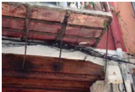
Fig. 8.95 Tornapuntas con solución diferente de agarre a la fachada. Edificio cat. XE-64.
