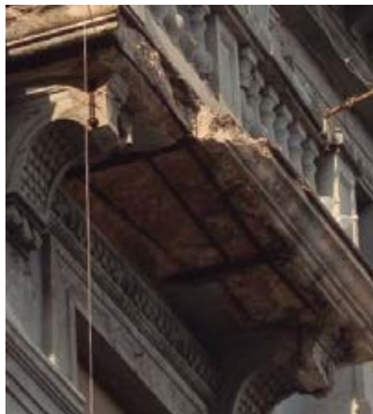
Fig. 3.35 Detalle de la disposición de los hierros en estructuras de hormigón en Teniente Rey. La Habana, Cuba. (PP)
