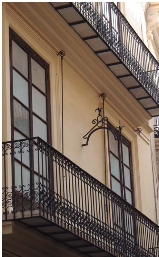
Fig. 1.22 Bastidores para cortinas de exterior, Valencia.
