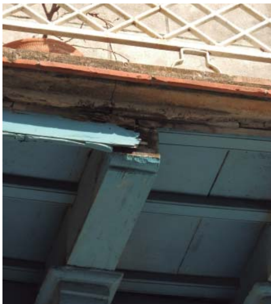
Fig. 3.33 Detalle del tapaboca utilizado en los modelos de madera habaneros
