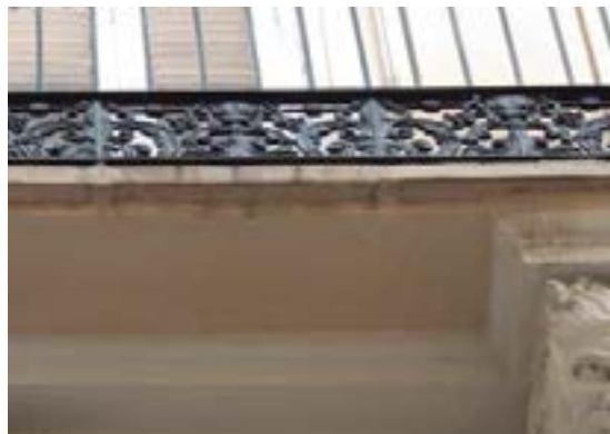
Fig. 8.8 Detalle del sobabalcón con jaula partida y viguetas voladas embebeidas. (PP)
