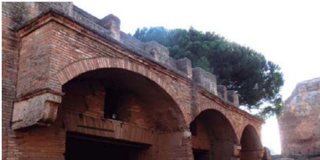
Fig. 2.3 Balcones sobre canes de travertino en el Thermopolium de la via de Diana, Ostia Antigua. (PP)
