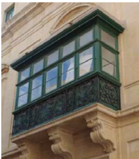
Fig. 1.44 Mirador instalado por el interior del balcón. La Valletta. (PP)
