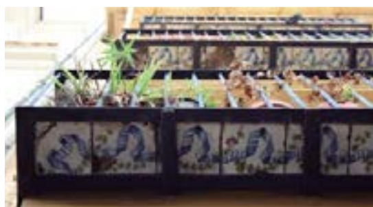
Fig. 7.15 Sotabalcón del edificio catálogado XA-31. (PP)
