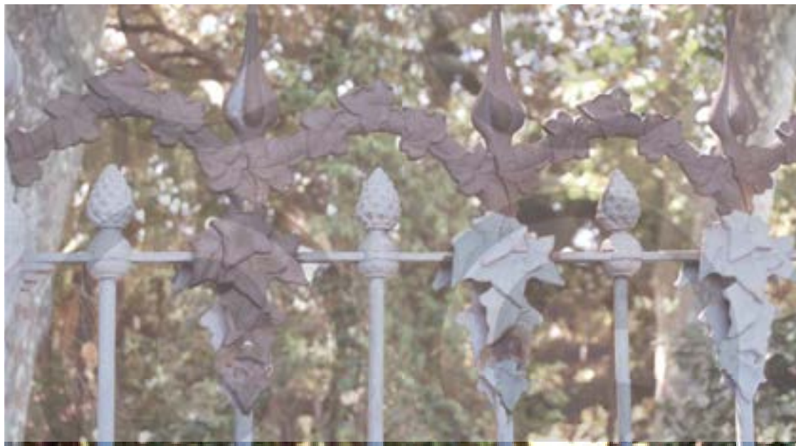
Fig. 7.66 Verja de jardín con piezas decoraciones de fundición elaboradas a partir de los elementos remanentes. (Antica Fonderia Siciliana)
