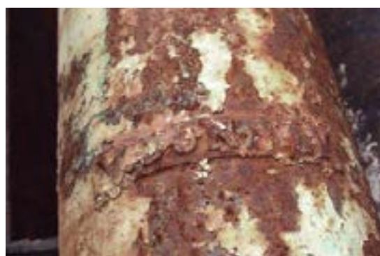
Fig. 7.45 Marca del taller Donnay en una columna de hierro fundido (PP)
