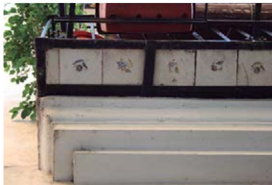
Fig. 8.83 Módulo cerámico en el extremo del vuelo del balcón. (PP)
