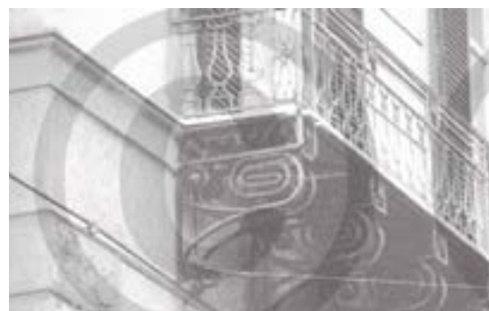
Fig. 1.18 Ménsulas de hierro en forma simulando las formas de las de piedra. Palermo. (Fatta)
