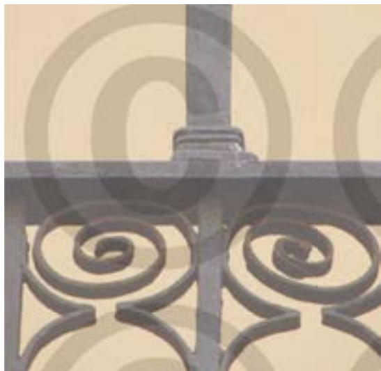
Fig. 8.108 Riostra alta conectada al barrotes inferior. (PP)
