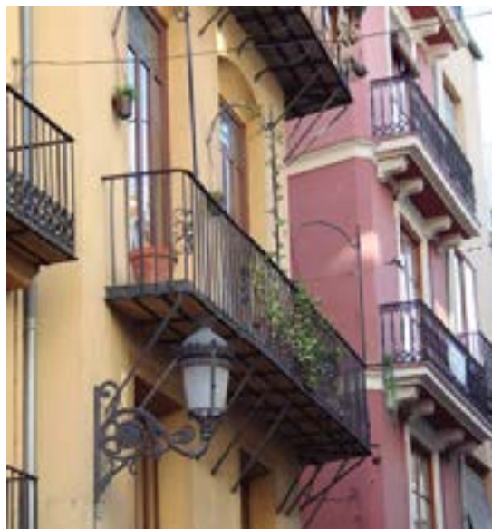
Fig. 9.25 Balcón esquineo de la primera planta de la casa n.1 de calle de las Monjas. (PP)
