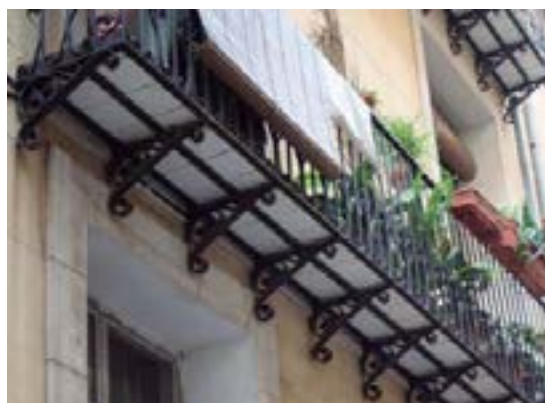
Fig. 8.103 Ménsulas triangulares en hierro de forja.
