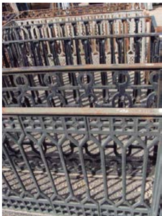
Fig. 8.59 Ccara interna de varios antepechos de fundición. (PP)
