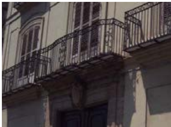
Fig. 2.64 Balcones del palacio de los Marqueses de Montortal, Valencia. (PP)
