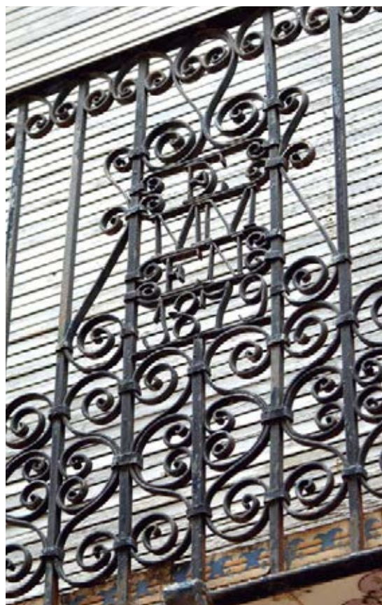
Fig. 7.61 Antepecho con decoración ensamblada con ligaduras. Cintorres, Maestrazgo. (PP)
