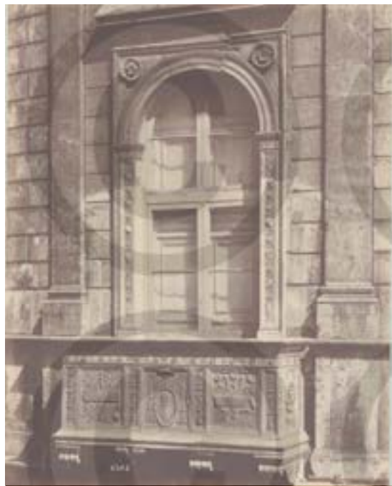
Fig. 2.33 Balcón del torreón sur, Palazzo della Cancelleria, Roma (Alinari)
