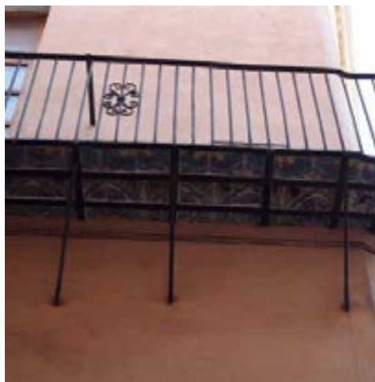
Fig. 9.24 Tramo lineal del balcón de calle Corregería, 42. (PP)
