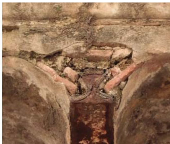
Fig. 3.31 Detalle de la solución constructiva con vías ferroviarias. en lugar de perfiles estandar. (PP)
