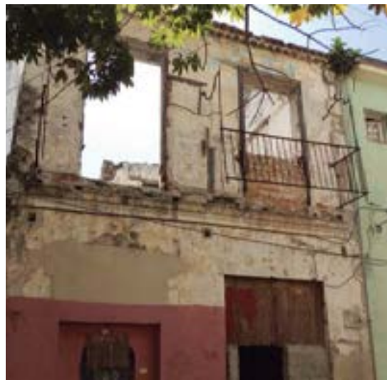
Fig. 3.24 Fachada de la casa en San Isidro 158. (PP)
