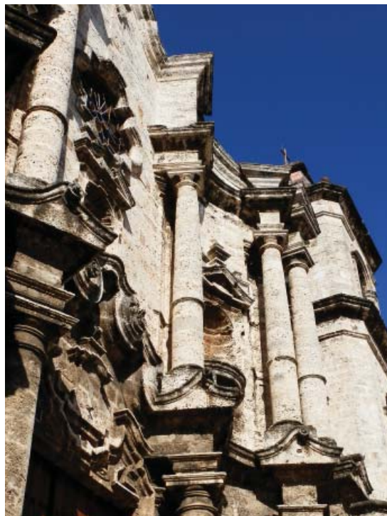
Fig. 3.10 Detalle de la fachada de la catedral de La Habana. (PP)
