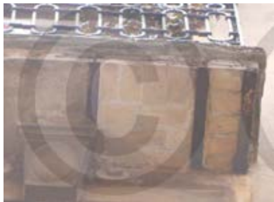
Fig. 8.92 Vuelo con hierro y rasillas. Cat. ME-43. (PP)
