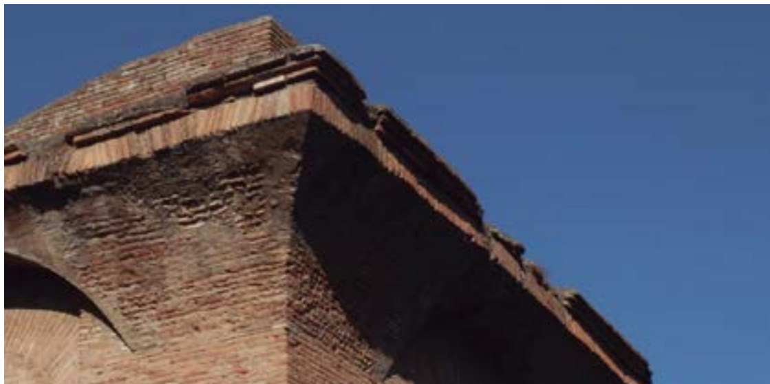
Fig. 2.5 Detalle de la esquina reconstruida del balcón esquinero del edificio en esquina entre via de Diana y via dei Balconi. (PP)
