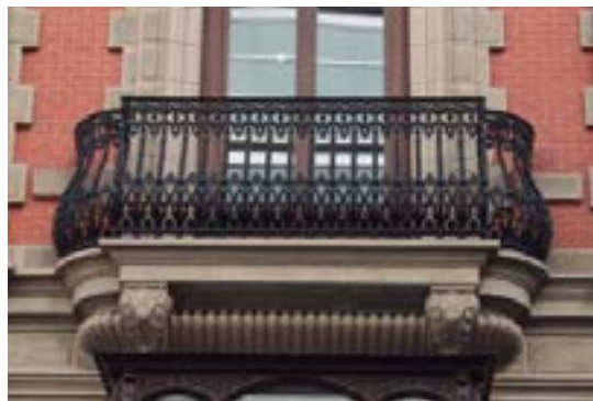
Fig. 9.50 Balcón individual del edificio n.30 de calle Roger de Lauria. (PP)
