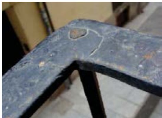
Fig. 7.63 Esquina del pasamanos de un balcón del centro de Valencia obtenida con la soldadura a fuego de dos pletinas. (PP)
