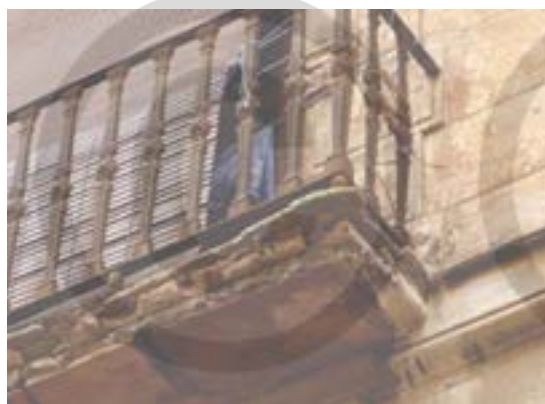
Fig. 8.91 Vuelo de viguetas y lasjas de rodeno. (PP)
