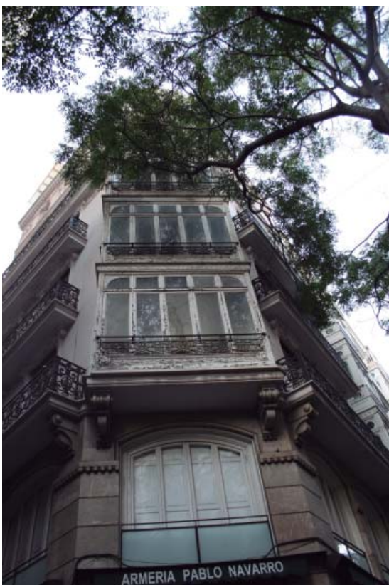
Fig. 8.128 Chaflán de edificio n. 2 en calle San Fernando. (PP)
