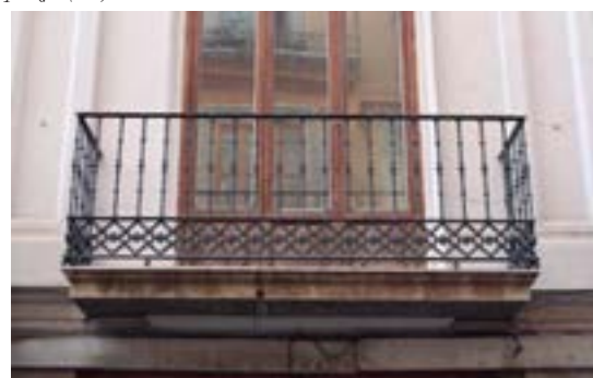
Fig. 8.70 Balcón individual con antepecho de fundición con doble nivel horizontal. (PP)
