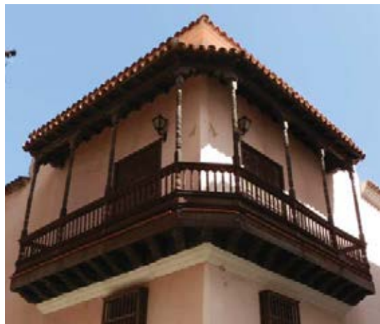
Fig. 3.8 Balcón de la casa esquina Obrapia y San Ignacio. (PP)
