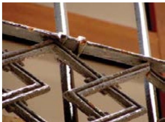
Fig. 8.50 Detalle de la abrazadera de agarre de los módulos de fundición de decoración postiza. (PP)
