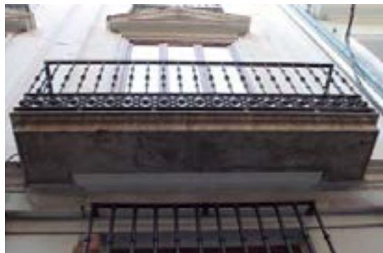
Fig. 8.87 Balcón con vuelo de piedra dividido en dos bloques. Edificio cat. CA-118. (PP)
