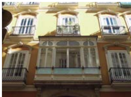
Fig. 8.122 Fachada de la casa n.15 de calle Comedias.
