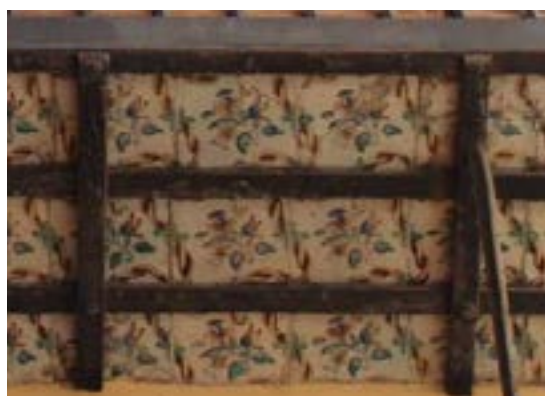
Fig. 7.8 Sotabalcón del edificio catalogado V -254. (PP)
