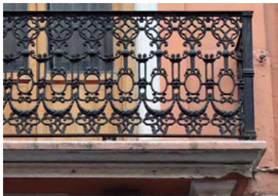
Fig. 9.47 Detalle del balcón del edificio n.20 de calle de Quart. (PP)
