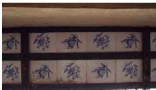
Fig. 7.16 Sotabalcón del edificio catálogado XE-65. (PP)
