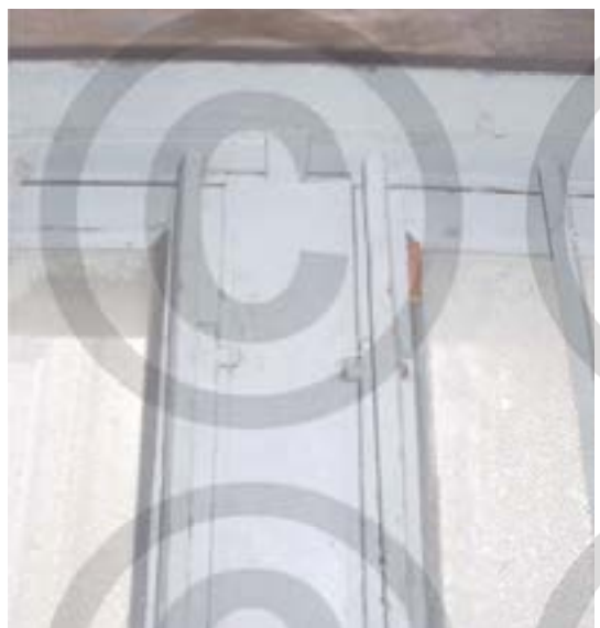
Fig. 8.118 Detalle del enlace entre el antepecho del balcón y el travesaño hiroznatal superpuesto. (PP)
