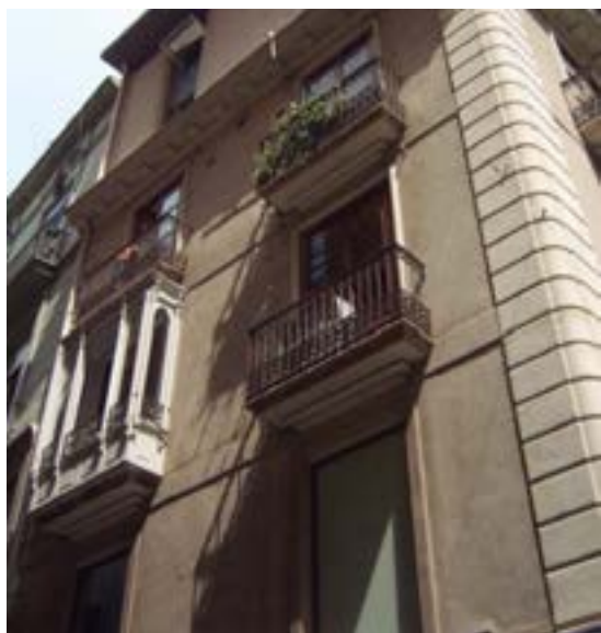
Fig. 8.114 Mirador añadido con eliminación del antepecho del balcón preexistente. (PP)
