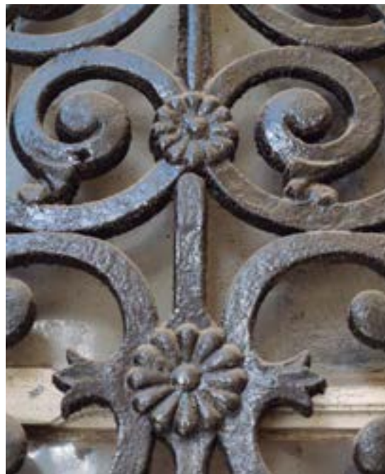
Fig. 8.69 Detalle que demuestra la realización en fundición de las piezas. (PP)
