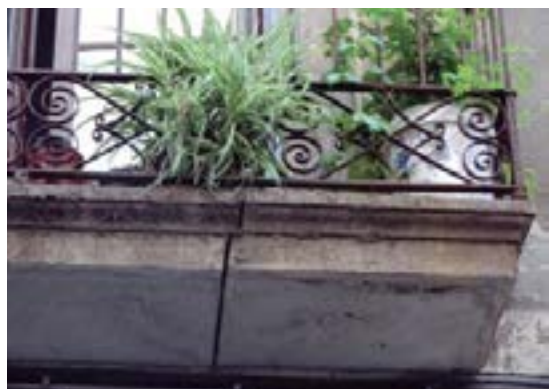
Fig. 8.88 Vuelo de piedra en Barcelona con solución adintelada.
