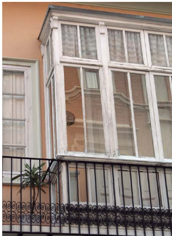
Fig. 8.116 Mirador añadido en el interior de un balcón corrido.
