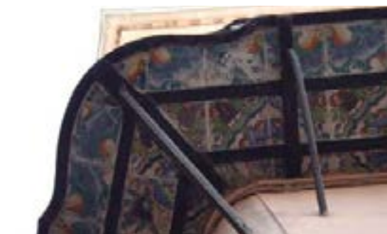
Fig. 8.79 Esquina mixtilínea. Balcón edificio MB-80. (PP)
