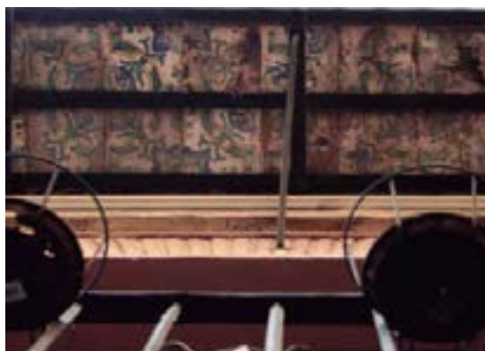
Fig. 7.4 a Sotabalcón del edificio catalogado V -104. (PP)
