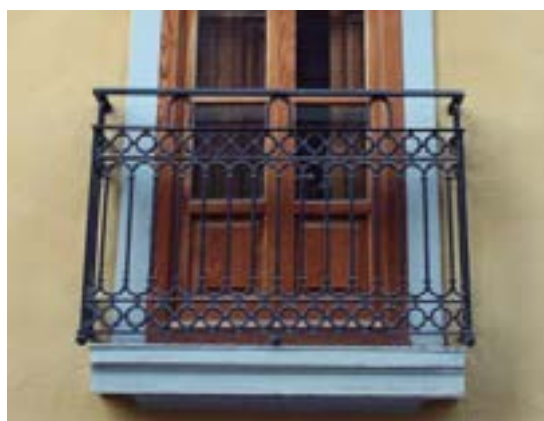
Fig. 8.11 Balcón reducido de baranda y solera.
