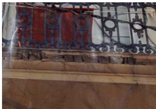
Fig. 8.90 Vuelo con estructura de hormigón. Cat. XG-60. (PP)
