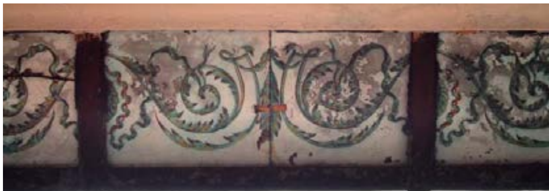
Fig. 7.11 Sotabalcón del edificio catálogado XE-18.(PP)
