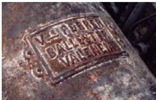
Fig. 7.46 Marca del taller Ferrer Ballester en una columna de hierro fundido. (PP)
