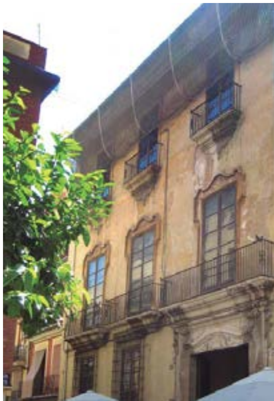
Fig. 9.40 Fachada del Palacio Lassala (PP)
