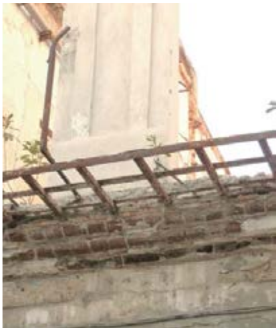
Fig. 3.32 Esqueleto del balcón en Teniente Rey, 23 (PP)
