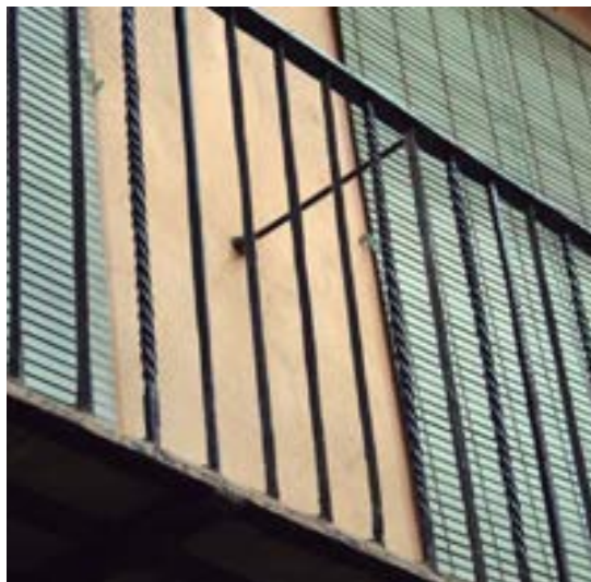
Fig. 8.104 Riostra a nivel. Edificio cat. MA-16. (PP)
