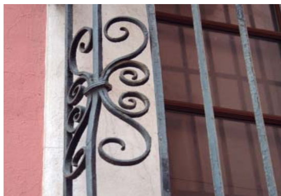
Fig. 8.42 Lazos de cuatro brazos. Edificio Cat. V-173.(PP)
