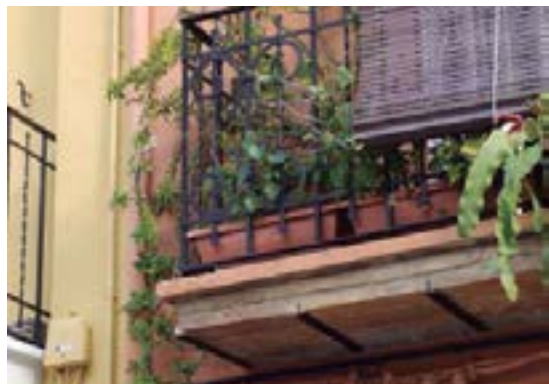
Fig. 8.93 Vuelo de rasillas apoyadas, Calle Juan Castelló, Ex-tramuros
