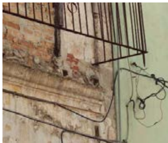
Fig. 3.25 Detalle del espigón del antepecho. (PP)
