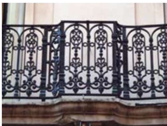
Fig. 8.73 Módulos de fundición especiales para quiebros. (PP)
