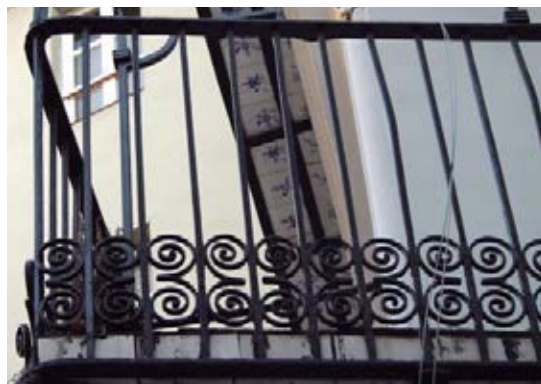
Fig. 9.37 Detalle de la decoración al pie de la baranda, calle Bolsería 42
