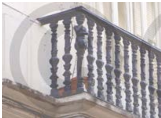
Fig. 8.57 Antepecho con pasamanso de fundición superpuesto. (PP)
