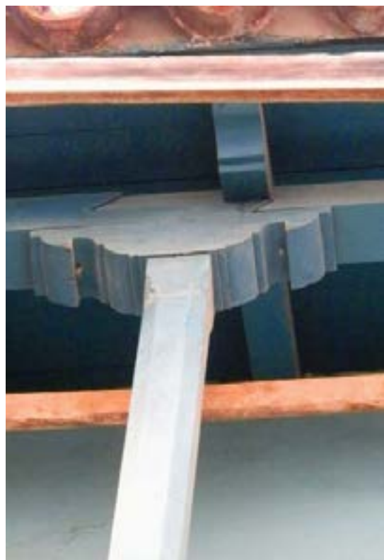
Fig. 3.13 Detalle del empalme a rayo de Jupiter de la techumbre del balcón de San Ignacio 314. (PP)
