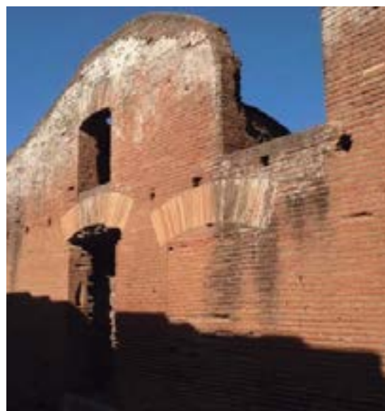
Fig. 2.2 Mechinales de los balcones de la Via di Diana, Ostia Antigua. (PP)
