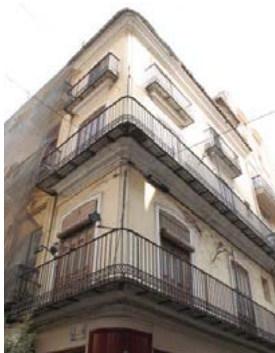
Fig. 9.32 Balcones de la casa en calle del Mar, 15. (PP)
