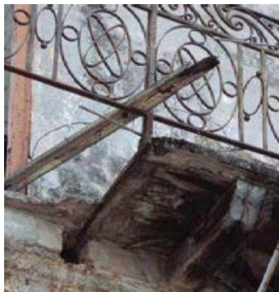
Fig. 3.26 Estructura descompuesta del balcón. Esq. Santa Clara y San Ignacio. (PP)
