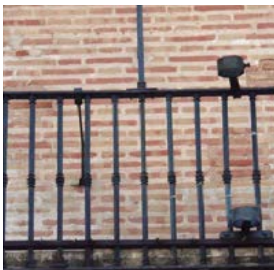
Fig. 8.107 Enlace atornillado de la riostra alta. Casa Vestuario. (PP)
