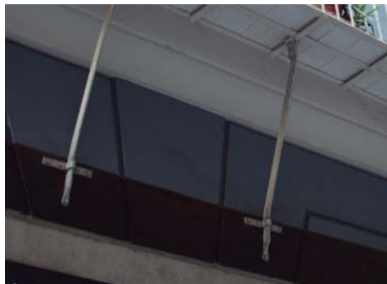
Fig. 8.101 Tornapuntas clavadas. Edificio Cat. ME-159.
