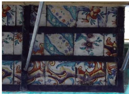
Fig. 7.10 Sotabalcón del edificio catalogado V -109. (PP)
