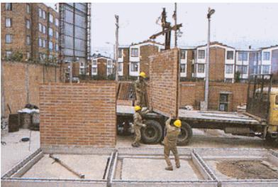
Imagen del sistema industrializado Losas LTDA.
