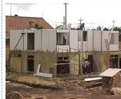
Imagen de construcción utilizando paneles EVG-3D.
