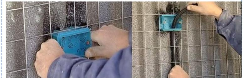
Imágenes de la colocación de las tuberías en el panel.
