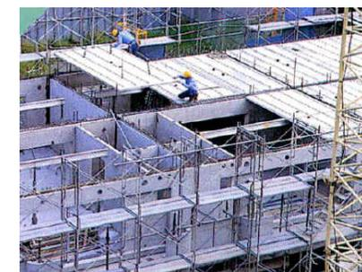
Imagen del Sistema de Paneles I.C.
