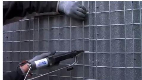
Imágenes del corte de la malla para la colocación de las tuberías.
