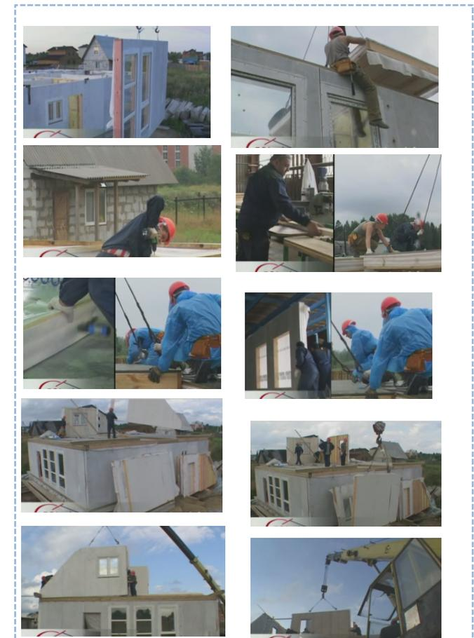
Imágenes del proceso de inicio a fin de construcción modular en madera con sistema de panel sandwich
