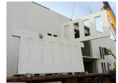
Paneles prefabricados de Hormigón.
