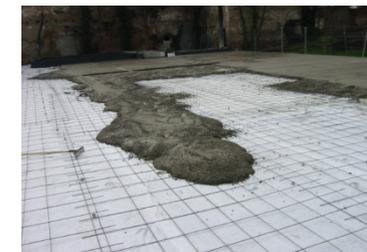
Imagen de Capa de Hormigón Mallazo, para el pavimento.
