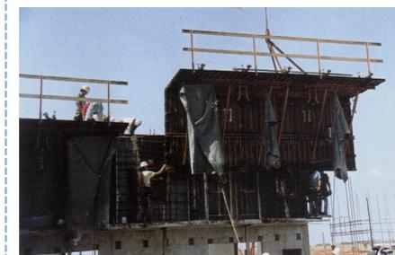
Imágenes de construcción utilizando Formaleta metálica- Sistema Industrializado Outinord.
