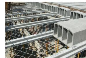
Imagen de Bovedilla Prefabricada de Hormigón.
