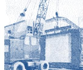
Utilización de grúa para el montaje de un panel de concreto, 1950.
