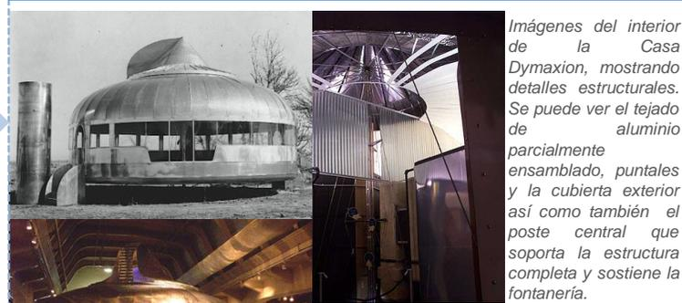
Imágenes del interior de la Casa Dymaxion, mostrando detalles estructurales. Se puede ver el tejado de aluminio parcialmente ensamblado, puntales y la cubierta exterior así como también el poste central que soporta la estructura completa y sostiene la fontanería.
