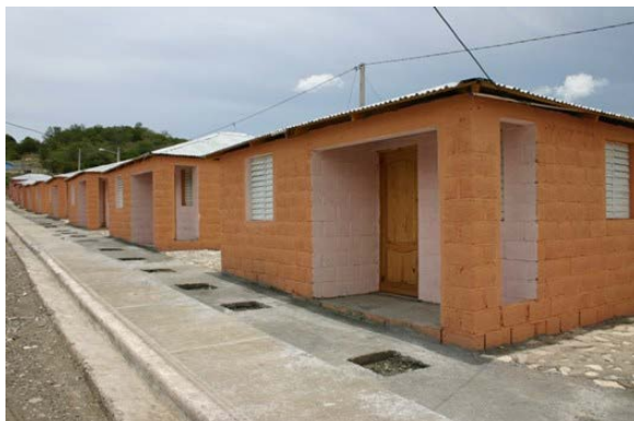
Viviendas Unifamiliares construidas en El Cerro, Peravia Fuente: http://invi.gob.do/Galer%C3%ADa.aspx
