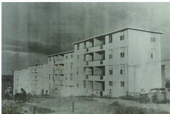
Multifamiliar La Fuente
