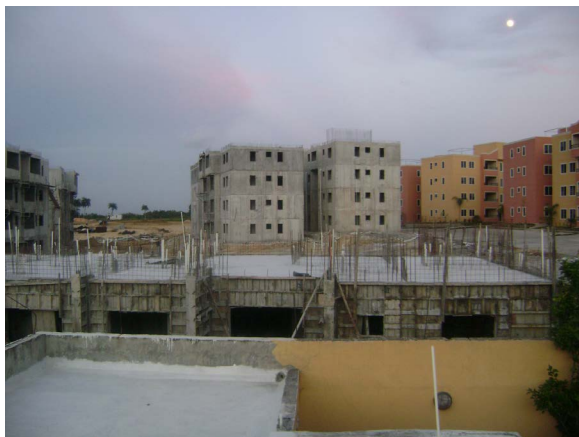
Viviendas Económicas en Construcción
