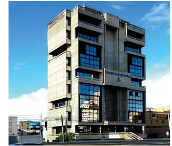
Edificio Corominas Pepín, 1986 Fuente: Foto Jochi Marichal (Historias para la construcción de la Arq. Dom)
