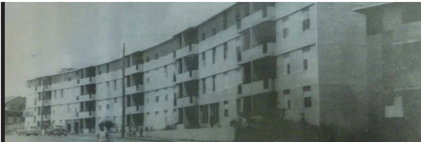
Edificio Pantalla en Marahambre
