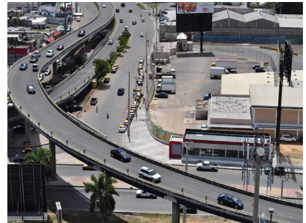
Elevado de la Av. Winston Churchill
