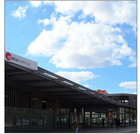
Exterior Estación Marítim-Serreria. PDMD.
