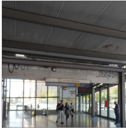
Exterior Estación Marítim-Serreria. PDMD.
