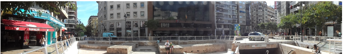
Imagen 61. Vista Panorámica Exterior Estación Colón.
