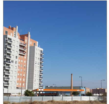
Imagen 92. Entorno Estación Empalme. PDMD.
