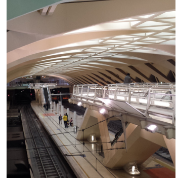
Imagen 104. Interior Estación Alameda.
