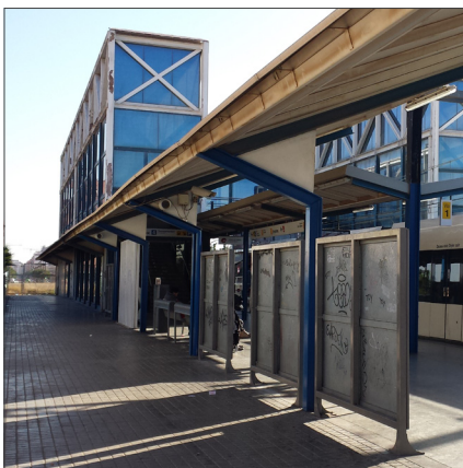
Imagen 93. Estación Empalme. PDMD.
