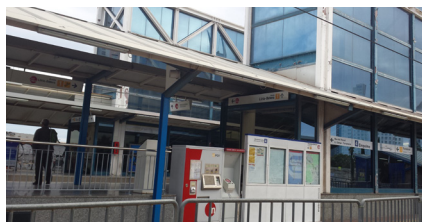
Imagen 82. Estación Empalme. PDMD.
