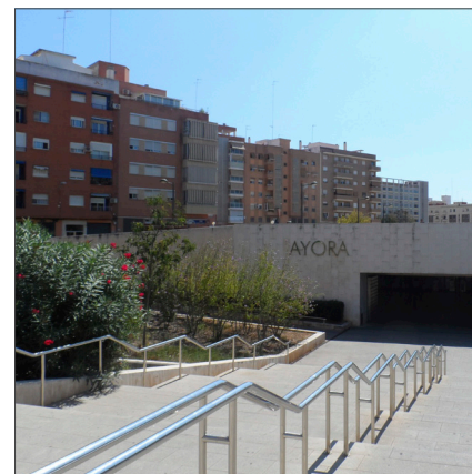
Imagen 156. Acceso Estación Ayora. PDMD.
