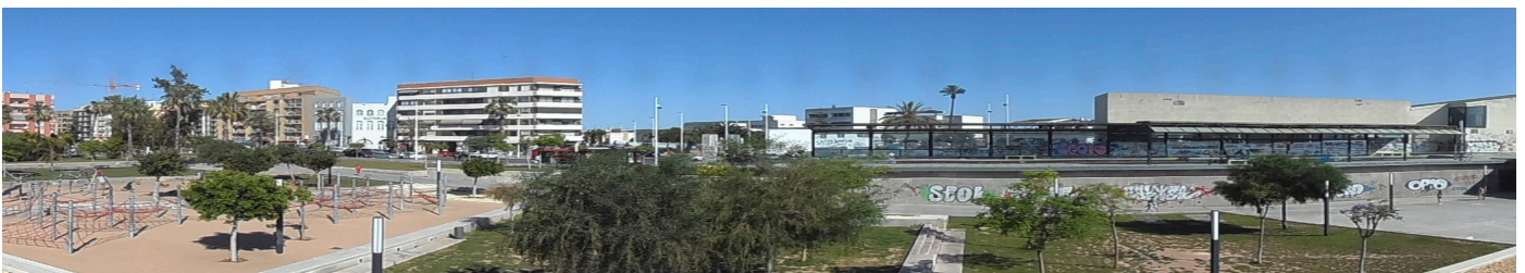
Imagen 141. Vista Panorámica Entorno Estación Alboraya-Palmaret. PDMD.
