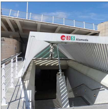
Imagen 119. Acceso Estación Alameda. PDMD.
