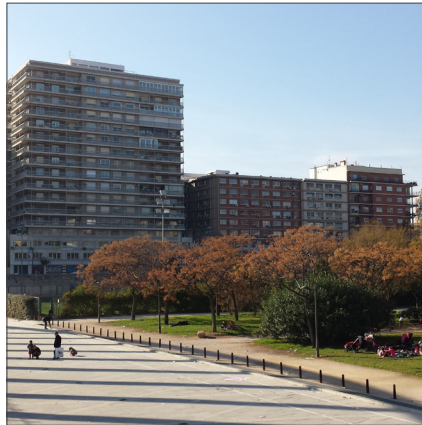
Imagen 117. Estación Empalme. PDMD.
