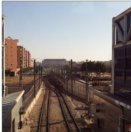
Imagen 91. Estación Empalme. PDMD.
