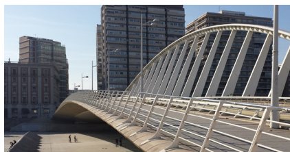
Imagen 106. Acceso Estación Alameda. PDMD.
