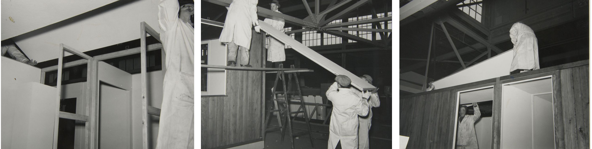
23. Montaje de paneles de cubierta
