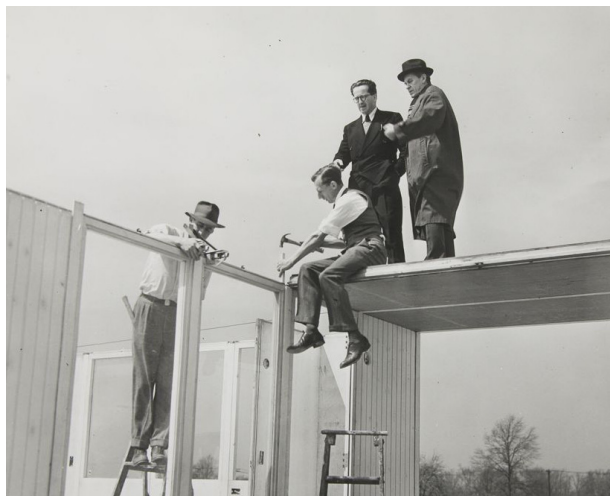
Fig.10. Gropius y Wachsmann dirigiendo en Long island una de las primeras realizaciones experimentales por el sistema Packaged House, 1942
