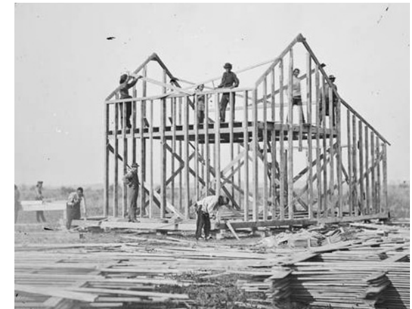
Fig. 17. Hombres trabajando en la vivienda con Balloon Frame, Nebraska, 1877
