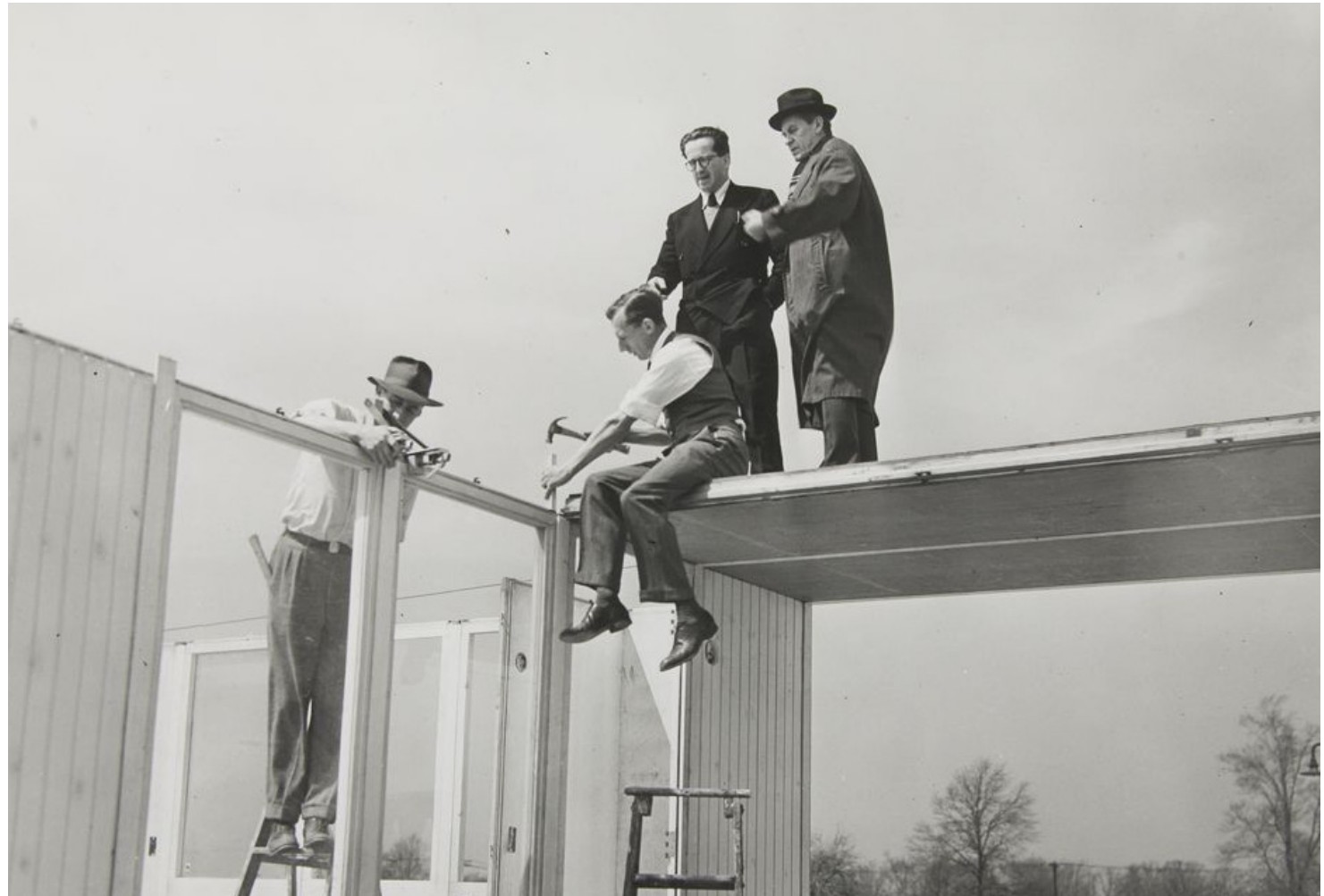
Fig.25. Fundación, Construcción fase 1
