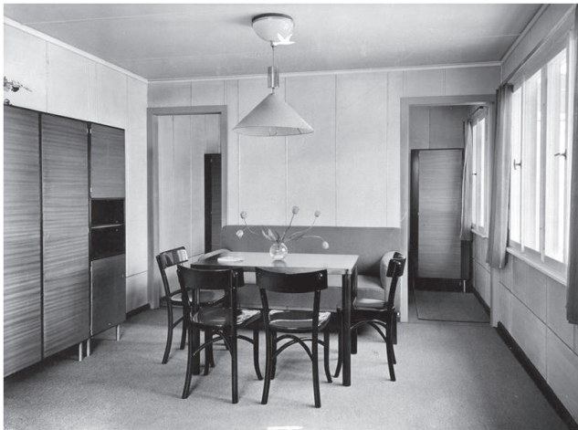
Fig. 19. Interior de Packaged house , Gropius y Wachsmann.1942.
