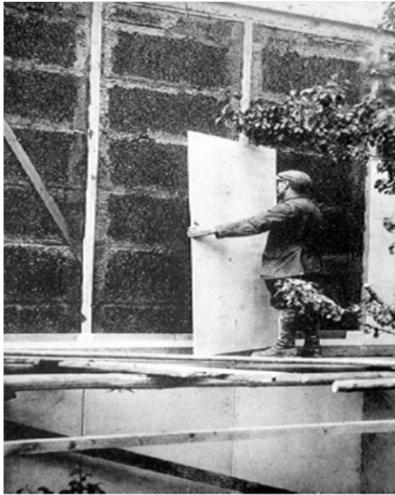
Fig. 12 Sobre este esqueleto se atornillan listones de madera a los cuales se le fija el recubrimiento exterior, consistente en una lámina de asbesto de 6 mm x 1,20 cm x 2,50 cm. No hace falta utilizar ningún tipo de revestimiento.
