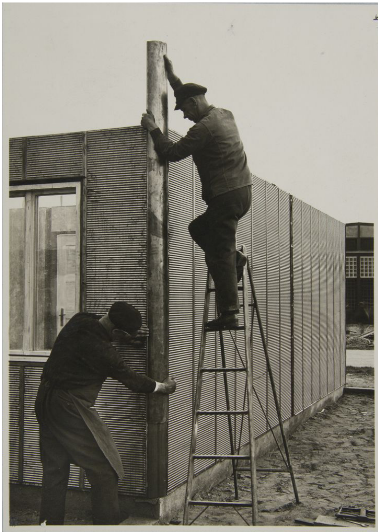
Fig. 21 Montaje de una de las Casas que crece, Berlín, Walter Gropius, 1931
