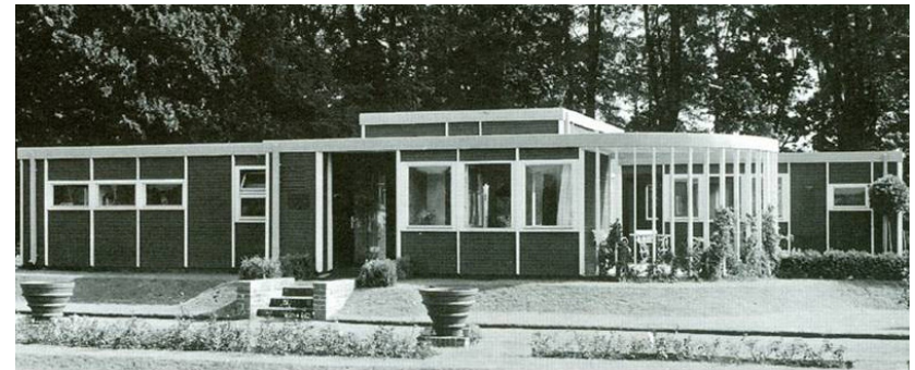
Fig.3. Casa construida utilizando el sistema de paneles tipo Cristoph y Unmack,Hans Scharoun,1927
