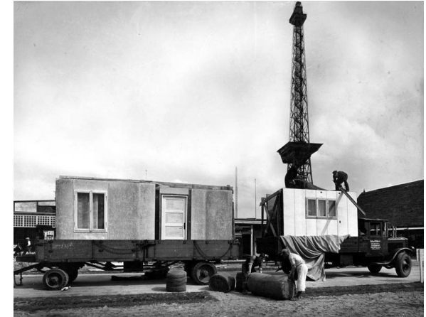
Fig. 16. Transporte para Montaje de casa de Cobre, Walter Gropius, 1931
