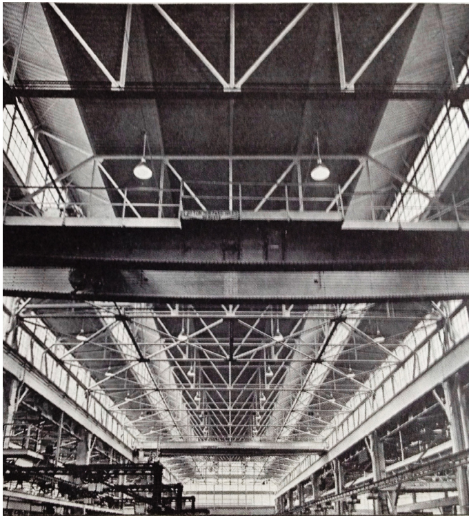
Figura 41. Estructura prefabricada de acero en naves industriales (The Architectural Forum, Noviembre 1940)
