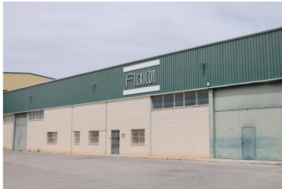
Figura 1. Fachada de la nave
