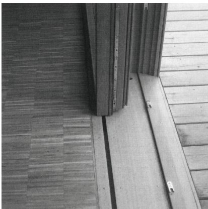
Fig. 5.3. Es preciso evitar cualquier cambio de nivel en el pavimento, tanto en una misma estancia como en la transición entre dos de ellas. Esto es igualmente válido entre zonas interiores y exteriores.
