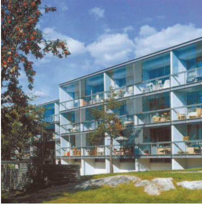
Fig. 5.89. Claus & Kaan Architekten: 081 Housing Vier Ambachten, Spijkenisse, Países Bajos. El balcón ha de garantizar el espacio suficiente para la colocación de ciertas piezas de mobiliario.
