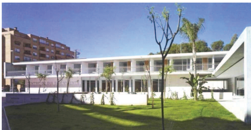
Fig. 4.3. Javier García-Solera Vera: Viviendas tuteladas y centro de día , San Vicente del Raspeig, Alicante, 2006. Los servicios comunes pueden formar parte del posible centro de día anexo a las viviendas.
