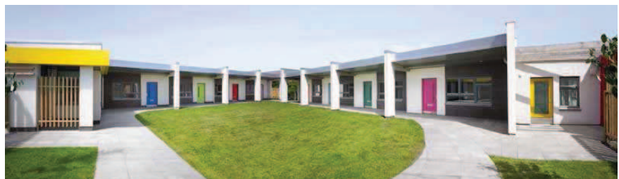
Fig. 5.45. Chris Stewart Architects: Croftspar Place , Glasgow, Scotland, 2005. En esta residencia para personas con Alzheimer se emplea el color para identificar las puertas de las distintas viviendas.
