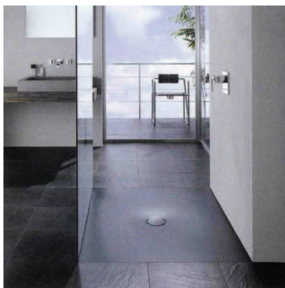
Fig. 5.83. Deberán de sustituirse las cortinas y mamparas móviles por mamparas fijas.
