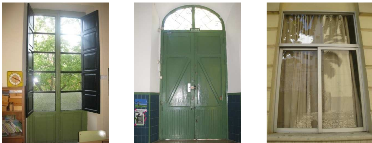
Figura 20. Carpintería exterior edificio principal. Fuente propia.
