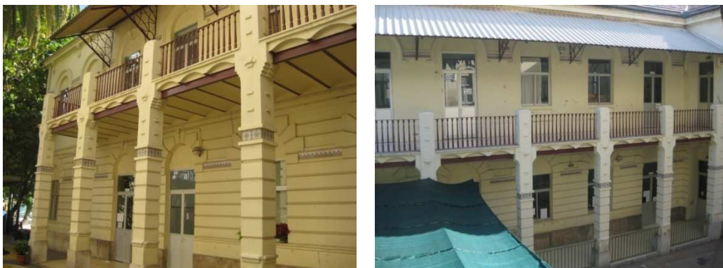
Figura 16. Porches. Fuente propia.
