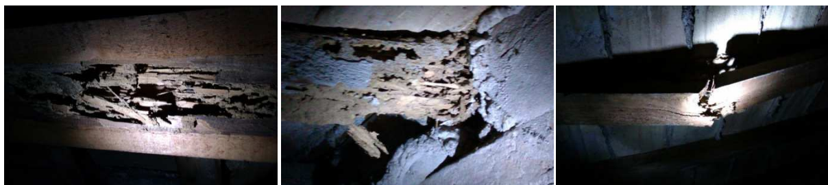
Figura 3. Imágenes de la cubierta inspeccionada. Fuente: Begoña Serrano Lanzarote.
