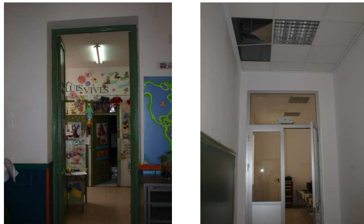
Figura 21. Particiones interiores. Fuente propia.
